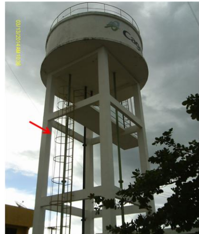
Foto 48 – REL-01: escada de acesso com guarda-corpo.
