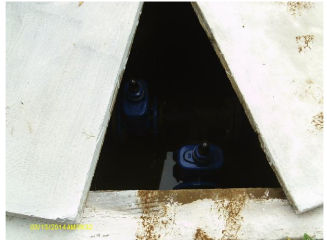
Foto 26 – Caixa de registro localizado na chegada da ETA.
