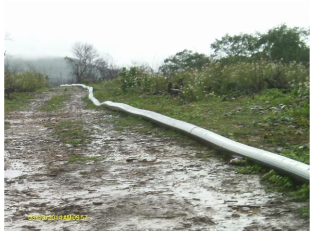
Foto 8 – Adutora em implantação do Açude Taquara.
