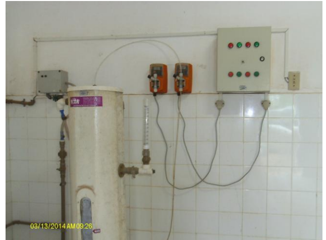
Foto 19 – Sistema de fluoretação.
