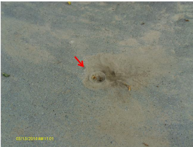
Foto 61 – Registro de descarga na Rua Raimundo Ferreira Gomes.
