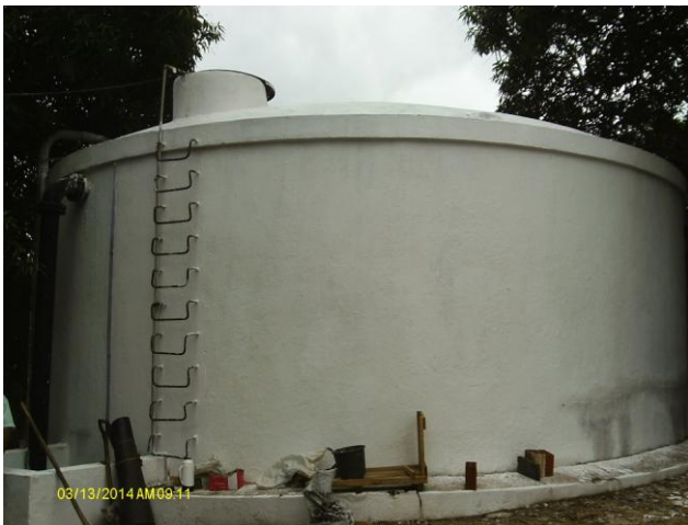
Foto 43 – RAP-01: escada de acesso.
