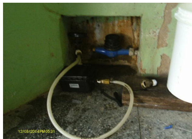
Foto 58 – Medição de pressão com instalação às 17:40h do dia 12/03/14 e retirada às 17:40h do dia 13/03/14, com aparelho datalogger na Rua Dep. Fernando Melo (escritório de atendimento da CAGECE).
