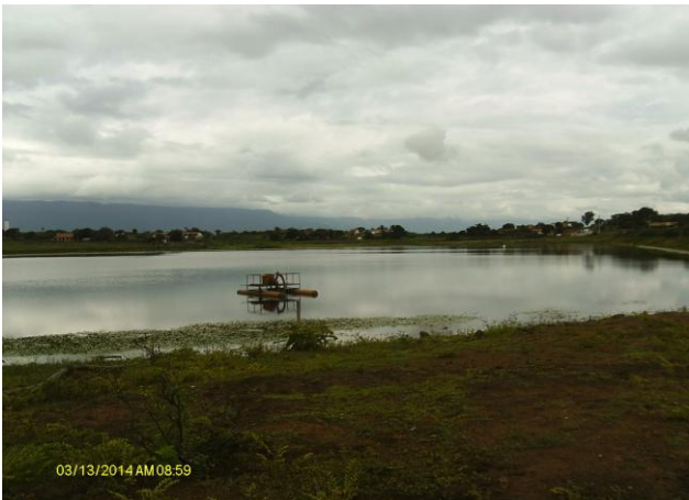
Foto 1 – Vista da captação no Açude Coriolano.
