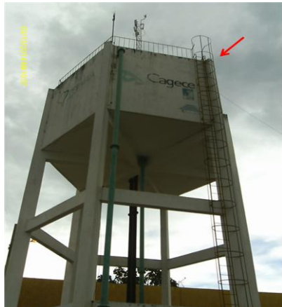
Foto 53 – REL-02: escada de acesso com guarda corpo.
