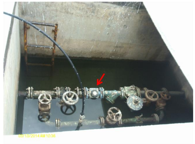
Foto 34 – Macromedidor localizado na chegada do REL-02.
