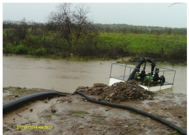
Foto 6 – Captação no braço do Açude Taquara em implantação.
