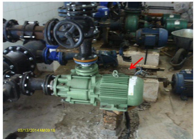
Foto 36 – Elevatória da adução de Graça em implantação.
