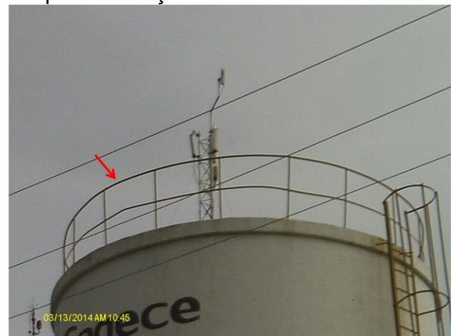
Foto 52 – REL-01: guarda-corpos na laje de cobertura.
