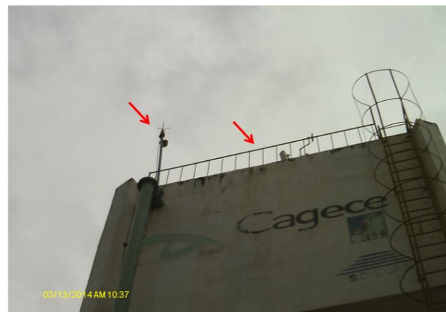
Foto 56 – REL-02: guarda-corpos na laje de cobertura, para-raios e sinalizador noturno.
