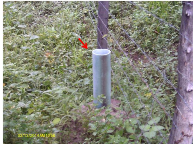
Foto 60 – Registro de descarga na saída para Reriutaba.
