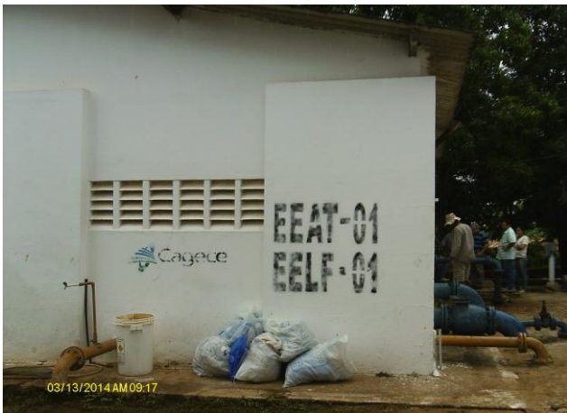
Foto 35 – Prédio de abrigo das EEAT-01 e EELF-01.
