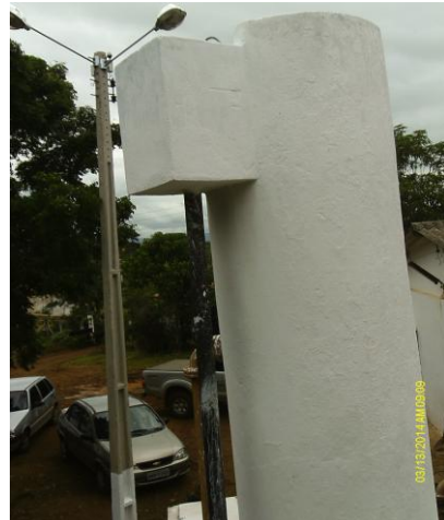
Foto 42 – Torre de equilíbrio.
