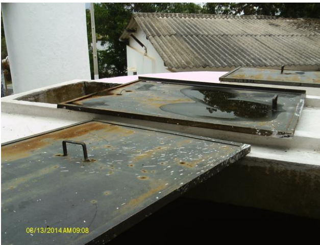
Foto 14 – ETA: filtro em reforma.
