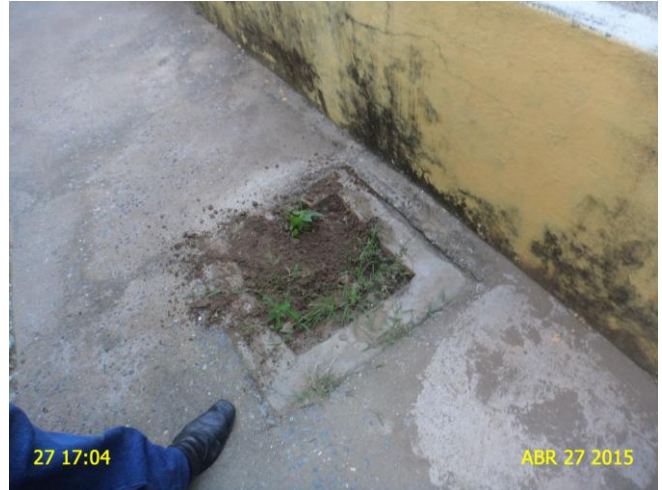
Foto 5 – Registro de descarga na rede soterrado – Rua Antônio Oliveira.
