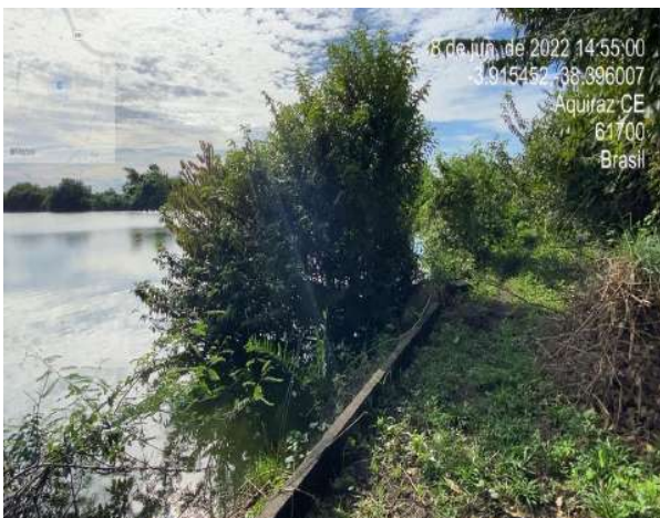
Foto 47 - ETE Sede: Vegetação, inclusive nas laterais interiores das lagoas.
