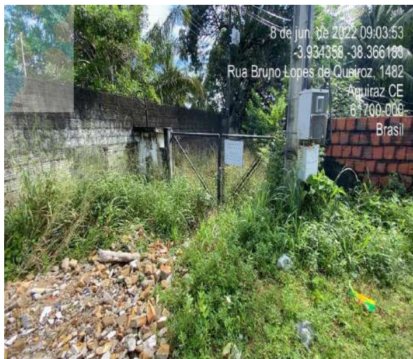
Foto 1 - Captação (Tapera): Acesso precário .
