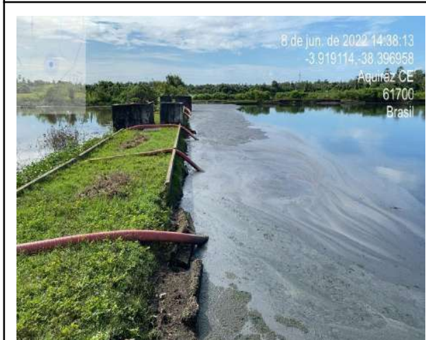
Foto 39 - ETE Sede: Extravasamento de esgoto na lagoa anaeróbia e utilização de sifão para transferência de esgoto para uma lagoa provisória.
