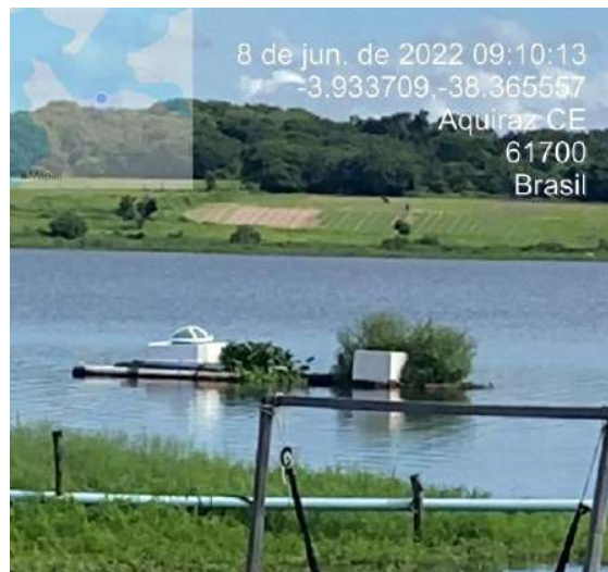
Foto 2 - Captação flutuante (Tapera): presença de vegetação.
