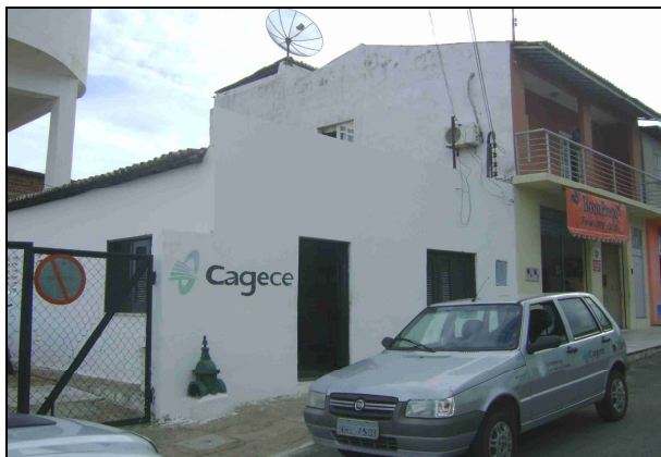
Foto 70 – Vista externa do escritório/loja de atendimento ao usuário.
