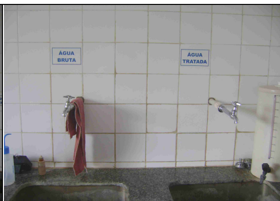
Foto 19 – Laboratório: Torneiras de água bruta e tratada.
