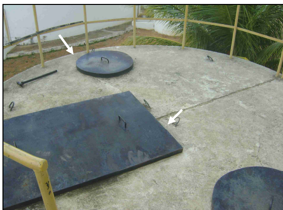
Foto 13 – Filtro 03: Tampas de inspeção adequadas..
