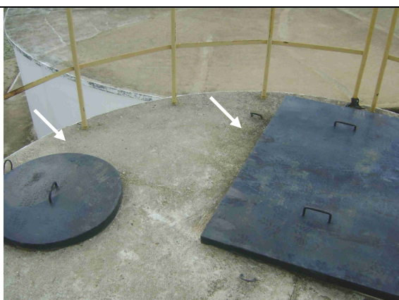
Foto 16 – Filtro 04: Tampas de inspeção adequadas.
