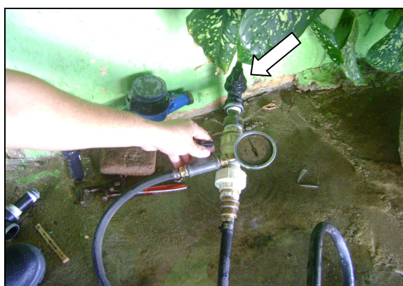
Foto 69 – Medição de pressão na Rua 7, nº 67, Conjunto Novo, antes do hidrômetro.
