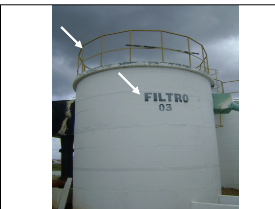
Foto 12 – Filtro 03: Existência de identificação e guarda-corpo.
