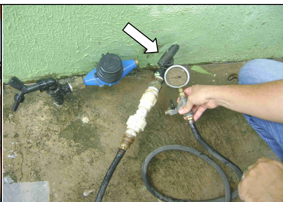
Foto 68 – Medição de pressão na Av. Jerônimo Alves, nº 35, COHAB, antes do hidrômetro.
