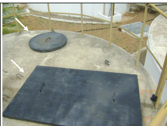
Foto 10 – Filtro 02: Tampas de inspeção adequadas.
