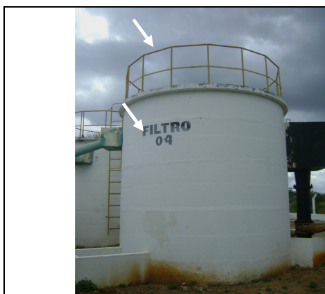
Foto 15 – Filtro 04: Existência de identificação e guarda-corpo.
