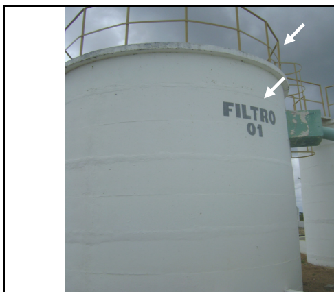
Foto 7 – Filtro 01: Existência de identificação e guarda-corpo.
