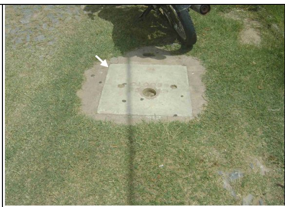
Foto 60 – Registro de descarga localizado na Rua 7 de setembro.
