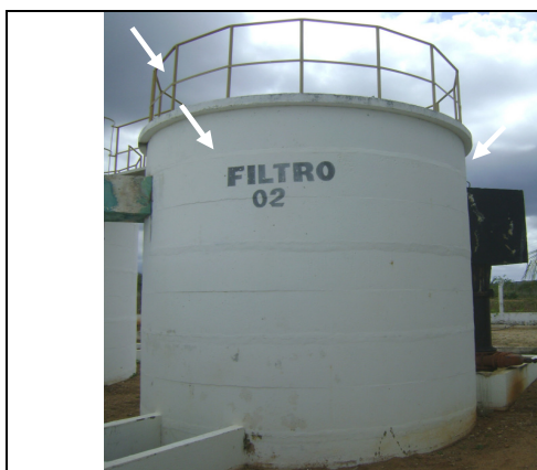
Foto 9 – Filtro 02: Existência de identificação e guarda-corpo.
