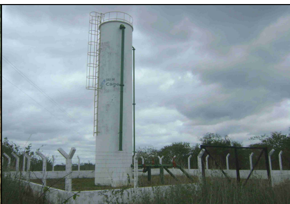
Foto 37 – Torre de equilíbrio 01.
