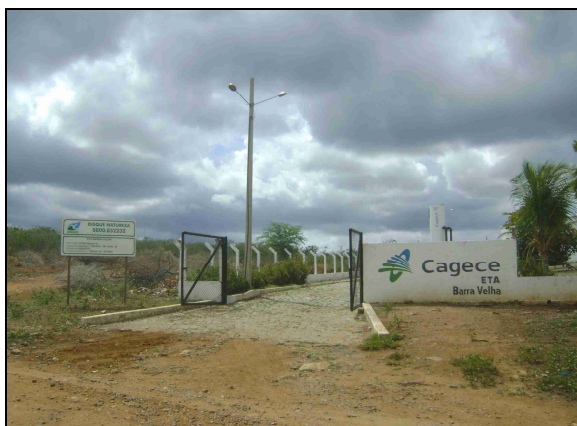
Foto 5 – Vista da ETA.
