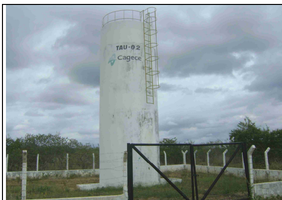
Foto 38 – Torre de equilíbrio 02.
