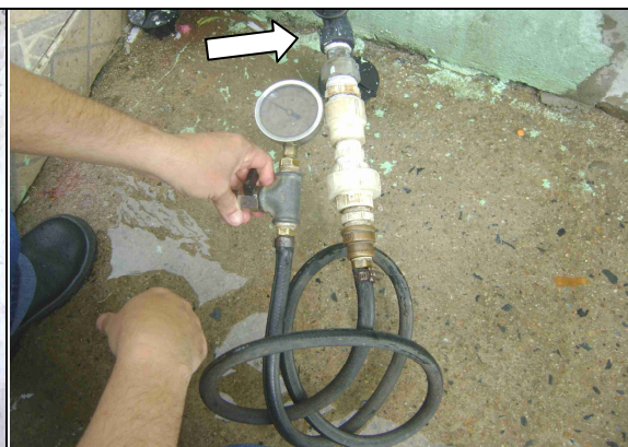
Foto 66 – Medição de pressão na Rua Boa Esperança, VISA nº 57, Liberdade, antes do hidrômetro.
