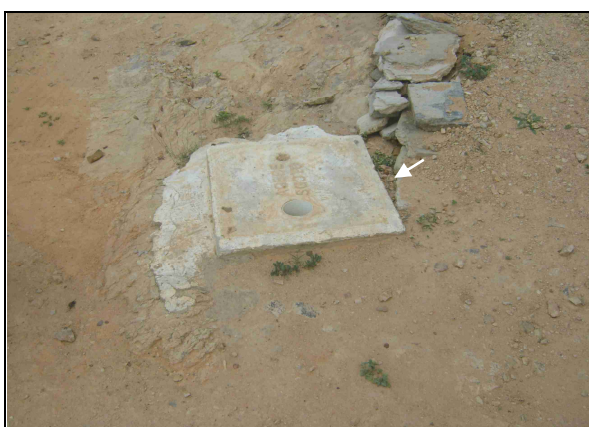
Foto 61 – Registro de descarga localizado na Rua da Liberdade.
