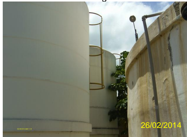
Foto 11 - ETA filtração: escada de acesso do F-02.
