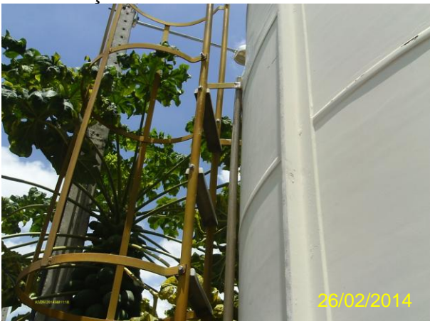
Foto 10 - ETA filtração: escada de acesso do F-01.
