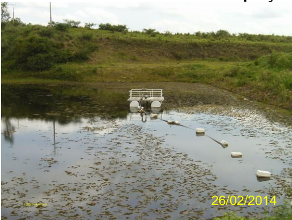
Foto 1 - Captação superficial: Açude Traíras, desenvolvimento de macrófitas na superfície.
