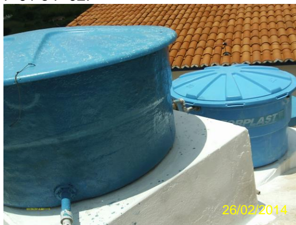
Foto 15 - ETA casa de química: tanques de dosagem de policloreto de alumínio e hipoclorito de cálcio no RAP-01.
