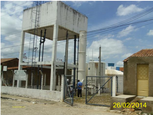
Foto 6 - ETA: cerca delimitadora e portão de acesso.
