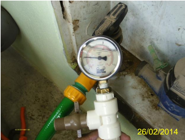
Foto 47 - Medição instantânea de pressão na rede de distribuição: Rua José Amancio, 19.
