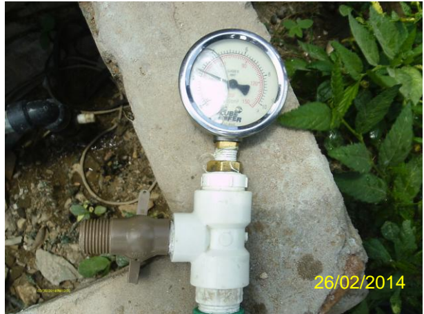
Foto 50 - Medição instantânea de pressão na rede de distribuição: Sítio Luis.
