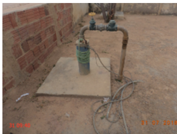
Foto 4 - PT-04: sem identificação e sem cerca ou muro de delimitação de proteção
