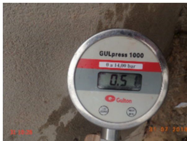
Foto 21 – RDA: medição instantânea de pressão no endereço Conjunto Novo Salitre, 58.
