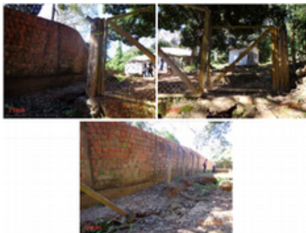
Foto 15 – RAP-06 e EERD-05 Igreja do Céu (Sede): cerca e portão de acesso danificados.
