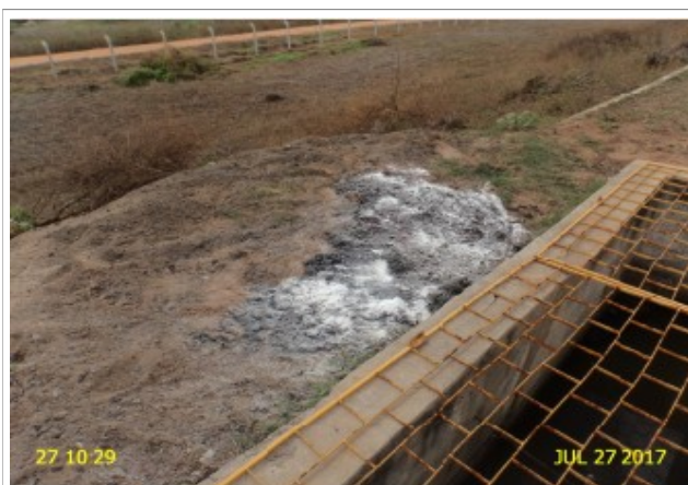
Foto 3 – ETE (Sede): ausência de leito de secagem. Material retido na grade disposto diretamente no solo.
