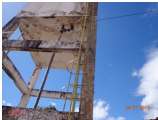
Foto 26 – REL-01 (Lapa): escada e guarda-corpos em processo de corrosão.
