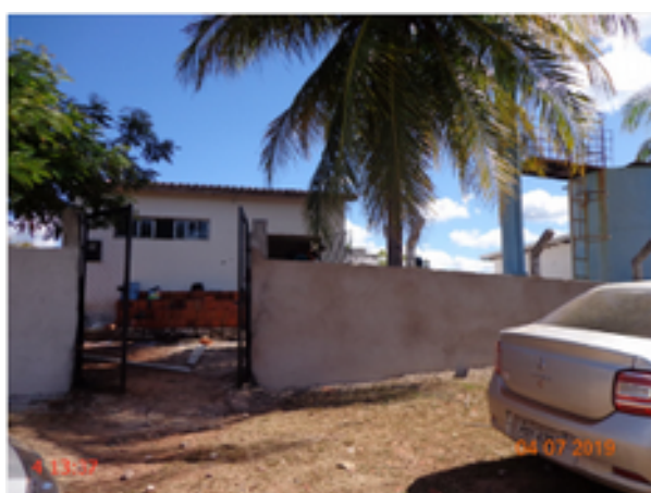
Foto 6 – ETA (Sede): ausência de placa da CAGECE e de identificação.
