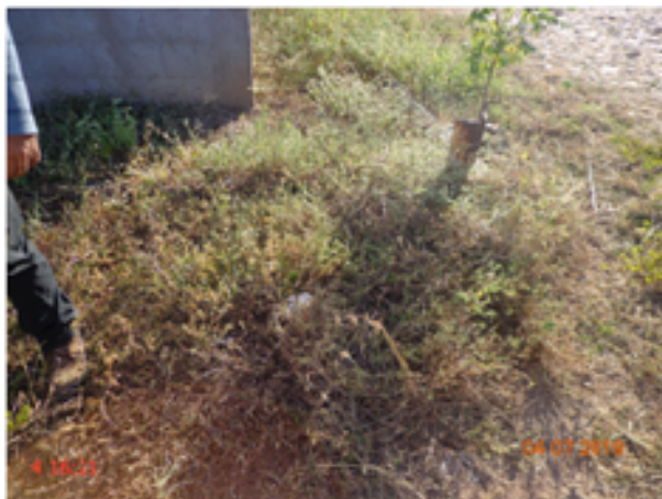
Foto 19 – RDA (Sede): registro de descarga soterrado na R. João Batista Salustiano de Aguiar.
