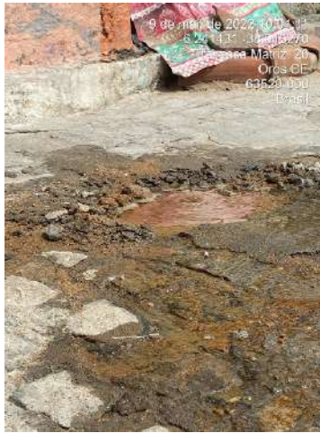
Foto 15 - RDA (Sede): vazamento na Travessa Matriz, nº 26.
