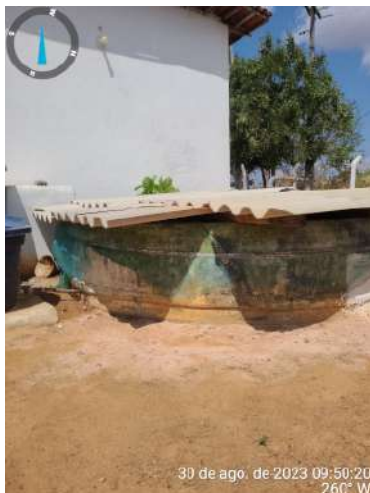
Foto 22 - REN-01 (Várzea da Conceição): cobertura de telhas de amianto e sem vedação hermética.
