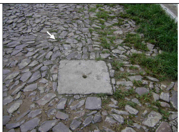
Foto 41 – Registro de manobra localizado na Rua Joaquim Bastos.
