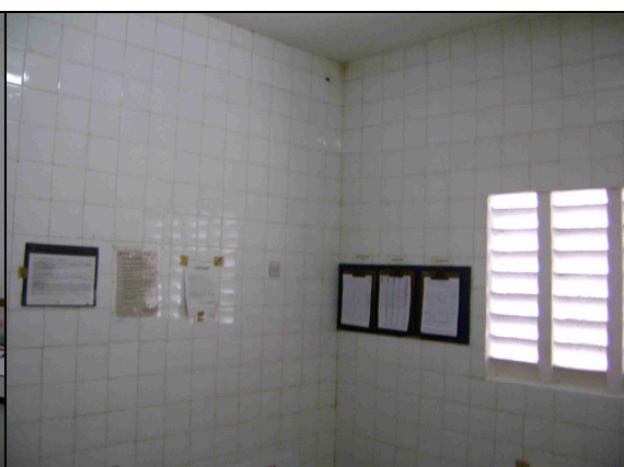
Foto 13 – Vista do laboratório da ETA.
