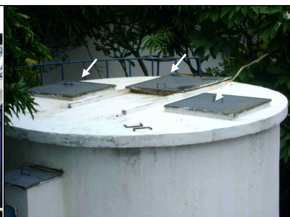
Foto 10 – ETA: tampas do filtro apresentando bom estado de conservação.
