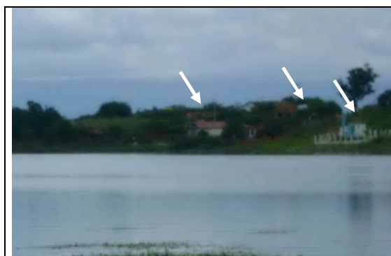
Foto 1 – Vista de casas às margens do açude.
