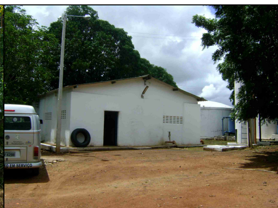
Foto 5 – ETA: área apresentando bom estado de conservação e limpeza.
