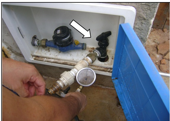
Foto 65 – Medição de pressão na Rua Pedro Carvalhedeo, nº 87, Centro, antes do hidrômetro.
