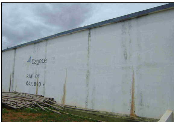
Foto 44 – RAP-01: Existência de identificação.
