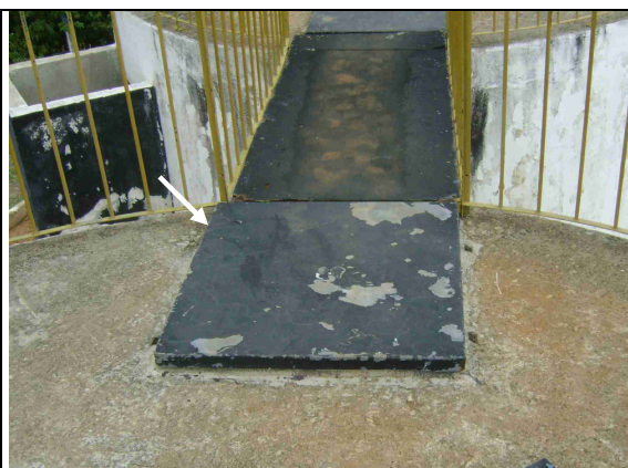
Foto 8 – Filtro 02: Tampa de inspeção adequada.
