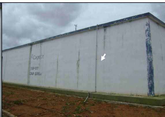
Foto 45 – RAP-02: Existência de identificação.
