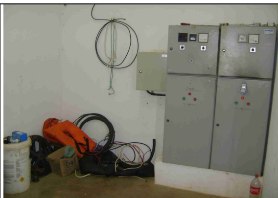
Foto 37 – EECS-01: Sala do quadro de comando com materiais diversos.
