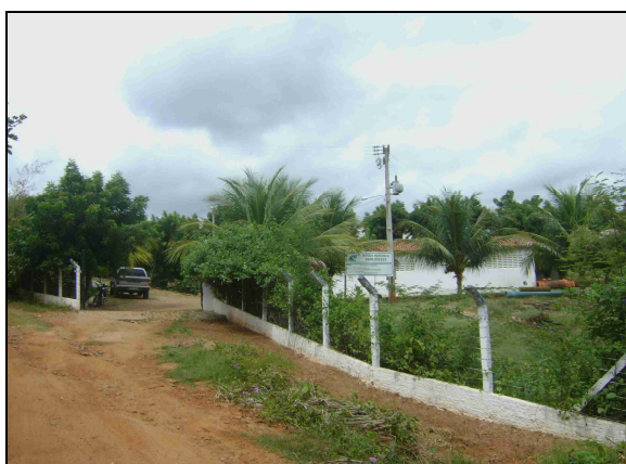
Foto 3 – Vista da ETA.
