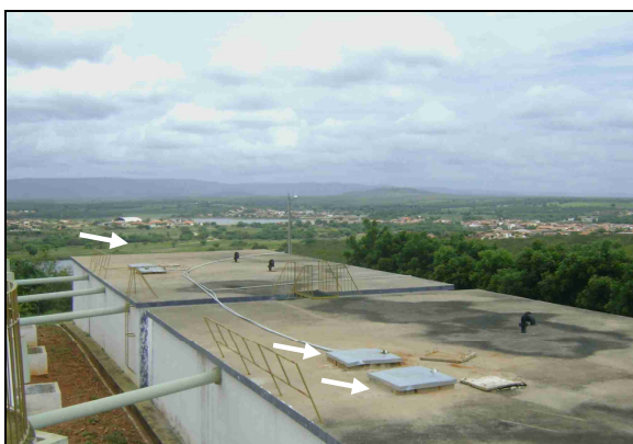
Foto 46 – RAP-01 e RAP-02: Tampas de inspeção adequadas.
