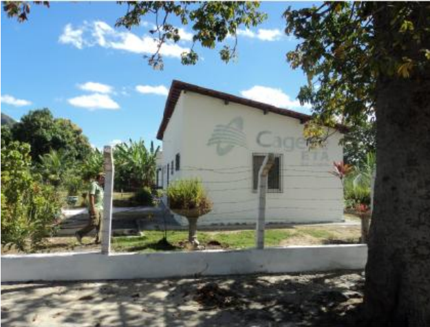
Foto 4 – ETA: área de acesso.
