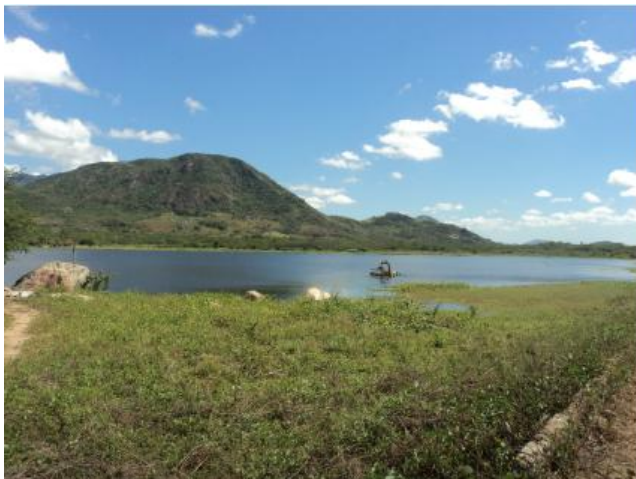
Foto 1 – Açude São Joaquim: vista geral.
