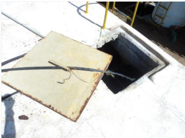
Foto 34 – RAP-01: tampa de inspeção aberta.
