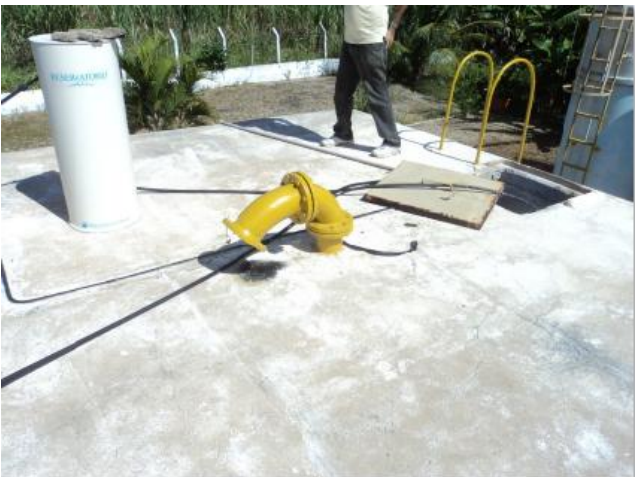
Foto 32 – RAP-01: cobertura do reservatório.
