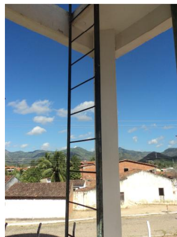
Foto 27 – REL-01: escada de acesso.
