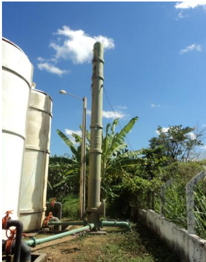
Foto 6 – ETA: vista da torre de nível.
