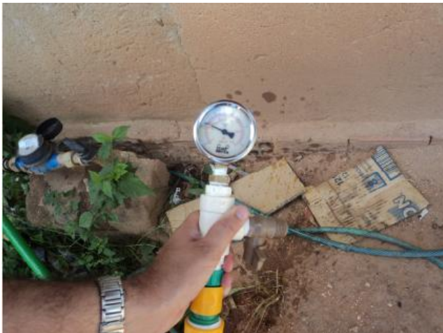
Foto 46 – Medição instantânea de pressão na Rua Antônio quinto dos Santos.
