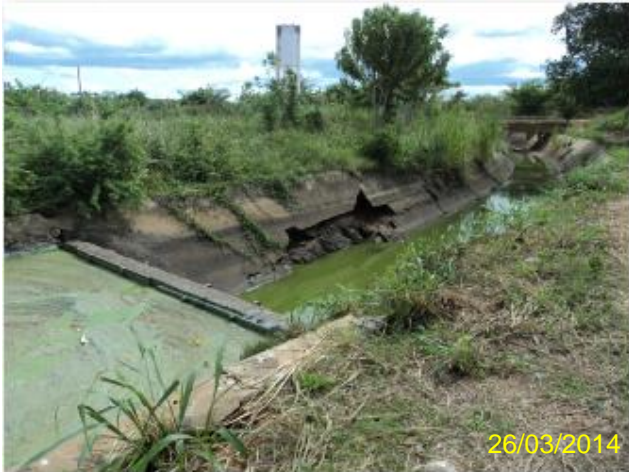
Foto 1 – Canal de irriação do Açude Pereira de Miranda: vista geral.
