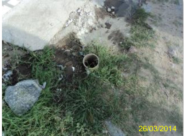
Foto 101 – RDA: registro de descarga na R. Jaca Paraíba (2) sem caixa.
