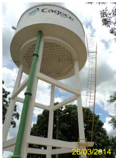
Foto 70 – REL-01: escada de acesso com guarda-corpo.
