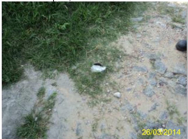
Foto 95 – RDA: registro de descarga na R. Joel Silva Nunes sem caixa.
