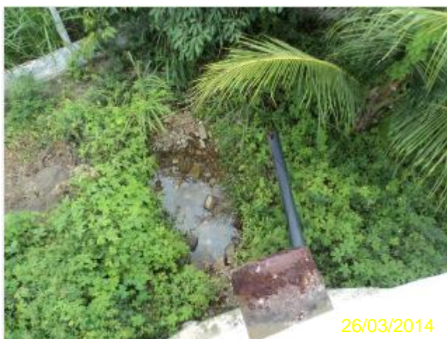
Foto 67 – RAP-05: acúmulo de água - sinais de extravasamento do reservatório.
