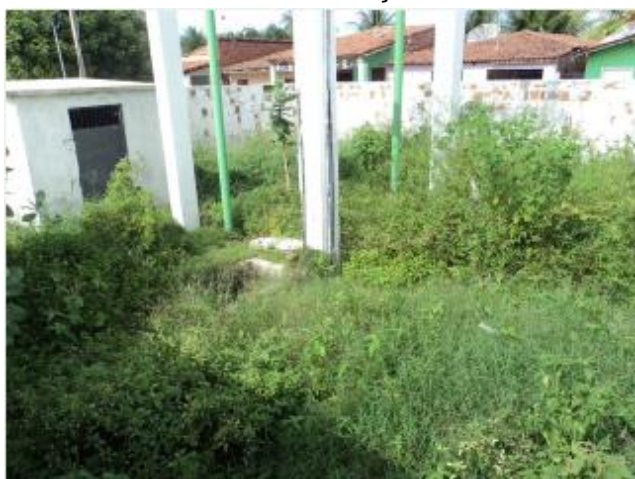
Foto 75 – REL-02: área tomada pela vegetação.
