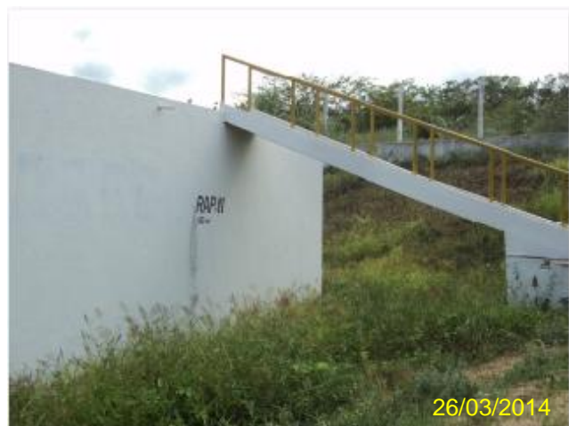
Foto 53 – RAP-01: identificação e escada de acesso.
