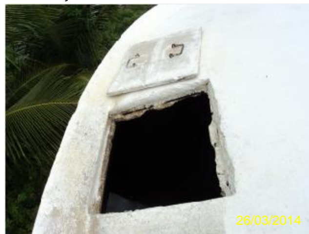
Foto 66 – RAP-05: tampa de inspeção aberta.
