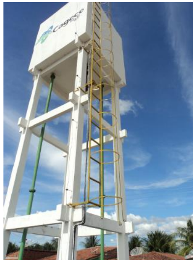
Foto 74 – REL-02: escada com guarda-corpo.
