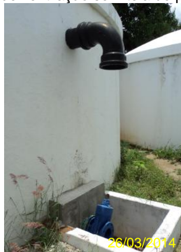
Foto 56 – RAP-02: tubo extravasador.
