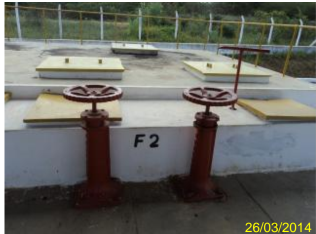
Foto 8 – F2: identificação e tampas de inspeção.
