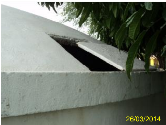
Foto 57 – RAP-02: tampa de inspeção aberta.
