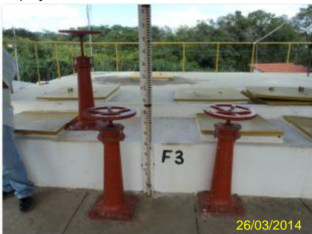
Foto 9 – F3: identificação e tampas de inspeção.
