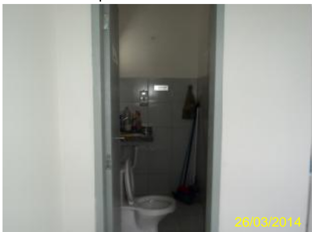
Foto 108 – Loja de atendimento: instalações sanitárias .
