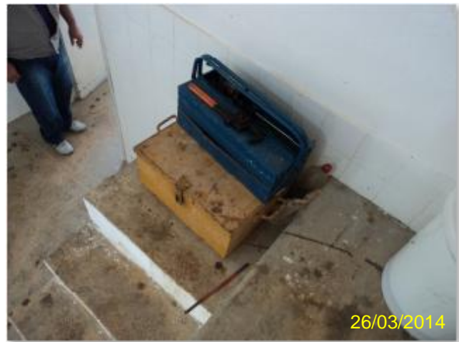
Foto 18 – Casa de química: KIT de emergência.
