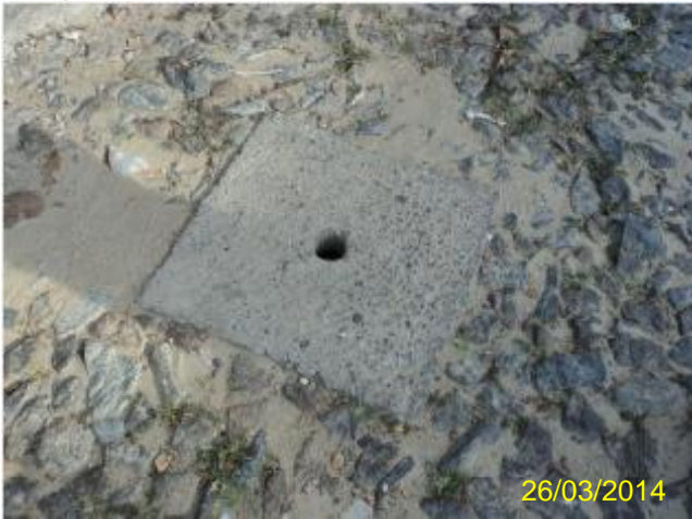
Foto 100 – RDA: registro de descarga na R. Jaca Paraíba (1).
