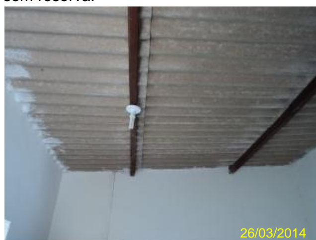
Foto 45 – EEAT-04: ausência de iluminação interna.
