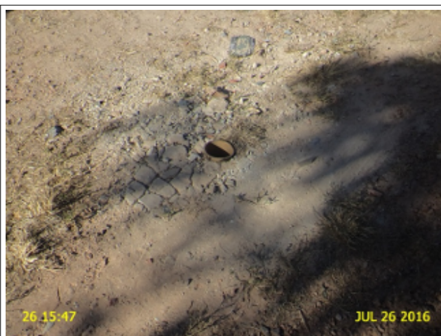
Foto 32 – RDA (Ubaúna): registro de descarga sem caixa: Rua Marroco Mertirdes de Aguiar.
