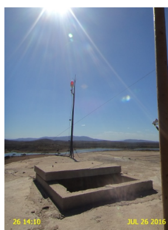
Foto 16 – REL-01 (Ubaúna): tampa de inspeção aberta.
