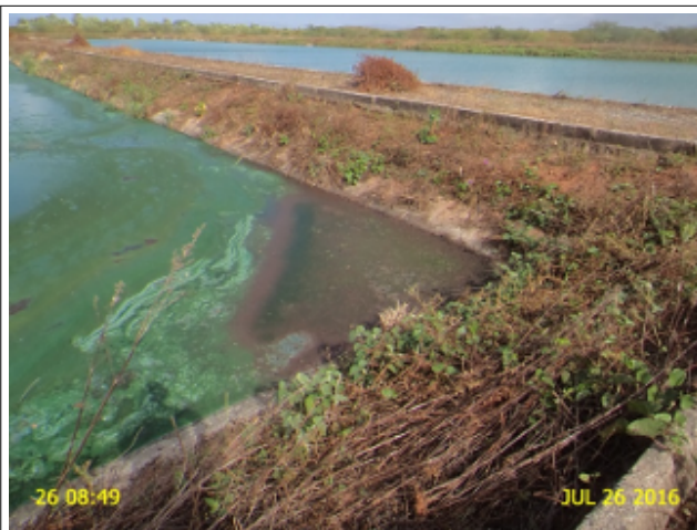
Foto 8 - ETE: acúmulo de sobrenadantes na lagoa de maturação LM (1).
