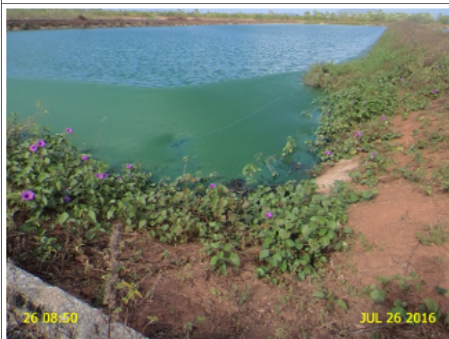
Foto 9 - ETE: acúmulo de sobrenadantes na lagoa de maturação LM (2).
