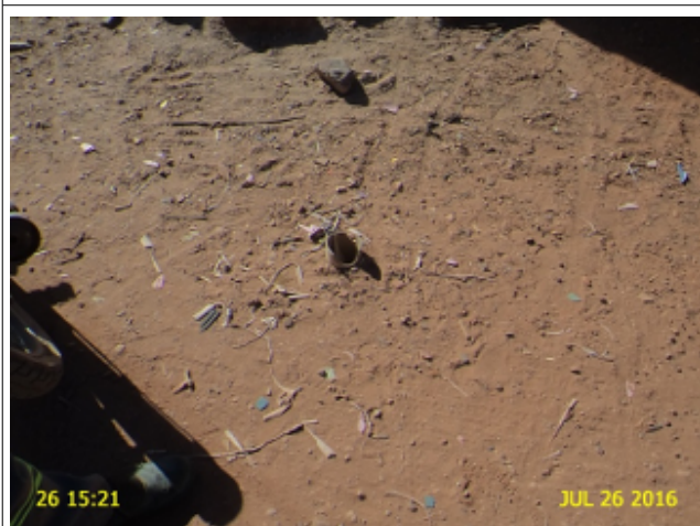
Foto 29 - RDA (Ubaúna): registro de descarga sem caixa: Rua dos Mota.
