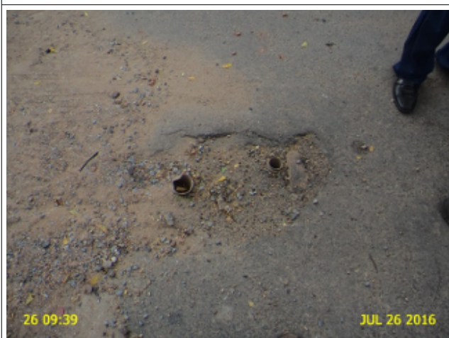
Foto 23 - RDA (Coreaú): registro de descarga na Avenida Bernardones Teles sem caixa.
