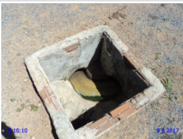
Foto 3 - ETE: caixa de inspeção sem tampa ou grade de proteção (1).
