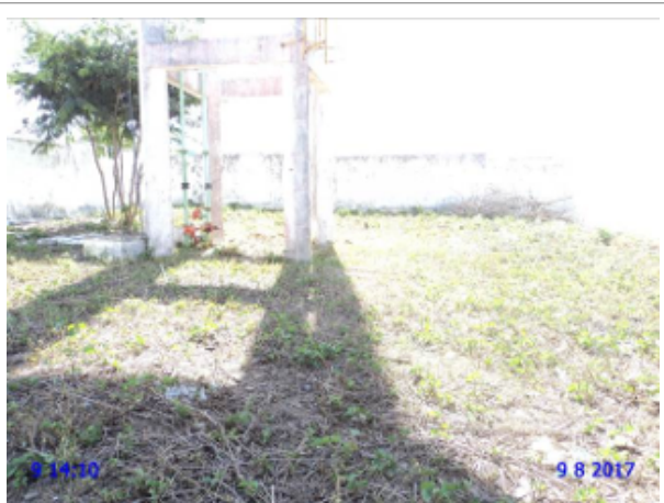
Foto 6 - REL-25: vegetação excessiva na área do reservatório.
