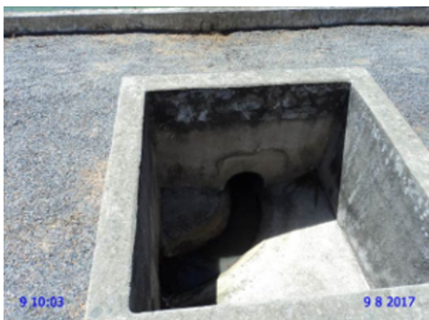
Foto 3 - ETE: caixa de inspeção sem tampa ou grade de proteção (1).
