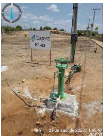
**Foto 5** - PT-09 (Sede): ausência de delimitação, proteção e isolamento da área; falta iluminação e laje de proteção.
