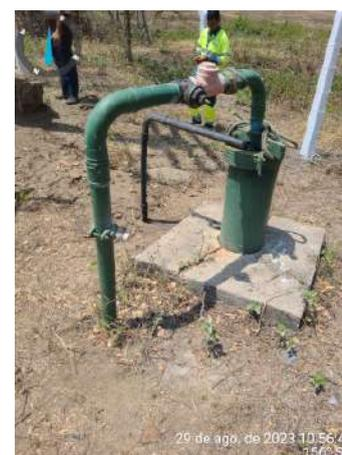
**Foto 22** - PT-06 (Sede): laje de proteção danificada e portão corroído.
