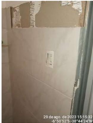
**Foto 37** - REL-01/Almoxarifado (Felizardo): banheiro deteriorado (sem iluminação, caixa de descarga e revestimento danificados e porta quebrada).
