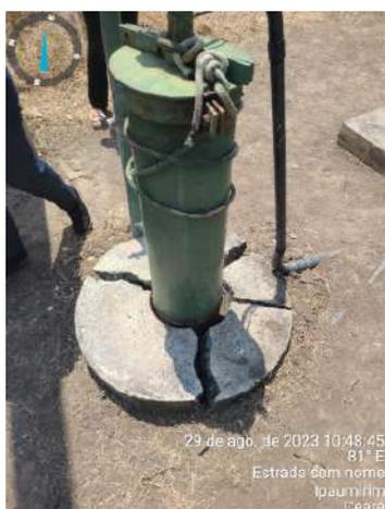
**Foto 21** - PT-08 (Sede): laje de proteção danificada.
