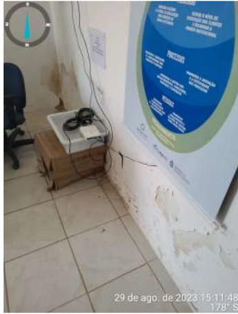
**Foto 35** - REL-01/Almoxarifado (Felizardo): almoxarifado com presença de mofo nas paredes e pintura desgastada, instalações assentadas em base improvisada e com fiações inadequadas
