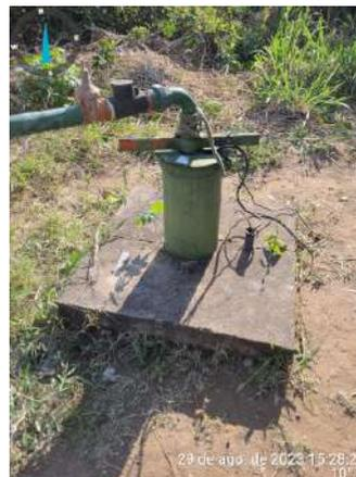
**Foto 42** - PT-03 (Felizardo): laje de proteção danificada, instalação elétrica inadequada e ausência de lâmpada.
