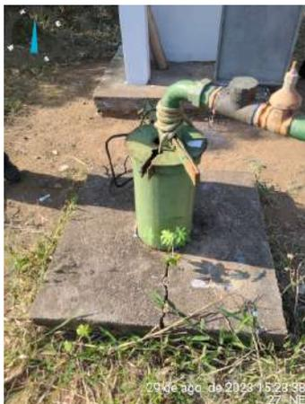
**Foto 41** - PT-03 (Felizardo): laje de proteção danificada, instalação elétrica inadequada e ausência de lâmpada.
