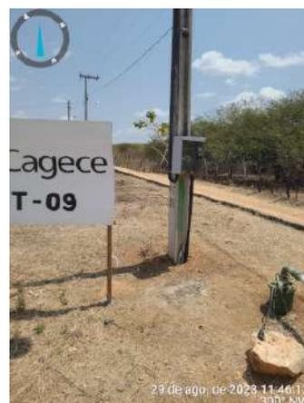
**Foto 6** - PT-09 (Sede): ausência de laje de proteção; Quadro de comando sem abrigo, exposto às intempéries.
