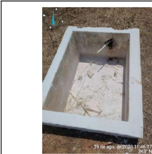
**Foto 7** - PT-09 (Sede): caixa de saída de cloração sem tampa/grade.
