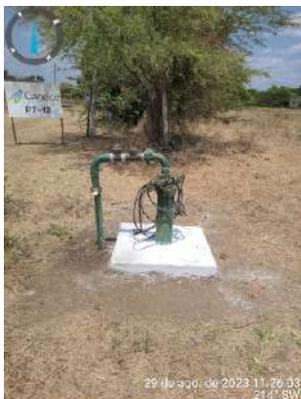
**Foto 25 - PT-12 (Sede):** RAP desativado com água acumulada e instalações elétricas do poço inadequadas.
