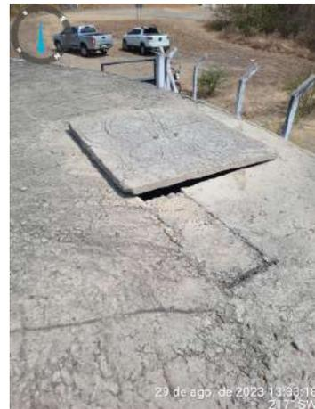
**Foto 26 - RAP-01 (Sede):** tampa da abertura de inspeção sem vedação completa.
