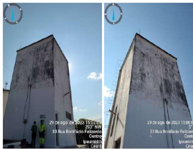
**Foto 32** - REL-01/Almoxarifado (Felizardo): escada corroída, pintura desgastada, para-raios inadequado.
