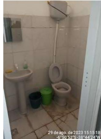
**Foto 36** - REL-01/Almoxarifado (Felizardo): banheiro deteriorado (sem iluminação, caixa de descarga e revestimento danificados e porta quebrada).
