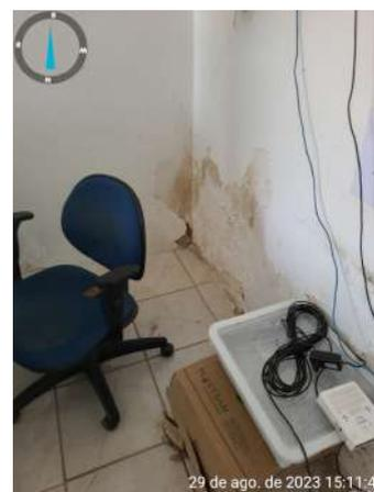
**Foto 34** - REL-01/Almoxarifado (Felizardo): almoxarifado com presença de mofo nas paredes e pintura desgastada, instalações assentadas em base improvisada e com fiações inadequadas
