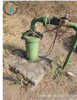
**Foto 38** - PT-01 (Felizardo): instalação elétrica inadequada.
