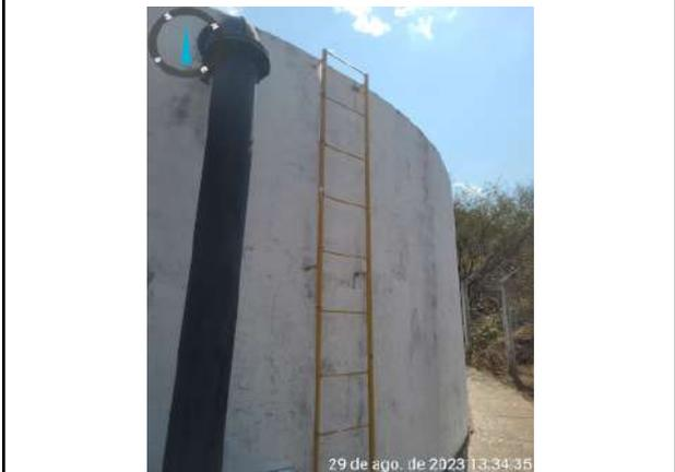
**Foto 10** - RAP-01 (Sede): escada inadequada (sem gaiola de proteção, guarda-corpo ou corrimão de proteção acima do patamar da estrutura).
