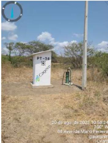
**Foto 1** - PT-08 (Sede): ausência de delimitação, proteção e isolamento da área.
