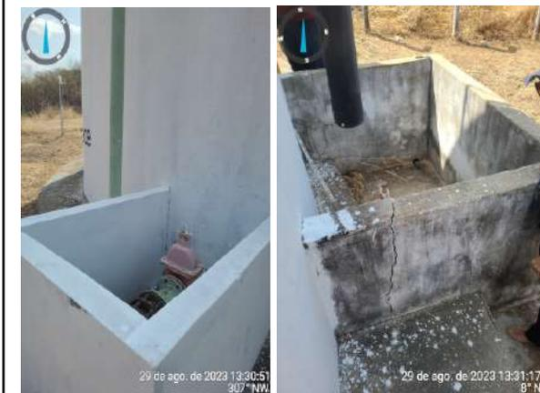
**Foto 9** - RAP-01 (Sede): caixas de registro e caixa de despejo sem tampa/grade e escada inadequada.
