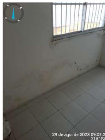
**Foto 18** - Escritório (Sede): sala interna com infiltração e pintura desgastada.
