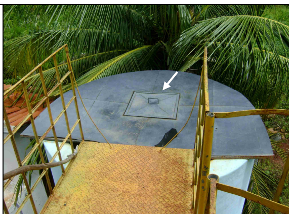
Foto 12 – ETA: tampas do filtro apresentando bom estado de conservação.
