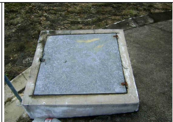
Foto 40 – RAP-01: Inspeção com tampa adequada.
