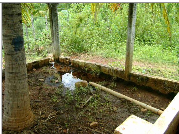
Foto 14 – ETA: Ponto de lançamento das águas de lavagem do filtro.
