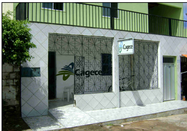
Foto 48 – Vista externa do escritório/loja de atendimento ao usuário.
