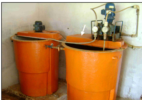
Foto 23 – Tanques de mistura:
