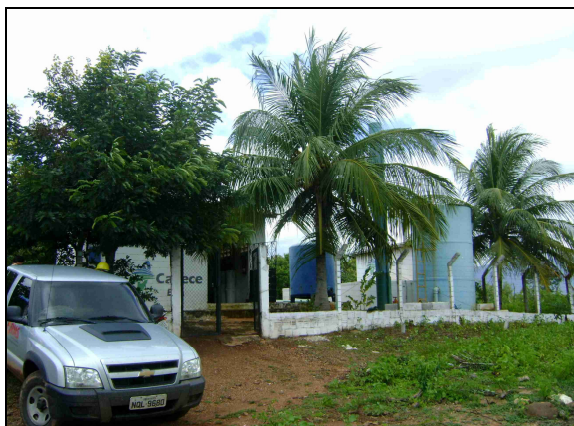
Foto 9 – Vista da ETA.
