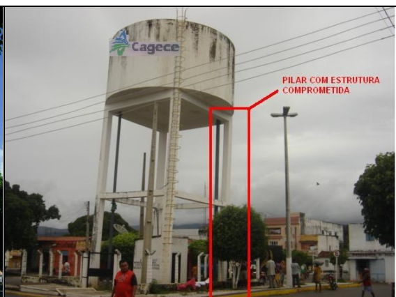
Foto 44* – REL-01 apresentando inclinação – Foto tirada em 2009.
