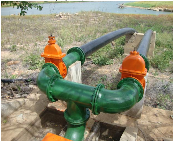
Foto 44 – Registros e ventosa instalados na adutora de água bruta.
