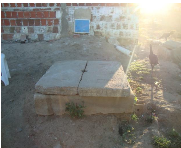
Foto 93 – Registro de descarga na Rua F, Conj. Habitacional Domingos Gomes.
