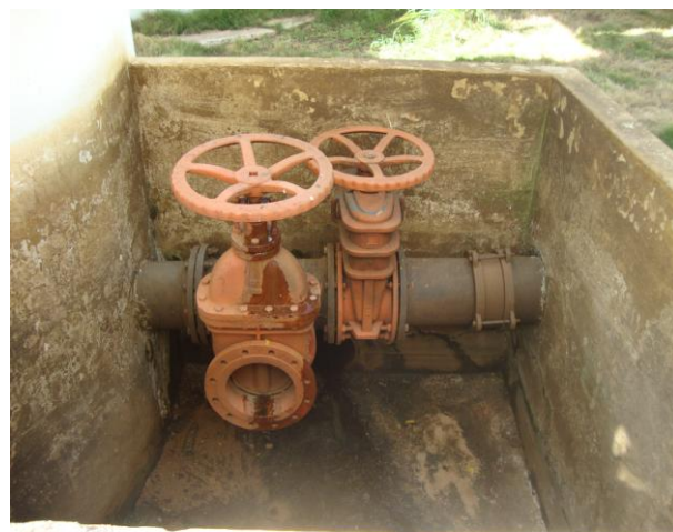
Foto 16 – Descarga do Filtro 01.
