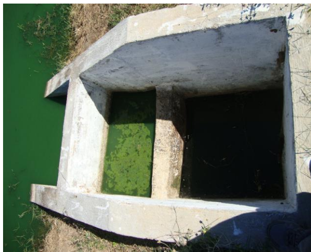
Foto 143 – ETE: poço de saída da lagoa de maturação M1.
