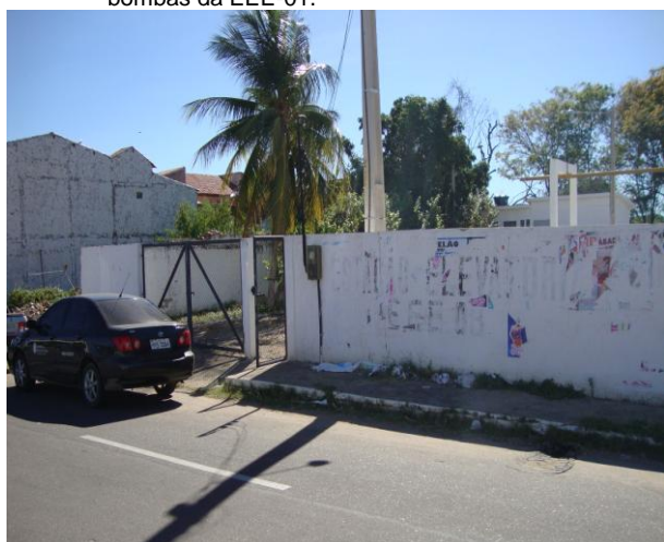
Foto 111 – Vista da externa da EEE-08.
