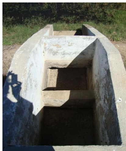
Foto 146 – ETE: poço de saída da lagoa de maturação M2.
