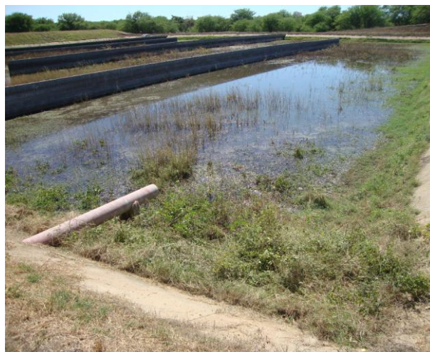
Foto 144 – ETE: vista da lagoa de maturação M2.
