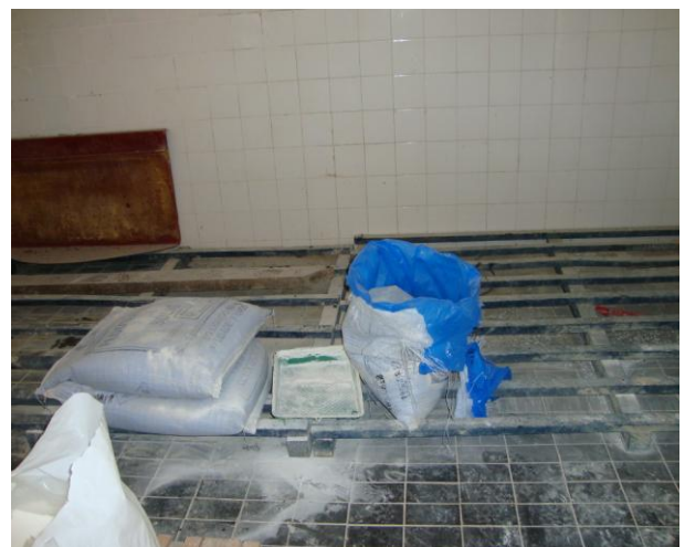
Foto 24 – Produtos químicos armazenados em estrados de madeira.
