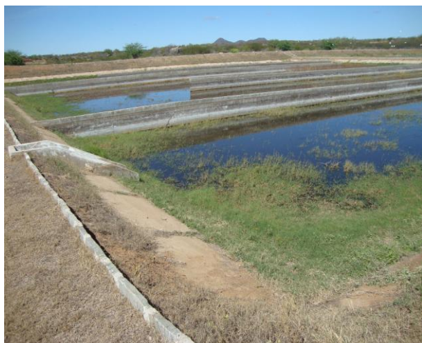
Foto 145 – ETE: poço de saída da lagoa de maturação M2.
