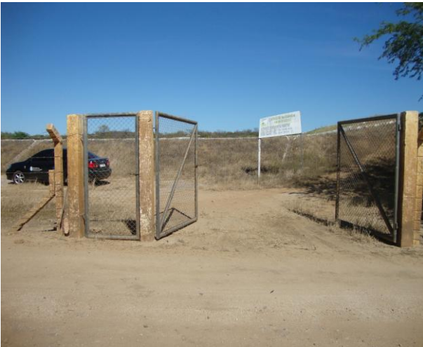
Foto 125 – Portão de entrada da ETE.
