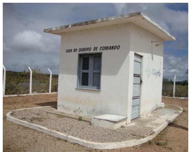
Foto 6 – Casa de abrigo do quadro de comando da captação superficial.
