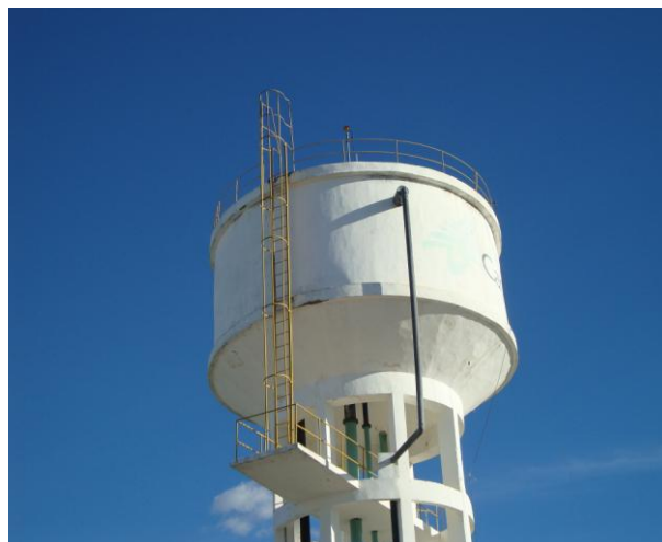
Foto 72 – REL-01: com escada de acesso e guarda-corpo.
