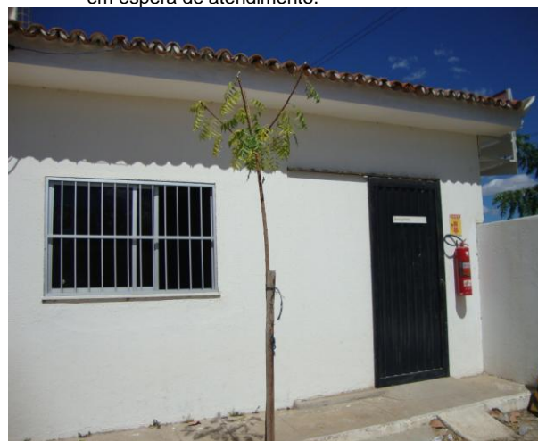
Foto 156 – Vista externa do almoxarifado.
