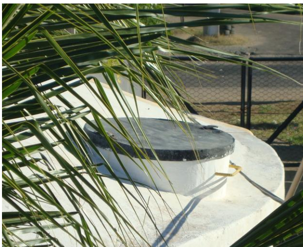
Foto 61 – RAP-02: com tampa adequadamente vedada.
