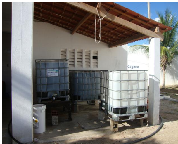
Foto 25 – Almojarifado de produtos químicos.
