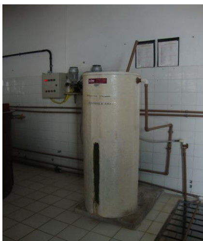
Foto 27 – Sistema de fluoretação.
