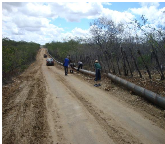
Foto 3 e 4 – Vistas da adutora em construção que interligará o Açude Favela ao Açude Trici (22/11/2012)
