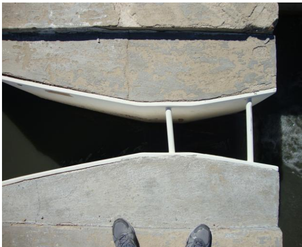
Foto 133 – ETE: vista da Calha Parshall.
