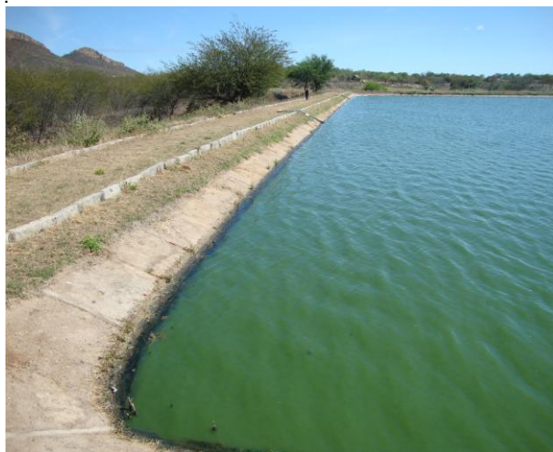
Foto 139 – ETE: vista da lagoa de maturação M1.
