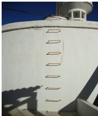
Foto 60 – RAP-02: com escada de acesso.
