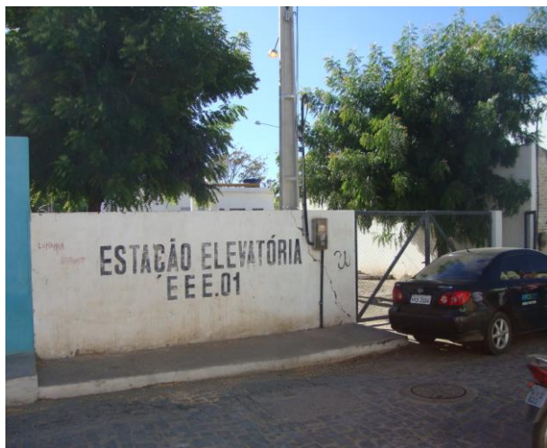
Foto 101 – Vista da externa da EEE-01.
