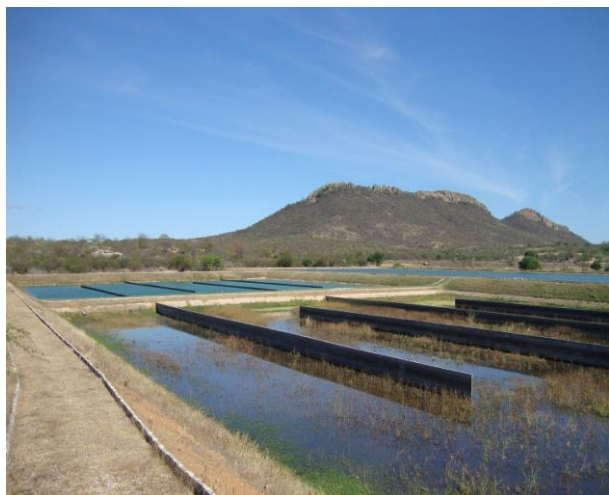
Foto 147 – ETE: vista da lagoa de maturação M2.
