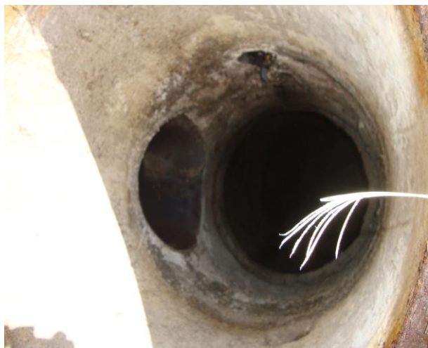
Foto 113 – EEE-08: poço de visita de chegada.
