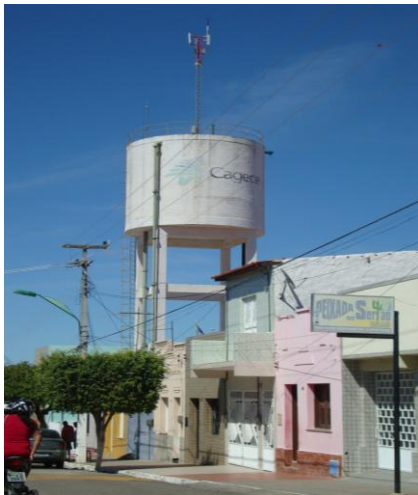
Foto 79 – REL-02 desativado: com existência de guarda-corpo na laje, para-raios, sinalizador noturno.
