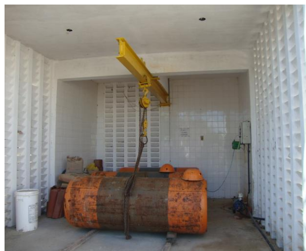
Foto 28 – Casa da estação de cloro gasoso.
