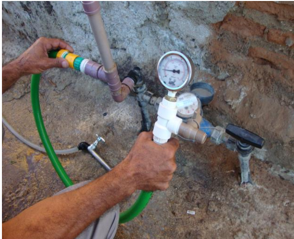
Foto 89 – Medição de pressão na Rua Júlio Gonçalves da Silva, nº 1.077.
