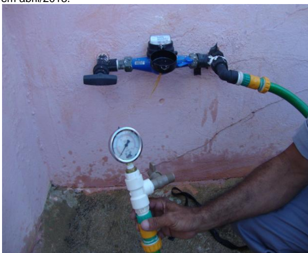
Foto 87 – Medição de pressão na Rua Pedro Matias Vasconcelos, nº 58.
