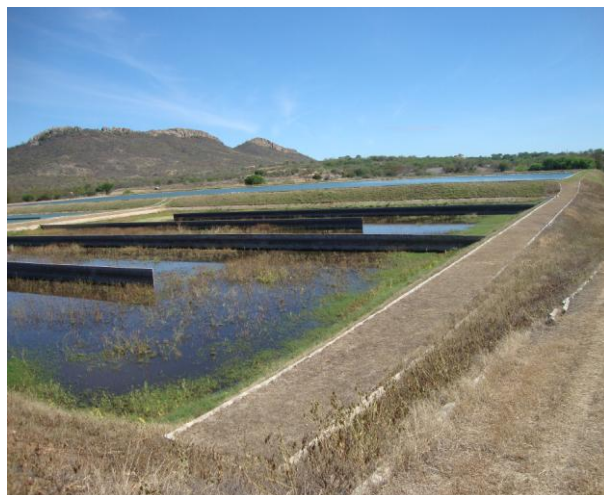
Foto 148 – ETE: vista da lagoa de maturação M2.
