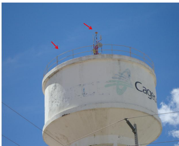
Foto 73 – REL-01: com existência de guarda-corpo na laje, para-raios, sinalizador noturno.
