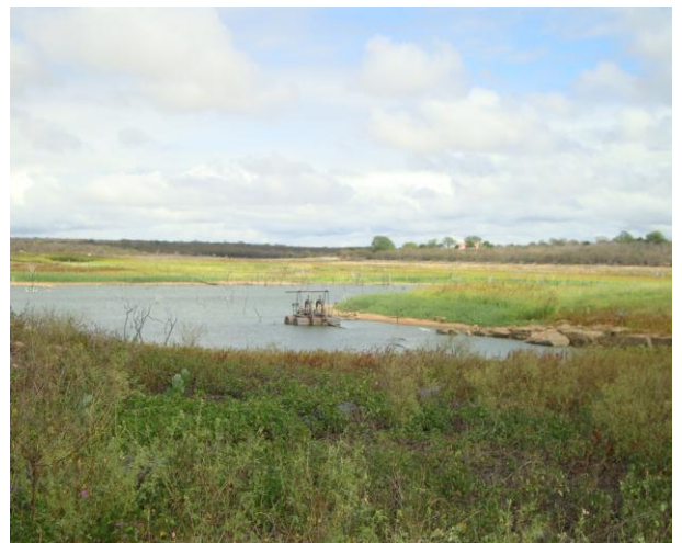
Foto 4 – Vista da captação do Açude Trici.
