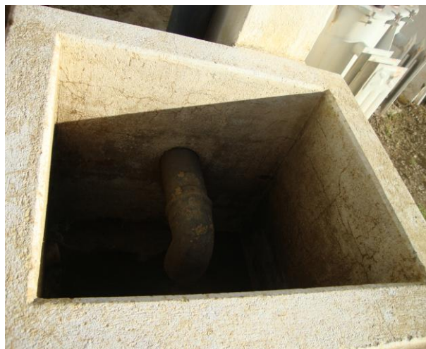
Foto 76 – REL-01: descarga de fundo.
