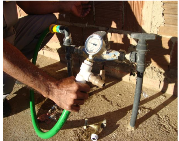
Foto 86 – Medição de pressão na Rua Francisco de Assis, s/n.
