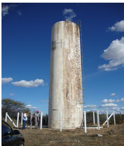
Foto 57 – Vista da torre peзомétrica de água bruta desativada.
