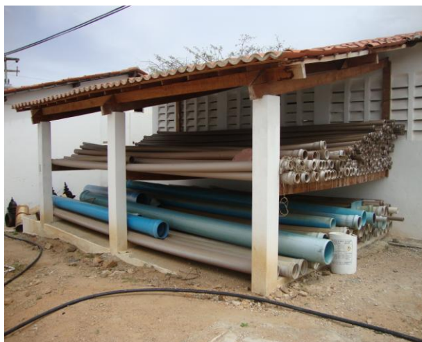
Foto 39 – Tubulação armazenada adequadamente, na área da ETA.
