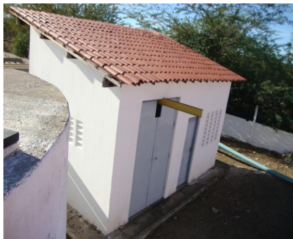
Foto 54 – Vista externa da casa de abrigo da EEAT-02 e do quadro de comando.
