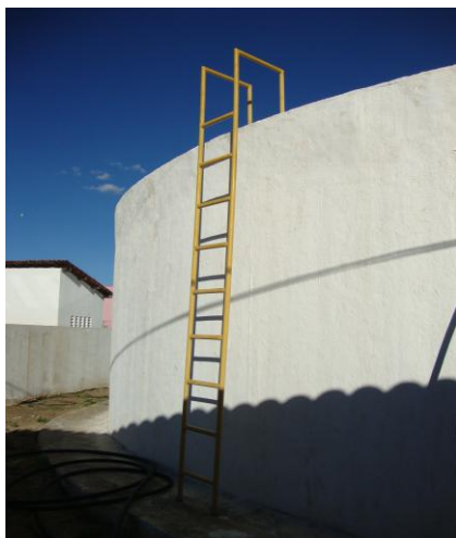
Foto 67 – RAP-03: com escada de acesso.
