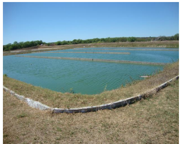
Foto 140 – ETE: vista da lagoa de maturação M1.
