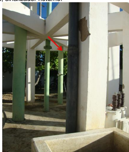
Foto 75 – REL-01: com existência de tubulação de descarga.
