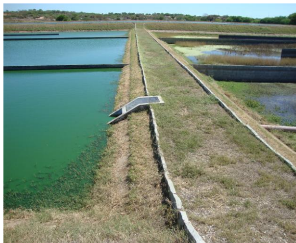
Foto 142 – ETE: guias da lagoa de maturação M1.
