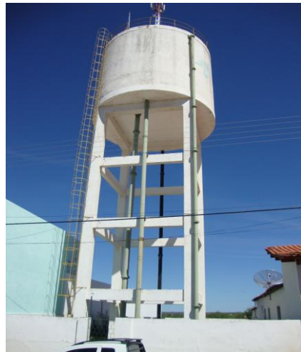
Foto 80 – REL-02 desativado: com escada de acesso e guarda-corpo.
