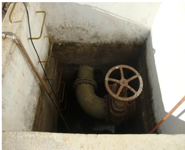
Foto 65 – RAP-02: registro de descarga.
