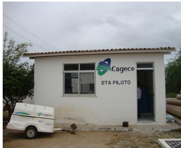
Foto 38 – ETA piloto desativada no interior da ETA de Tauá.
