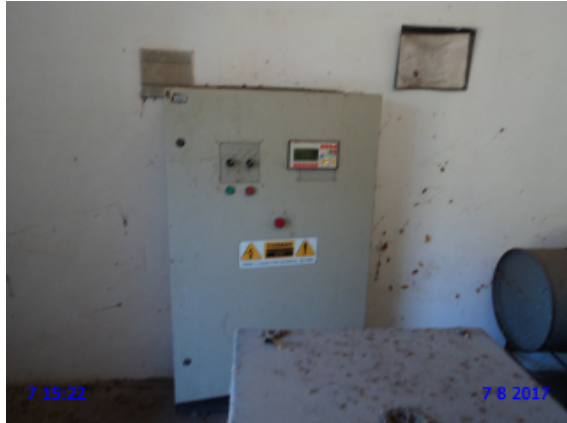
Foto 24 - EEE-03: Quadro de comando do grupo gerador de energia elétrica com defeito.
