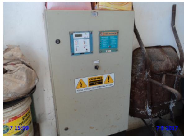
Foto 23 - EEE-02: Quadro de comando do grupo gerador de energia elétrica com defeito.
