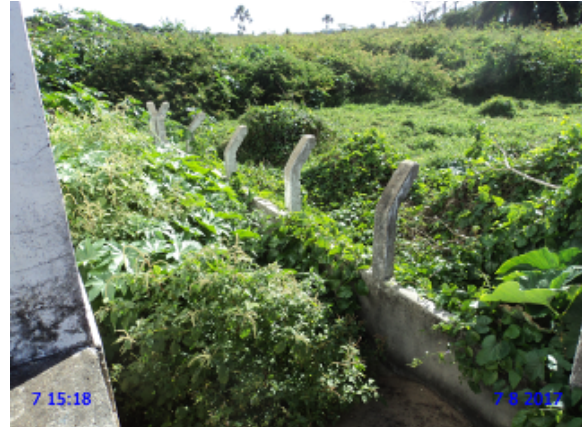
Foto 25 - EEE-03: cerca de delimitação danificada.
