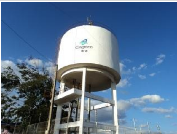
Foto 8 - REL-20 Cruzeiro: guarda-corpos em processo de corrosão.
