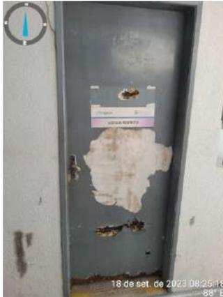
**Foto 22-** ETA (Sede): área desorganizada, com instalações elétricas inadequadas, porta danificada e saída dos filtros com tampas deslocadas.
