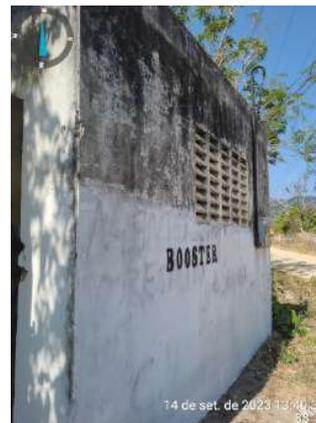
**Foto 95** - REN-02/EERD-02 (Boa Vista): identificação inadequada, problemas na estrutura da laje.
