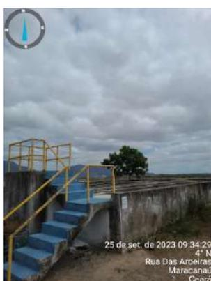
**Foto 98** - ETE (Sede): ausência de guarda-corpo na estrutura de tratamento preliminar.
