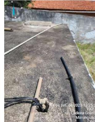
**Foto 91** - RSE-01 (Vila Nova): péssimo estado de conservação e problemas na estrutura, furo na laje, e instalações elétricas inadequadas.
