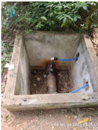
**Foto 78** - ETA (Sapupara): caixa de pré-cloração sem tampa/grade.
