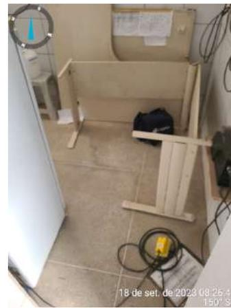
**Foto 21** - ETA (Sede): área desorganizada, com instalações elétricas inadequadas, porta danificada e saída dos filtros com tampas deslocadas.
