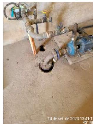
**Foto 97** - REN-02/EERD-02 (Boa Vista): ausência de bomba reserva e reservatório com furo e sem vedação.
