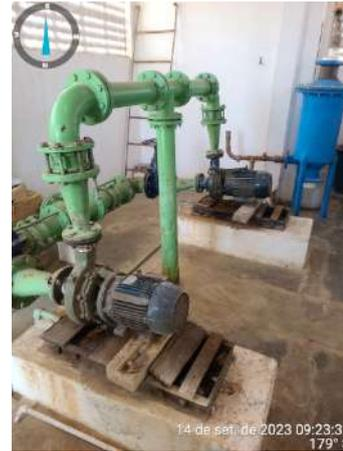
**Foto 47** - EEAT-01 (ETA) (Amanari): base das bombas inadequadas, banheiro com lâmpada sem funcionar e instalações elétricas inadequadas.
