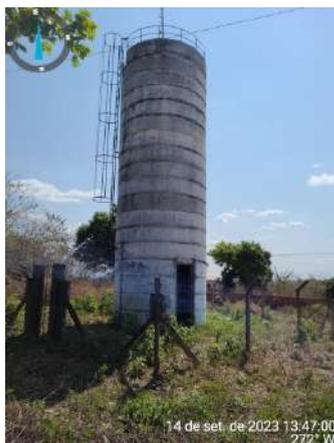
**Foto 68** - REL-06 (Sapupara): conservação precária, identificação inadequada, excesso de vegetação.
