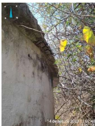
**Foto 62** - RAP-03 (Itapebussu): estrutura apresenta ferrugem exposta, pintura desgastada e excesso de vegetação.
