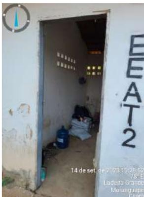
**Foto 92** - EEAT-02 (Vila Nova): ausência de porta na entrada e porta do banheiro danificada, alvenaria e reboco danificados, pintura das paredes internas e externas desgastadas e identificação inadequada.
