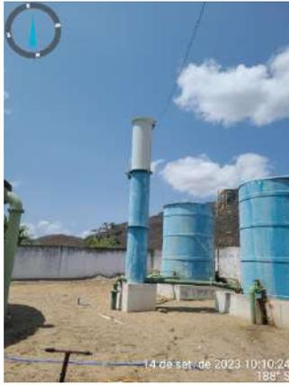
**Foto 13** - Torre de Nível (ETA) (Itapebussu): ausência de escada.
