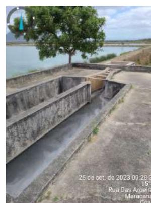
**Foto 99** - ETE (Sede): ausência de guarda-corpo na estrutura de tratamento preliminar.
