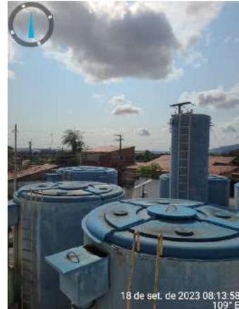
**Foto 23-** ETA (Sede): área desorganizada, com instalações elétricas inadequadas, porta danificada e saída dos filtros com tampas deslocadas.
