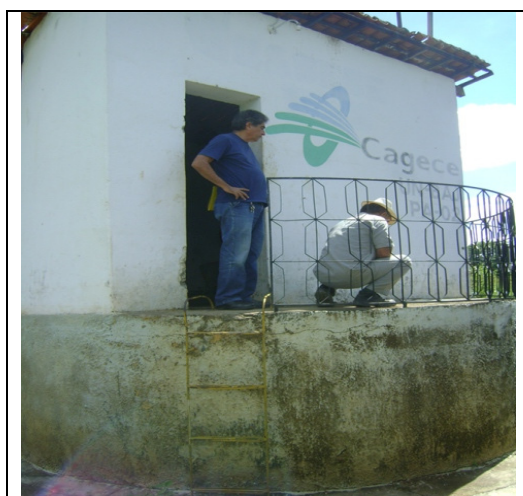
Foto 14 – Vista externa da EEAB-01
