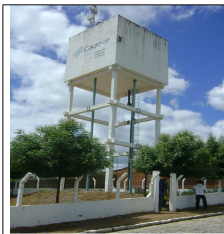
Foto 24 – Vista do REL-01
