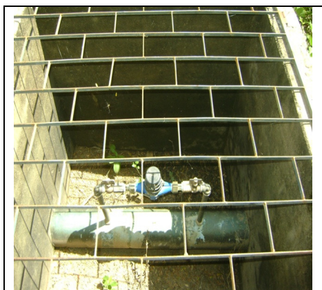
Foto 26 – Medidor proporcional na saída da captação
