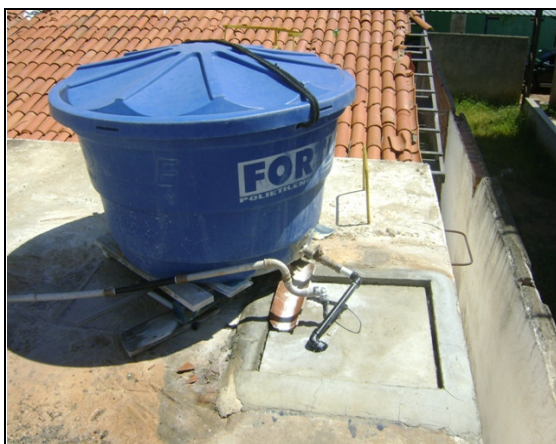
Foto 06 – Aplicação de hipoclorito de sódio no RAP-01
