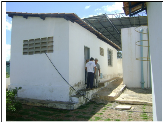
Foto 17 – Vista externa da EEAT-01
