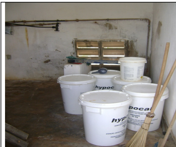
Foto 07 – Armazenamento inadequado de produtos químicos
