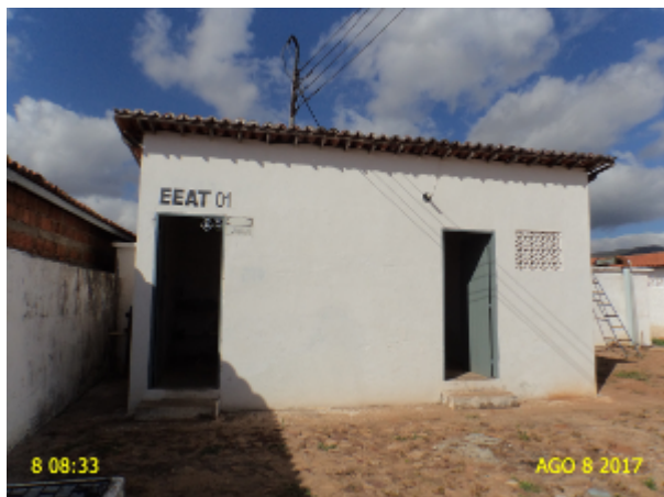
Foto 8 – EEAT-02: ausência de identificação.
