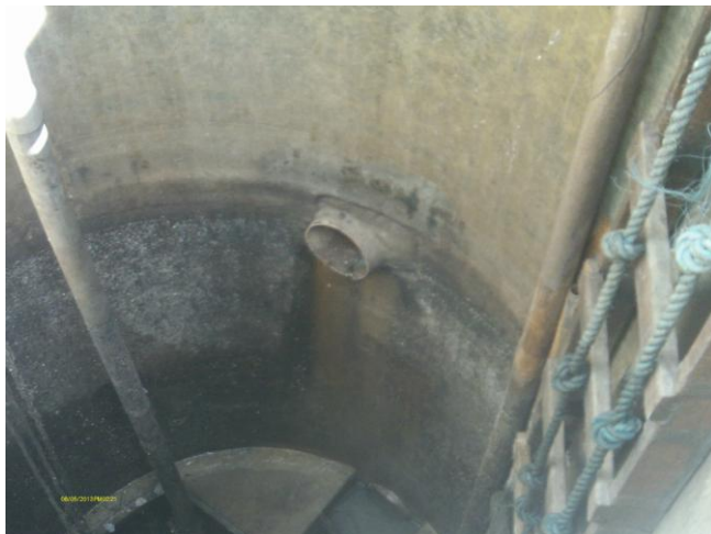
Foto 48 – Vista da chegada do efluente.
