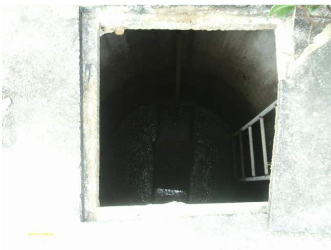
Foto 40 – Poço de sucção.
