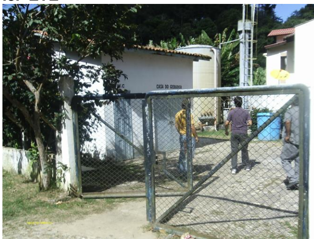
Foto 46 – Entrada da ETE sem placa de identificação e divulgação da licença de operação.
