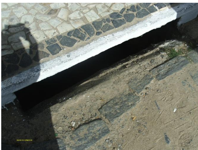
Foto 45 – Corpo receptor: acesso à galeria.
