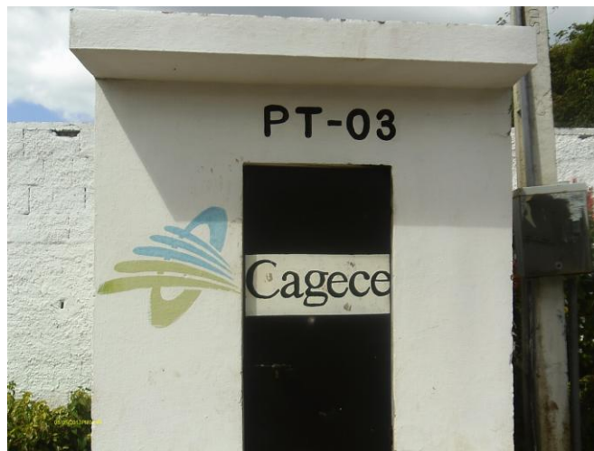
Foto 04 – Vista externa do PT-03.
