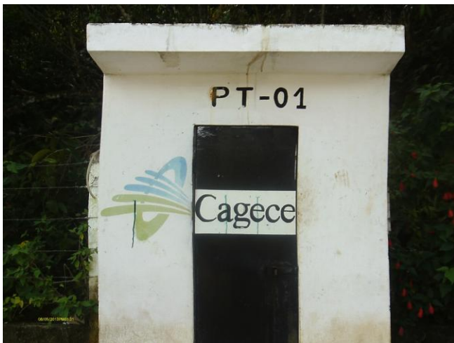
Foto 01 – Vista externa do PT-01.
