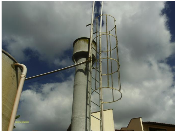
Foto 49 – Torre de equilíbrio.
