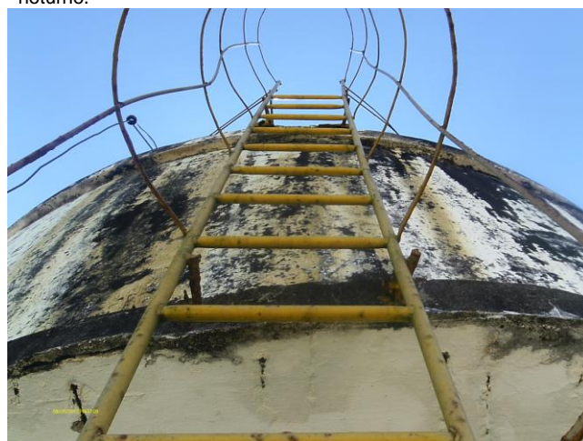
Foto 21 – REL-01 com escada e guarda-corpo.
