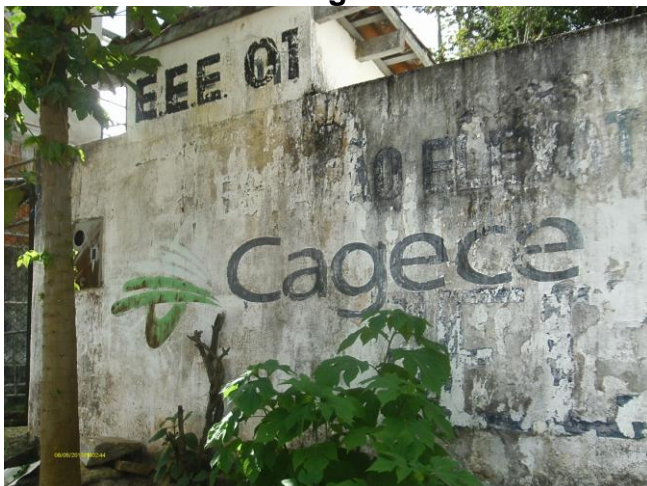
Foto 38 – Vista da externa da EEE-01.
