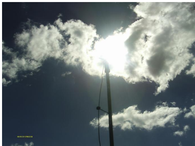
Foto 19 – REL-01: com existência de para-raios e sinalizador noturno.
