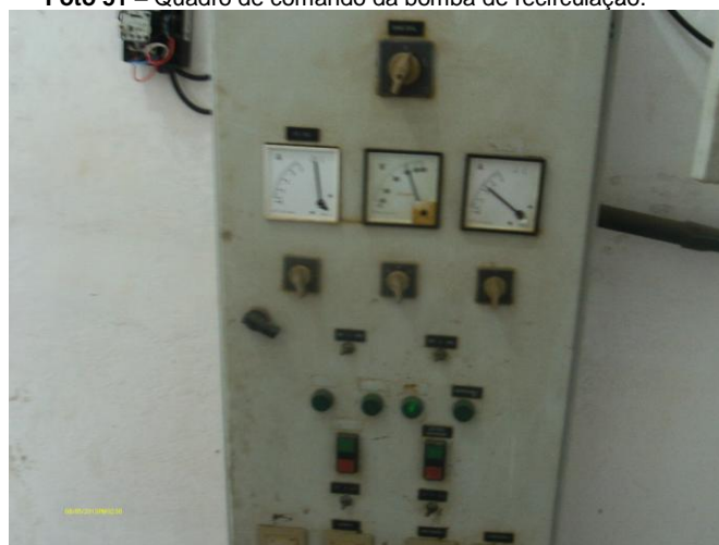
Foto 53 – Quadro de comando do compressor.
