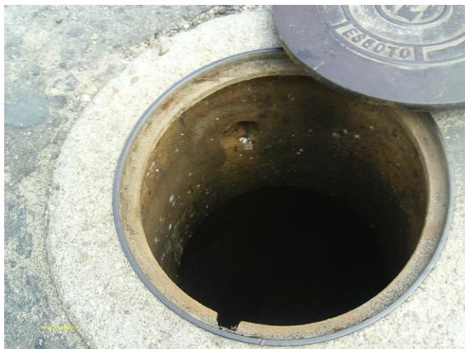
Foto 37 – PV no centro de Guaramiranga com tubo extravasor.
