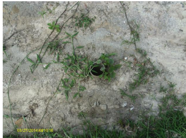
Foto 49 - Registro de descarga na rede de distribuição sem caixa localizado na Rua Joaquim Gabriel.
