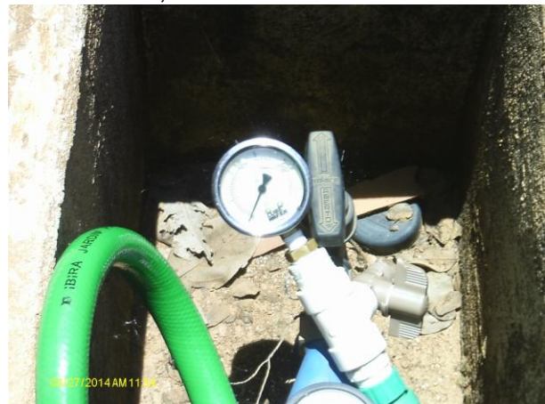
Foto 45 - Medição instantânea de pressão na rede de distribuição: Rua Irmã Diomira, 03.
