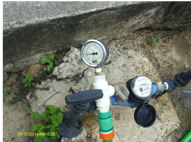
Foto 43 - Medição instantânea de pressão na rede de distribuição: Rua Luis Soares, S/N.
