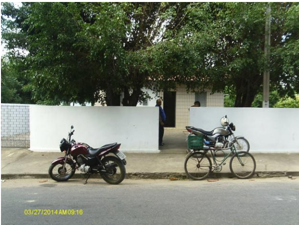
Foto 52 – Comercial/escritório: ausência de placa indicativa da CAGECE.
