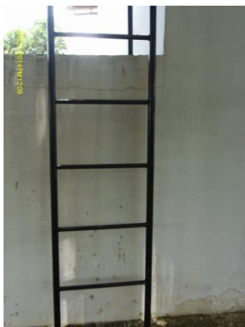
Foto 34 - RSE: escada de acesso.
