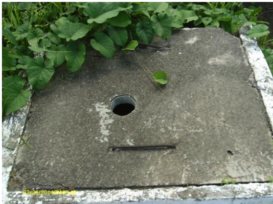
Foto 4 - AAT: ventosa instalada com caixa.
