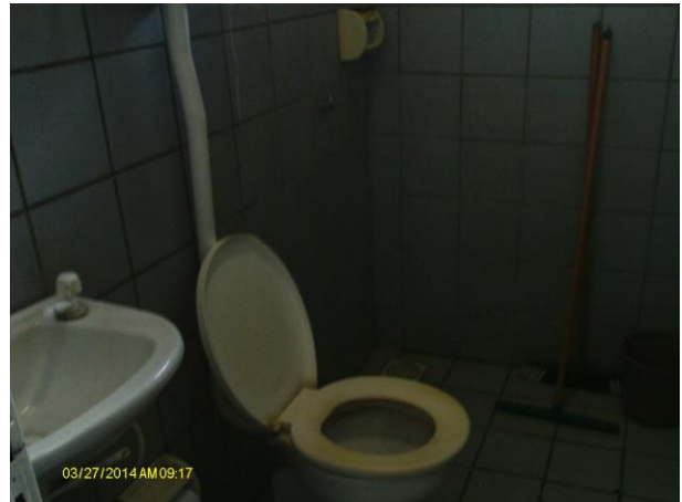
Foto 55 - Comercial/escritório: instalações sanitárias.
