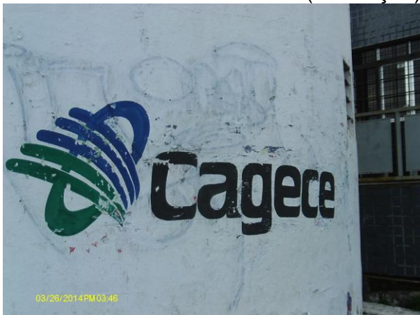
Foto 12 - EEAT-03: ausência de identificação da estação elevatória.
