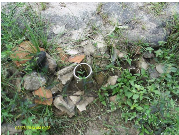
Foto 50 - Registro de descarga na rede de distribuição sem caixa localizado na Rua Santa Isabel.
