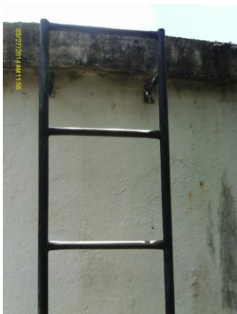
Foto 28 - RAP-08: escada de acesso.
