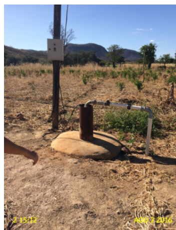
Foto 8 – PT-06: ausência de identificação.
