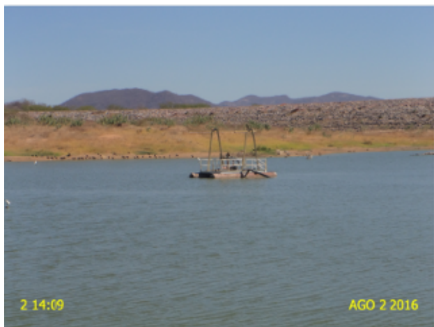
Foto 1 – EECS-01: ausência de bomba reserva.
