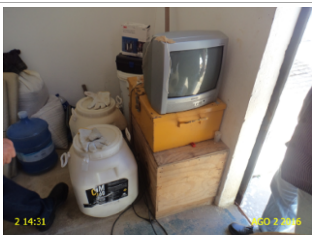
Foto 19 – ETA: KIT de emergência armazenados sob equipamentos.
