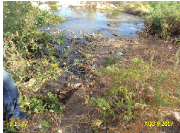
Foto 36 – ETE-04: local de descarga do efluente com aspecto inadequado e encoberto por vegetação.
