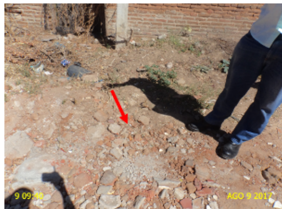
Foto 24 – RDA: registro de descarga soterrado na Rua Maximiniano Barreto - Bairro Fátima.
