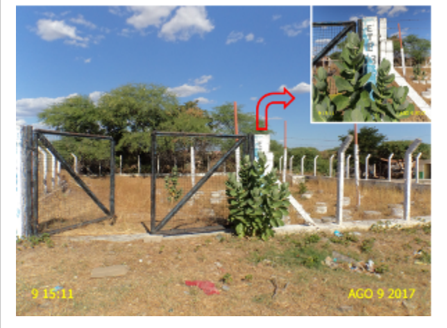
Foto 10 – ETE-03: identificação pouco visível e vegetação excessiva na área interna.
