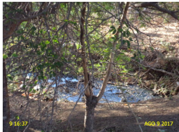
Foto 38 – ETE-12: local de descarga do efluente com aspecto inadequado e encoberto por vegetação.
