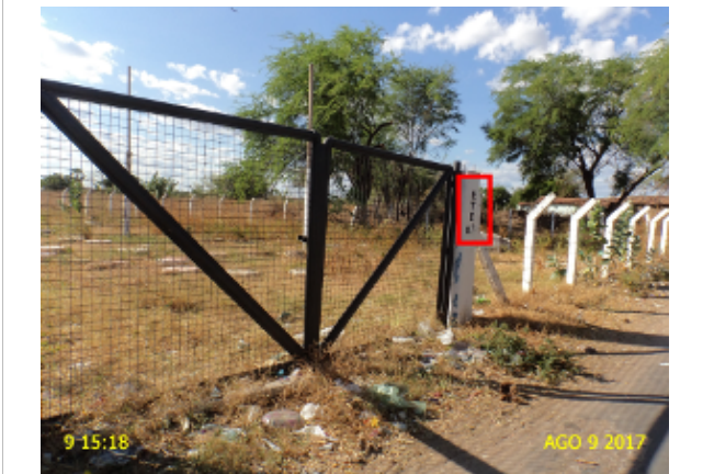
Foto 11 – ETE-06: identificação pouco visível e vegetação excessiva na área interna.
