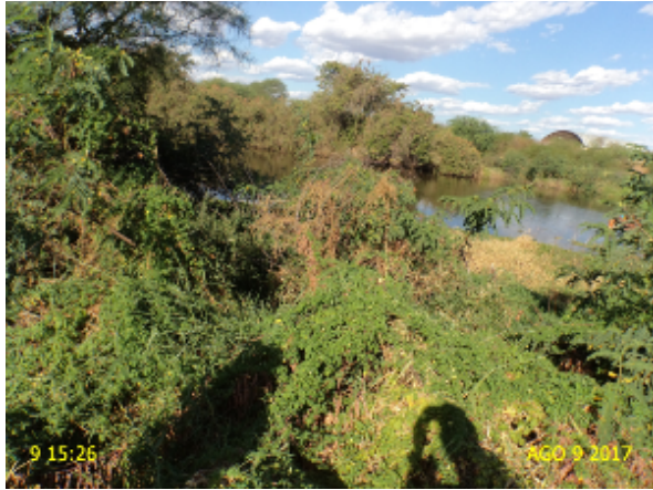
Foto 33 – ETE-01: local de descarga do efluente com aspecto inadequado e encoberto por vegetação.
