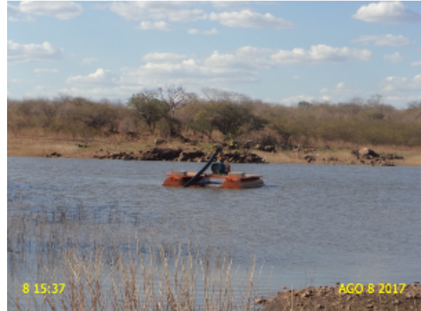
Foto 2 – EECS-08 (Belmonte): ausência de bomba reserva.
