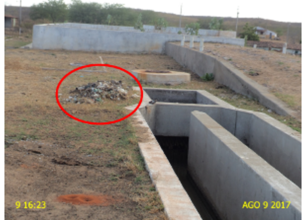
Foto 28 – ETE (Revoltosos): excesso de material, retidos do gradeamento e caixa de areia, fora do leito de secagem.
