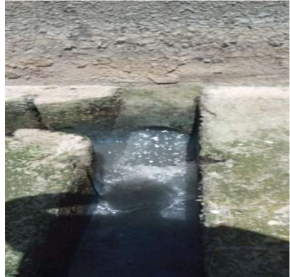
Foto 13 - EEE: Tubulação de esgoto afluyente.
