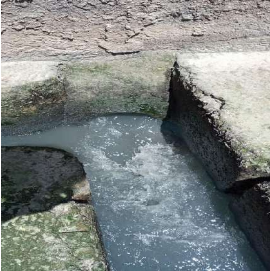
Foto 12 - EEE: Tubulação de esgoto afluyente.
