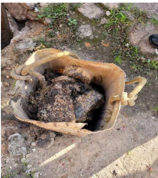
Foto 9 - Detritos oriundos de caixa de ligação.
