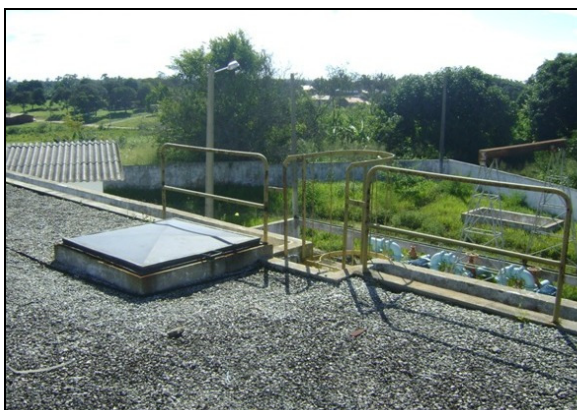
Foto 7 – Tampa de inspeção e escada de acesso do RAP-09.
