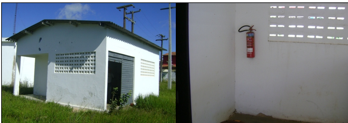
Foto 3 – Casa de abrigo do quadro da EEAT-05.
