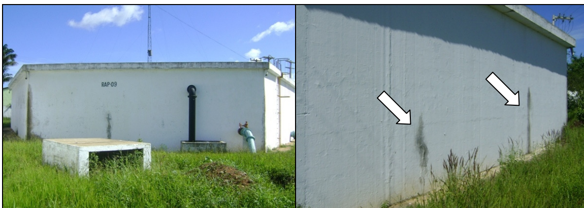
Foto 6 – Problema de infiltração na parede do RAP-09.
