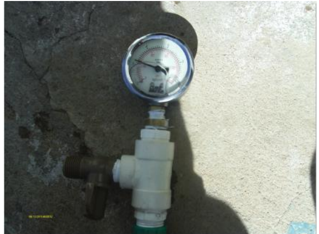
Foto 104 – Medição instantânea de pressão na Rua Frei Lambertto.
