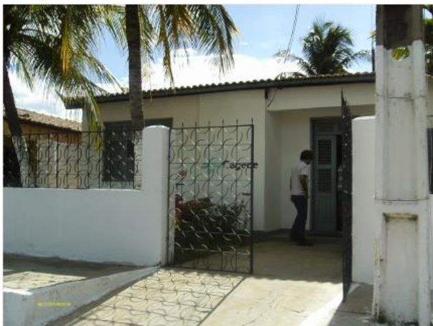
Foto 108 – Loja de atendimento: vista externa.
