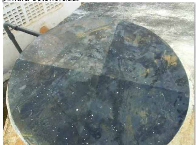
Foto 79 – RAP-01: tampa de inspeção.
