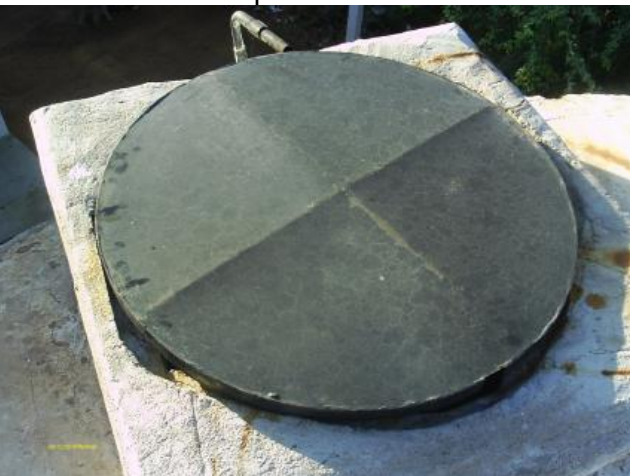
Foto 90 – RAP-03: tampa de inspeção.
