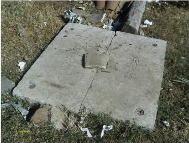
Foto 97 – Rede de distribuição: registro de descarga na Rua Geracinda Bessa Moura.
