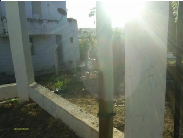
Foto 76 – REL-01: medidor de nível.
