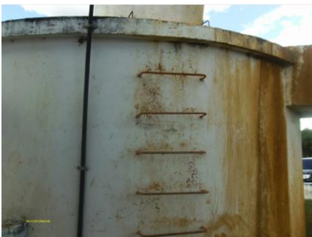
Foto 78 – RAP-01: escada de acesso.
