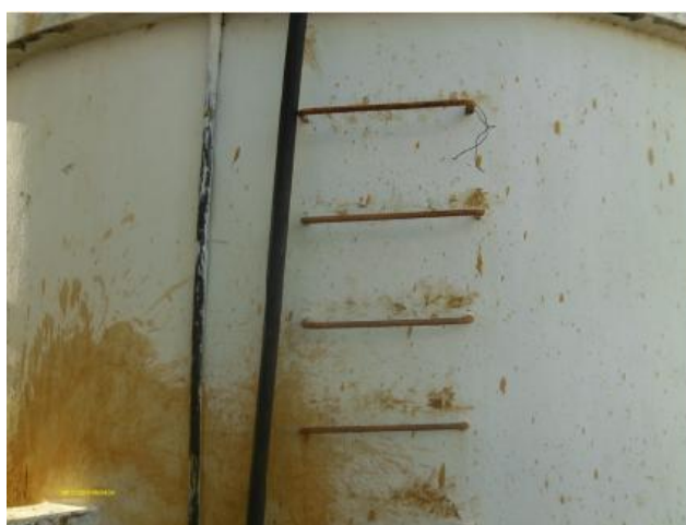
Foto 83 – RAP-02: escada de acesso.
