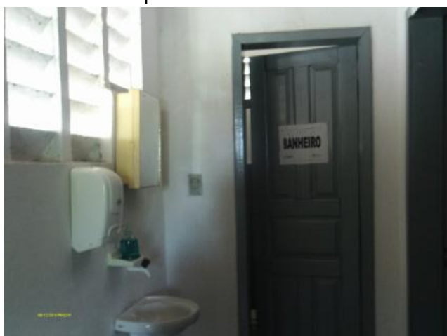
Foto 112 – Loja de atendimento: instalações sanitárias.
