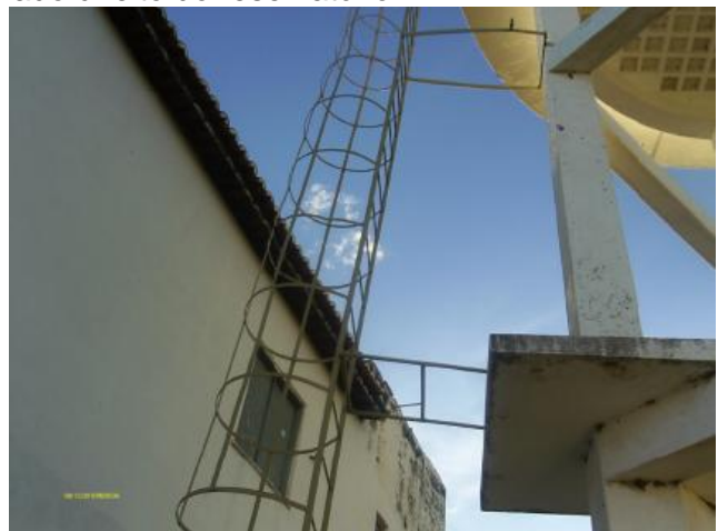
Foto 73 – REL-01: escada com guarda-corpo.
