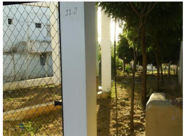
Foto 71 – REL-01: ausência de isolamento do lado direito do reservatório.
