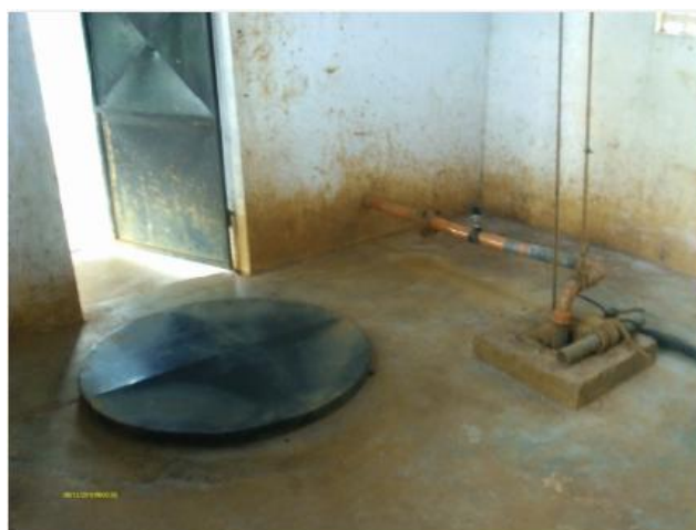
Foto 28 – PA-01: vista geral.
