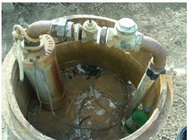
Foto 3 – PT-03: laje de proteção.
