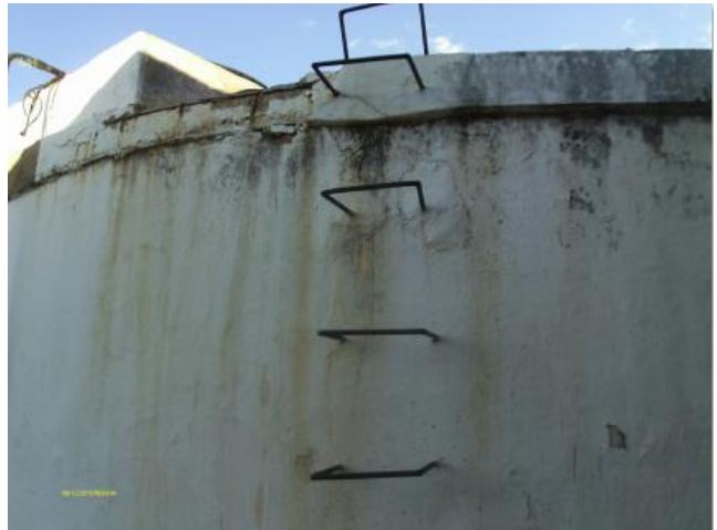
Foto 89 – RAP-03: escada de acesso.
