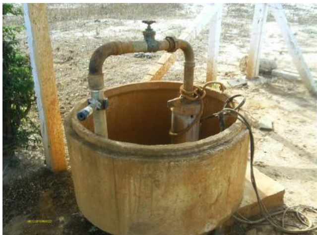
Foto 11 – PT-07: laje de proteção.
