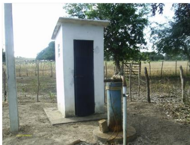
Foto 16 – PT-11: ausência de cercado e identificação.
