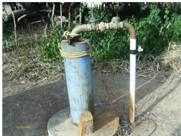
Foto 18 – PT-11: laje de proteção.
