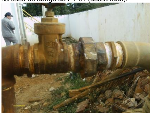
Foto 21 – PT-12: vazamento.
