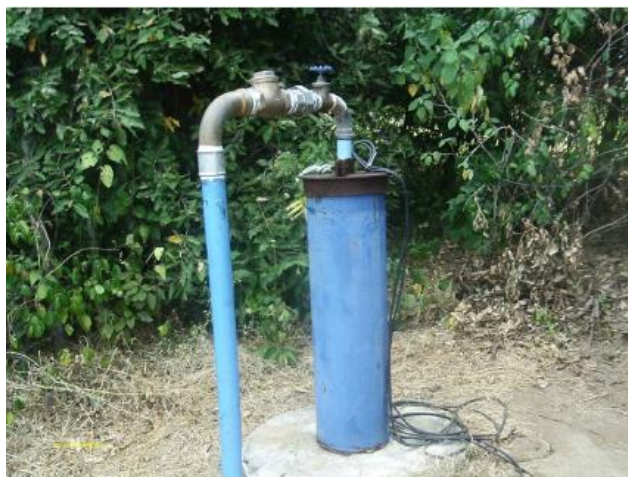
Foto 24 – PT-13: laje de proteção.
