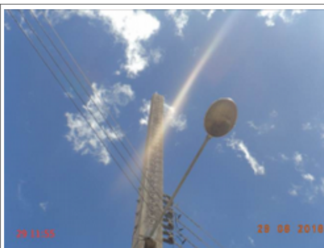
Foto 2 - Captação subterrânea: poço PT-05 sem iluminação para trabalhos noturnos (ausência de lâmpada).
