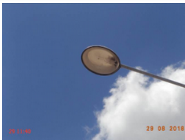
Foto 3 - Captação subterrânea: Poço PT-07 sem iluminação para trabalhos noturnos (ausência de lâmpada).
