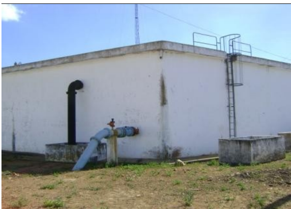
Foto 14 – RAP-10 (Corrente) – escada de acesso externo.
