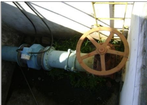
Foto 24 – RAP-09 – macro-medidor eletrônico.
