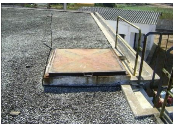
Foto 10 – RAP-09 – tampa de inspeção.
