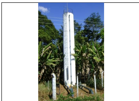
Foto 30 – TAU na adutora de água tratada.
