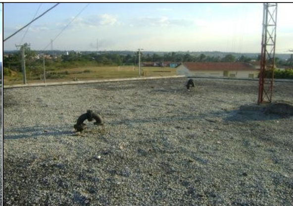
Foto 13 – RAP-10 (Corrente) – tubulação de ventilação.
