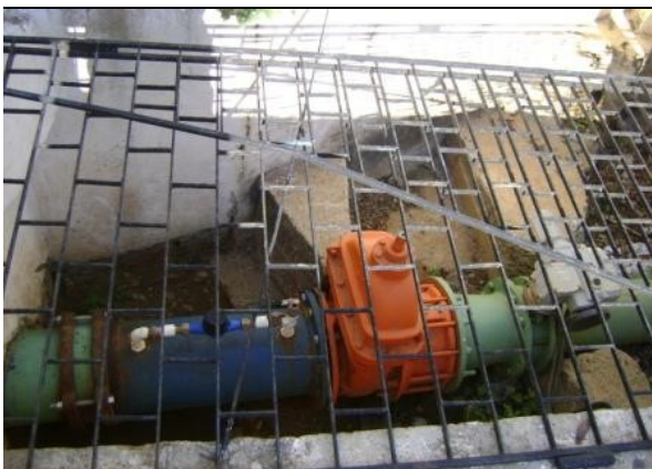
Foto 26 – REL-Centro – macro-medidores eletrônico e proporcional.
