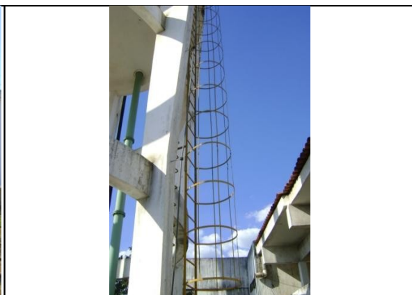
Foto 15 – REL-Centro – escada de acesso externo.
