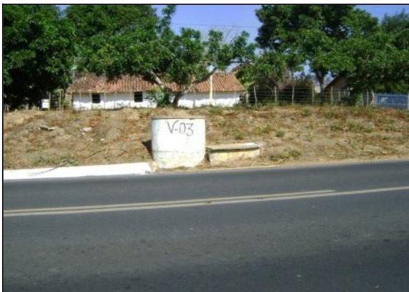
Foto 28 – Caixa de ventosa na adutora de água tratada.
