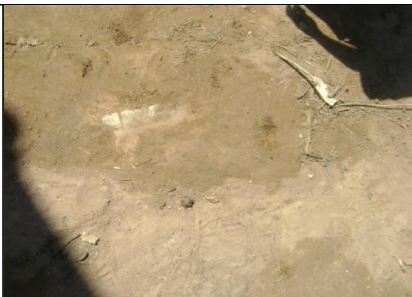
Foto 32 – Registro de descarga soterrado na Rua SDO, 41, Santa Inês.
