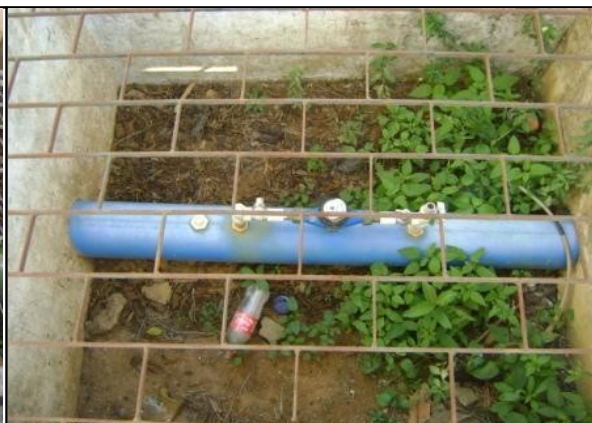
Foto 27 – REL-Cruzeiro – macro-medidor proporcional.
