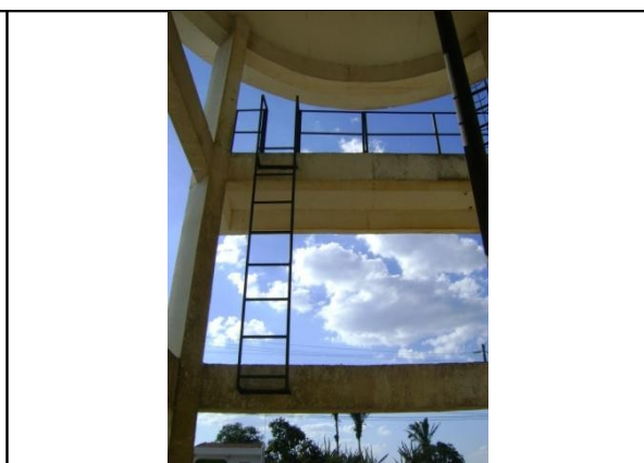
Foto 17 – REL-Cruzeiro – escada de acesso externo.
