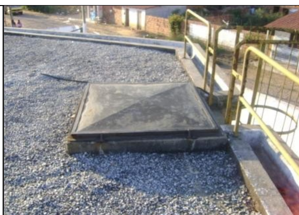
Foto 11 – RAP-10 (Corrente) – tampa de inspeção.
