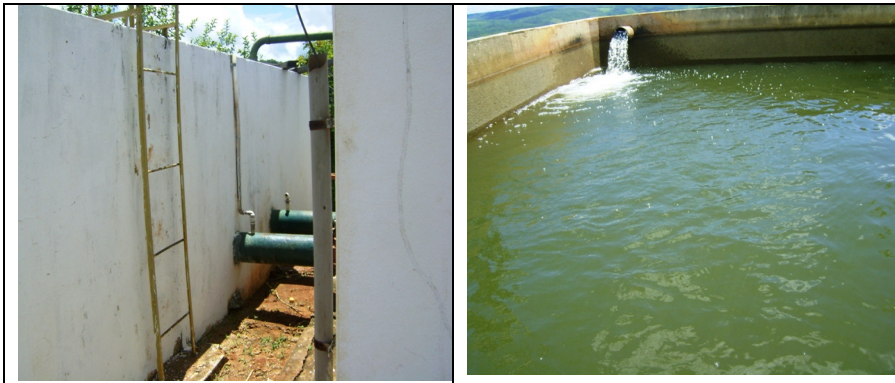
Fotos 30 e 31 – Vistas do RAP – 02
