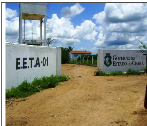
Foto 5 – Vista da entrada da ETA do SAA de Altaneira
