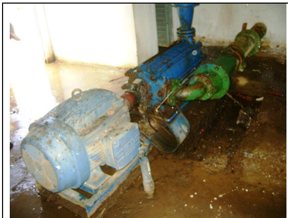
Foto 16 – Vista da da EEAB-02
