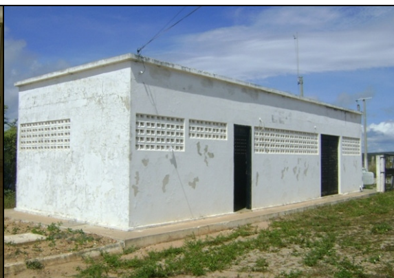
Foto 31 – Casa de abrigo do quadro da EEAB-01.
