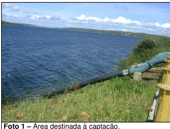
Foto 1 – Área destinada à captação.
