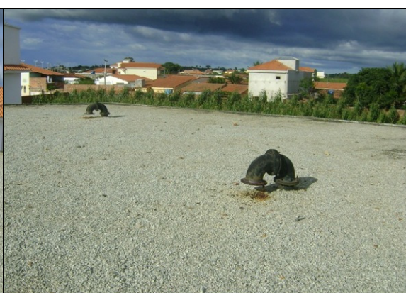
Fotos 59 e 60 – ventilações do RAP (Tianguá), sem tela de proteção.
