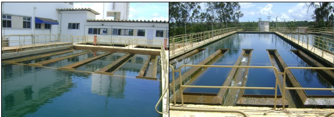
Fotos 4 e 5 – Vistas dos decantadores.
