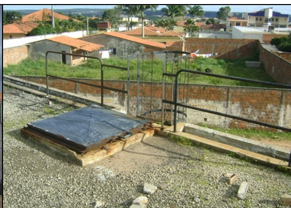
Foto 58 – Tampa de inspeção e escada do RAP (Tianguá).
