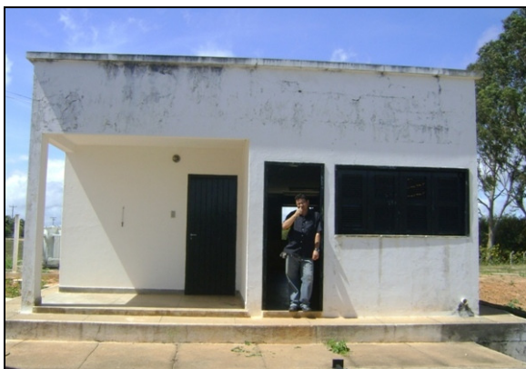
Foto 39 – Casa de abrigo do quadro da EEAT-02.
