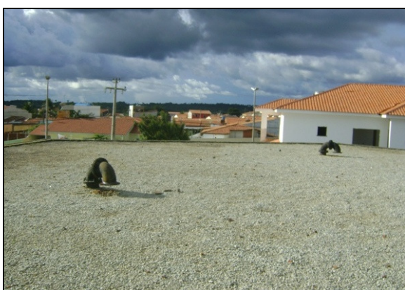
Fotos 59 e 60 – ventilações do RAP (Tianguá), sem tela de proteção.
