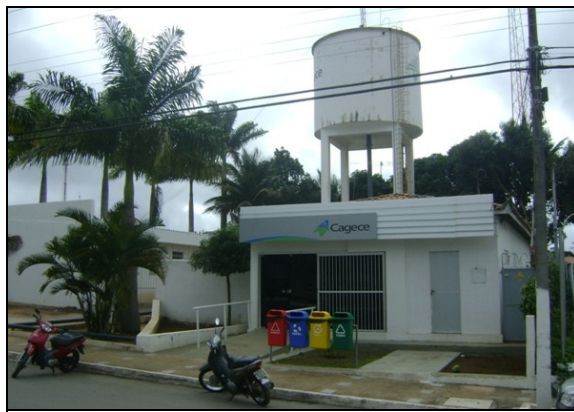
Foto 73 – Vista externa do escritório da CAGECE.
