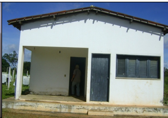
Foto 43 – Casa de abrigo do quadro da EEAT-03.
