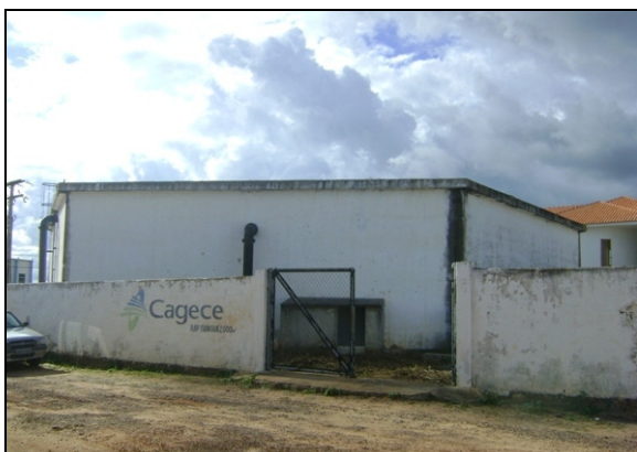
Foto 57 – Vista do RAP (Tianguá).
