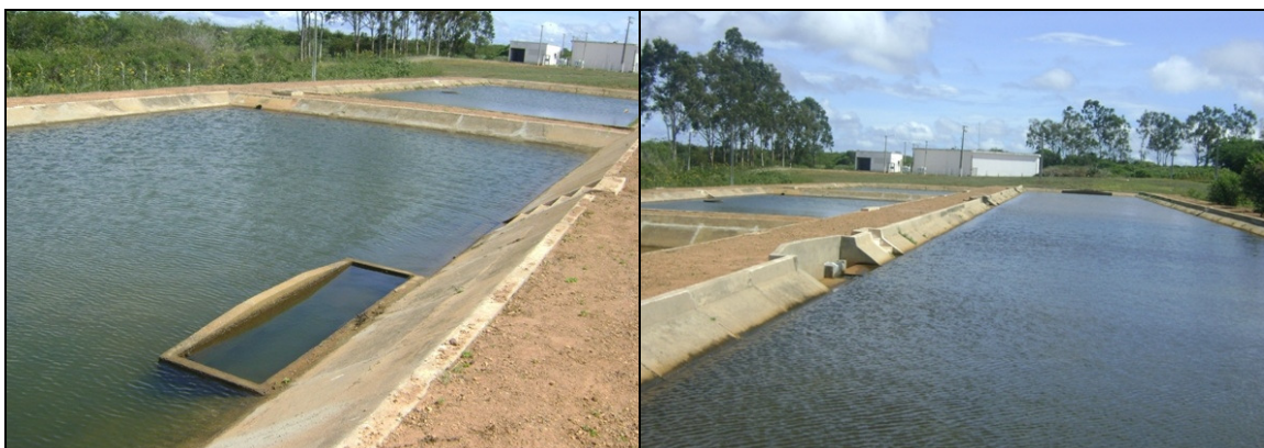
Fotos 12 e 13 – Vistas dos leitos de secagem.
