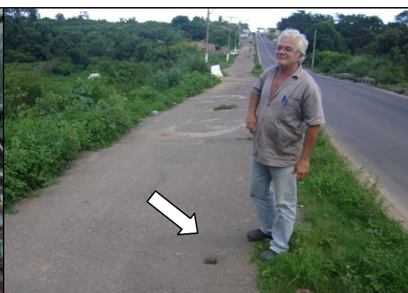
Foto 72 – Registro de descarga localizado na Av. Jaques Nunes, Centro.
