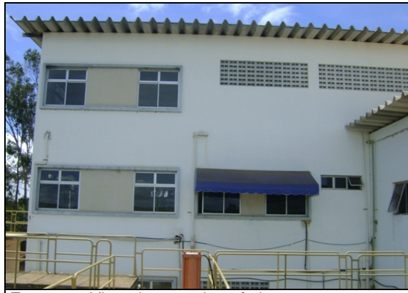
Foto 14 – Vista da casa de química.
