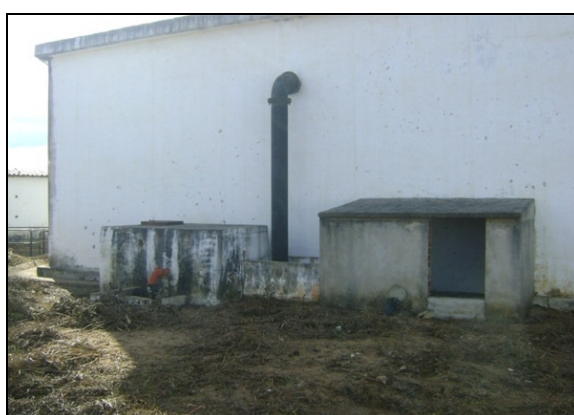
Foto 46 – Prédio de abrigo da EEAT-04.
