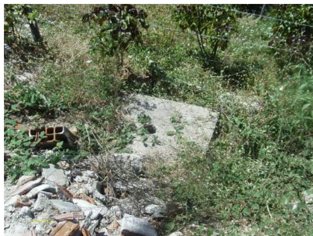
Foto 54 – Rede de distribuição: registro de descarga na Rua Manoel Castro Filho (1).
