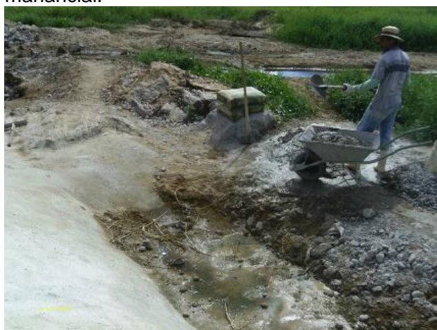
Foto 4 – Rio Sangue: obras na captação.
