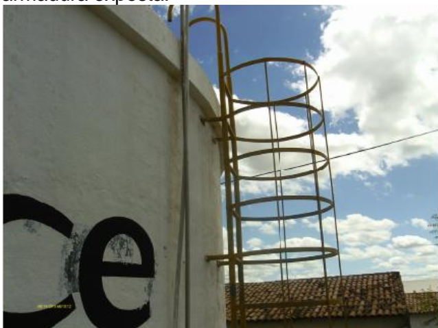
Foto 44 – RSE-01: escada com guarda-corpo.
