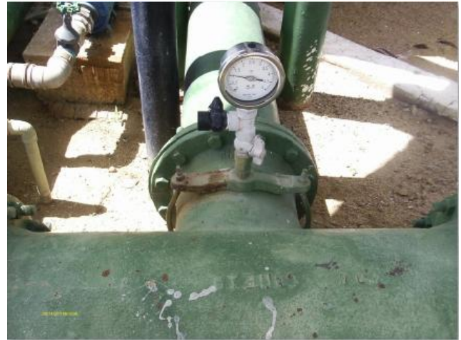
Foto 41 – REL-01: medidor de nível.
