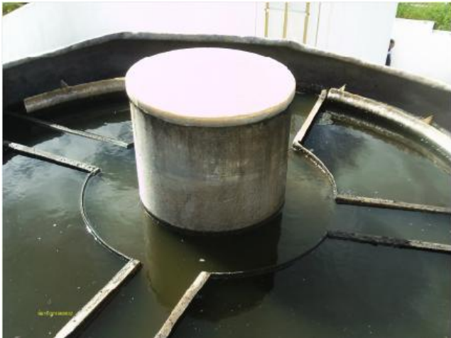
Foto 79 – Reator aeróbio.
