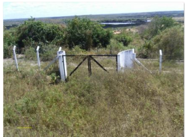
Foto 49 – RAP-02: vegetação na área do reservatório-sem acesso pelo portão.
