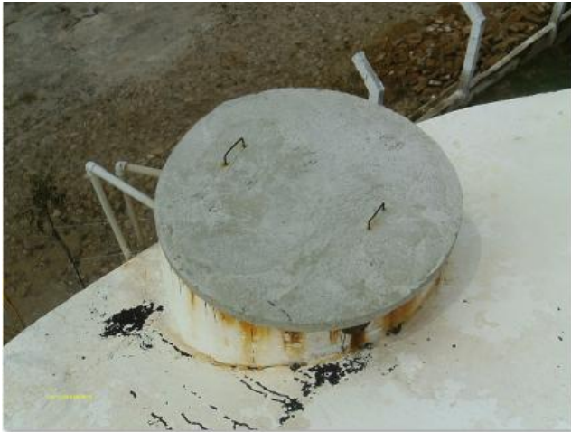
Foto 46 – RSE-01: tampa de inspeção.
