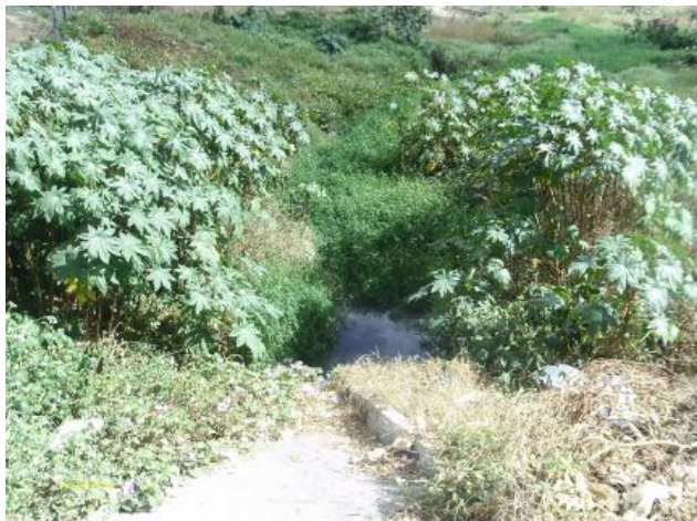
Foto 67 – local de destinação final do esgoto.
