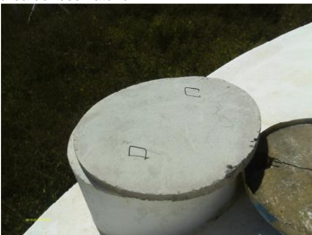
Foto 50 – RAP-02: tampa de inspeção.
