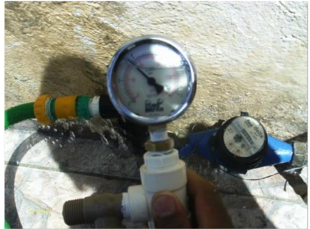
Foto 64 – Medição instantânea de pressão na Av. Manoel Castro Filho (Prédio da Assembléia de Deus).
