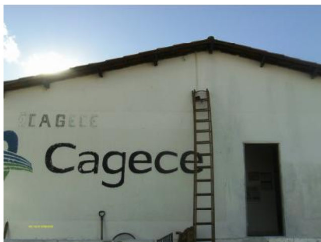
Foto 88 – Loja de atendimento: vista externa.
