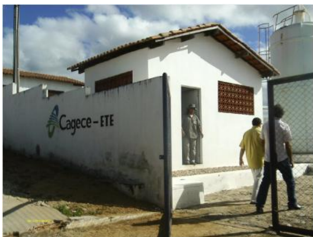
Foto 69 – Área de acesso a ETE.
