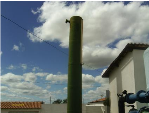
Foto 12 – ETA: torre de nível.
