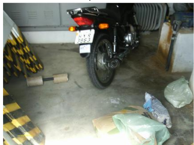
Foto 37 – EELF-01: armazenamento de materias na casa de abrigo da elevatória.
