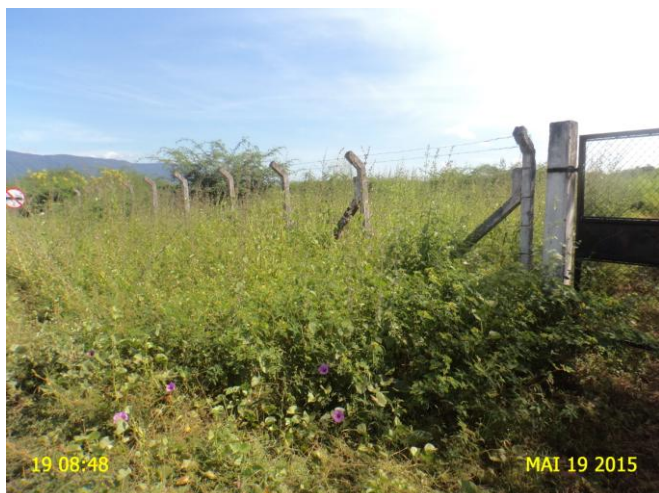
Foto 22 - ETE: área de acesso com vegetação excessiva.
