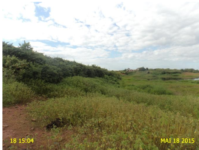
Foto 37 - Captação superficial: vegetação excessiva na área de acesso à captação no Açude Sítio Escorredouro.
