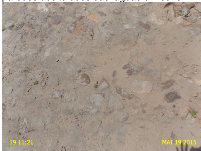
Foto 27 - RDA: Registro de descarga soterrado: Rua Valdemar Ferreira de Almeida.
