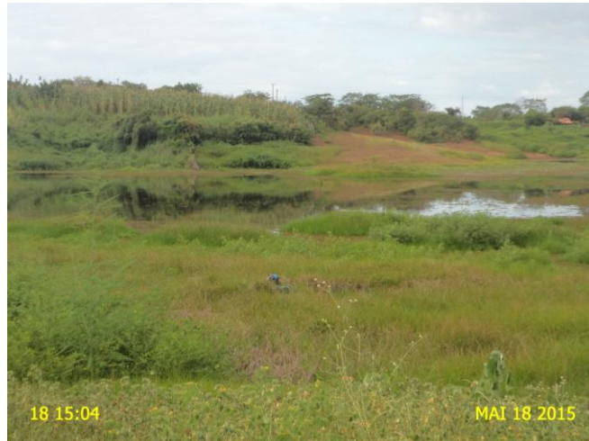
Foto 35 – Captação Superficial: sem sinalização indicando que a área é destinada ao abastecimento público.
