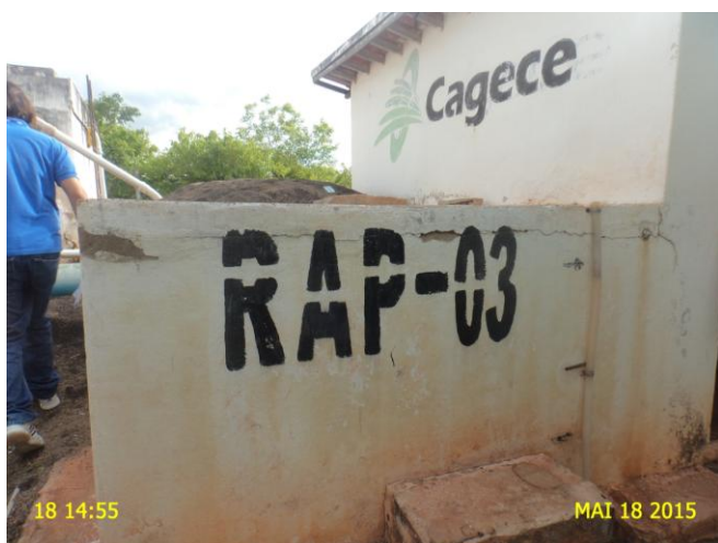
Foto 32 - RAP-02: rachadura na parede.
