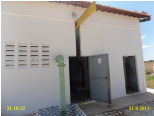
Foto 3 - EEAT-01/EELF-01: ausência de identificação.
