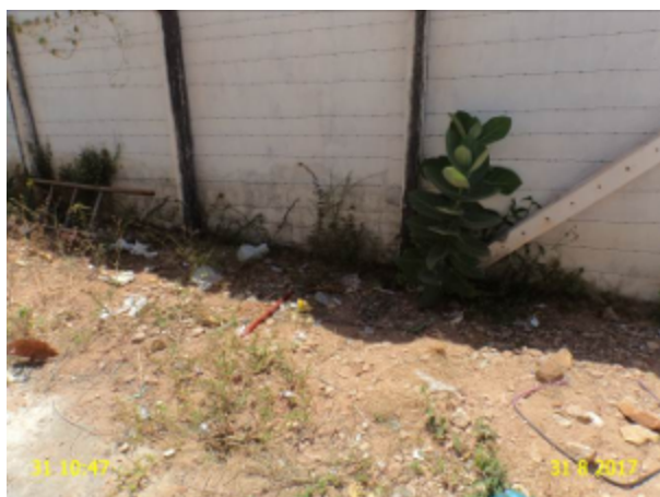
Foto 1 REL-01: acúmulo de lixo na área do reservatório.
