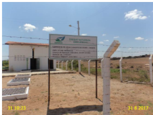
Foto 16 - ETA: placa com data de validade da licença de operação da SEMACE vencida em maio/2017.
