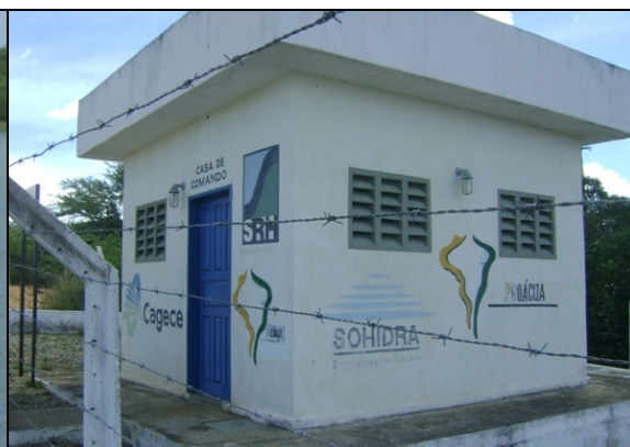
Foto 25 – Casa de comando da captação.
