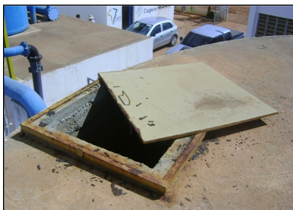
Foto 34 – Visita do RAP-03.
