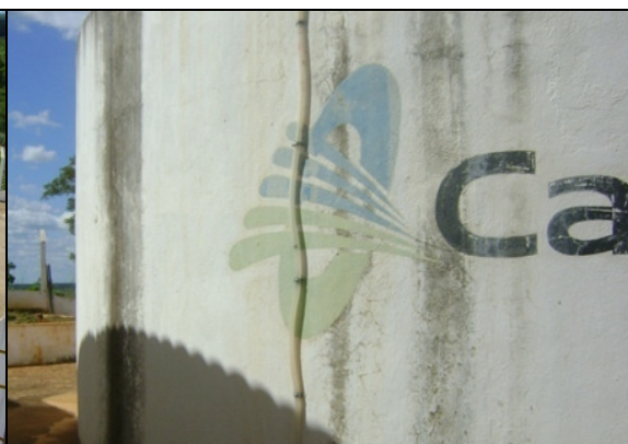
Foto 31 – Medidor de nível do RAP-03.
