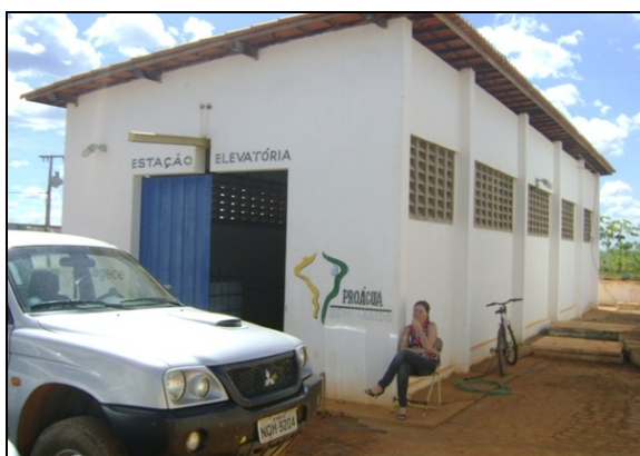
Foto 27 – Abrigo da elevatória EE-02.
