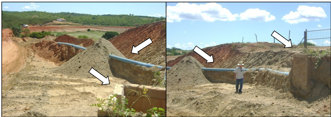
Fotos 44 e 45 – Adutora e caixa de registro expostas.
