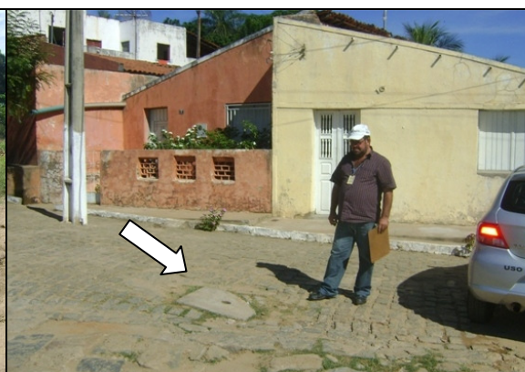
Foto 51 – Registro de descarga, Rua Ozório Correia Lima.
