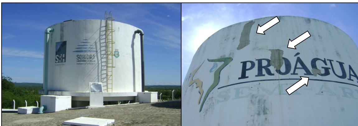
Fotos 35 e 36 – Vistas do reservatório REL-04.
