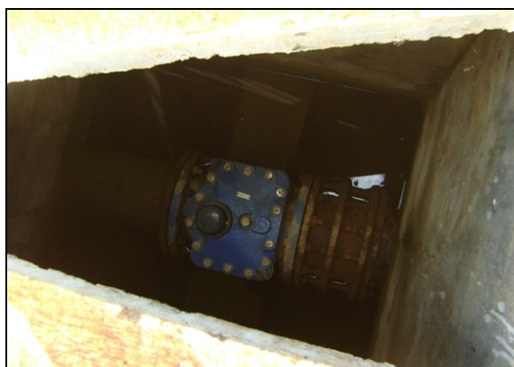
Foto 43 – Macro-medidor na saída da ETA.
