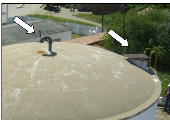
Foto 41 – Ventilação e visita do RAP-02.
