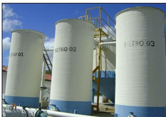
Foto 10 – Vista dos filtros.
