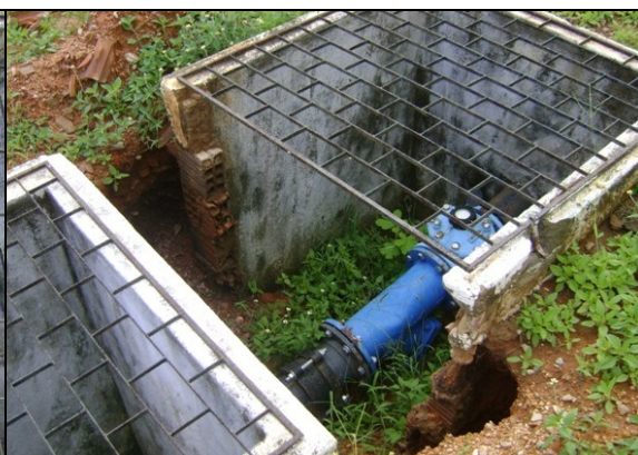
Fotos 57 e 58 – Vistas do macromedidor de água tratada na entrada do REL-01.
