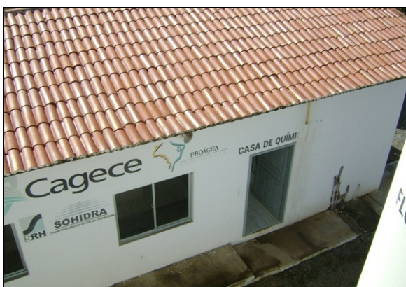
Foto 14 – Vista da casa de química.
