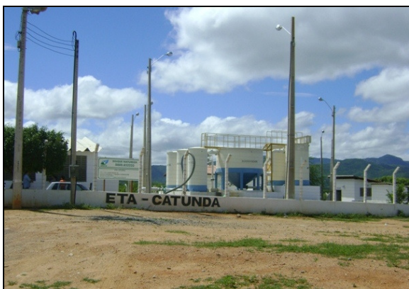
Foto 3 – Entrada da ETA.
