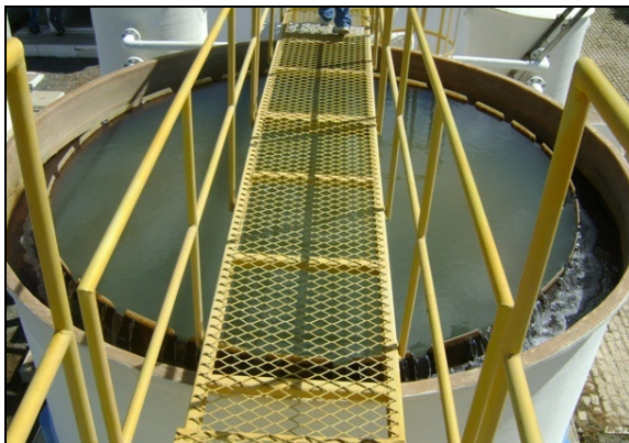
Foto 9 – Vista do decantador.
