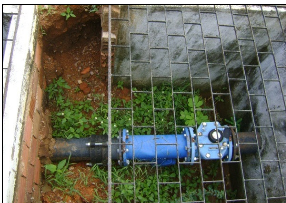
Fotos 57 e 58 – Vistas do macromedidor de água tratada na entrada do REL-01.
