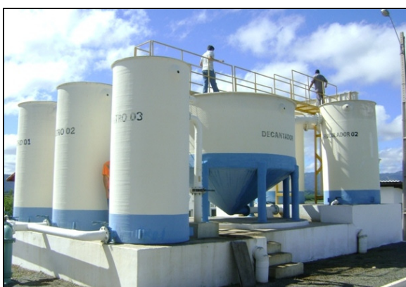
Foto 5 – Vista geral da ETA.
