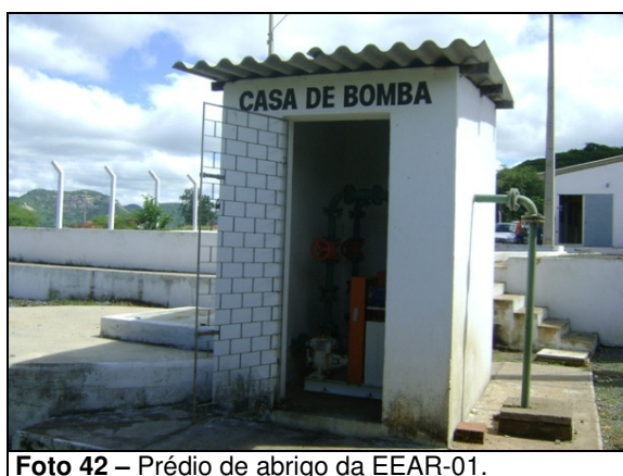
Foto 42 – Prédio de abrigo da EEAR-01.
