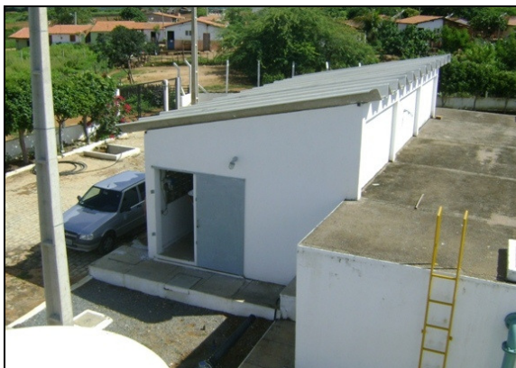
Foto 37 – Prédio de abrigo das elevatórias EELF-01, EEAT-01 e EEAT-02.
