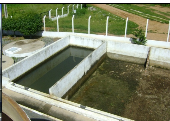
Foto 6 – Vista dos leitos de secagem.
