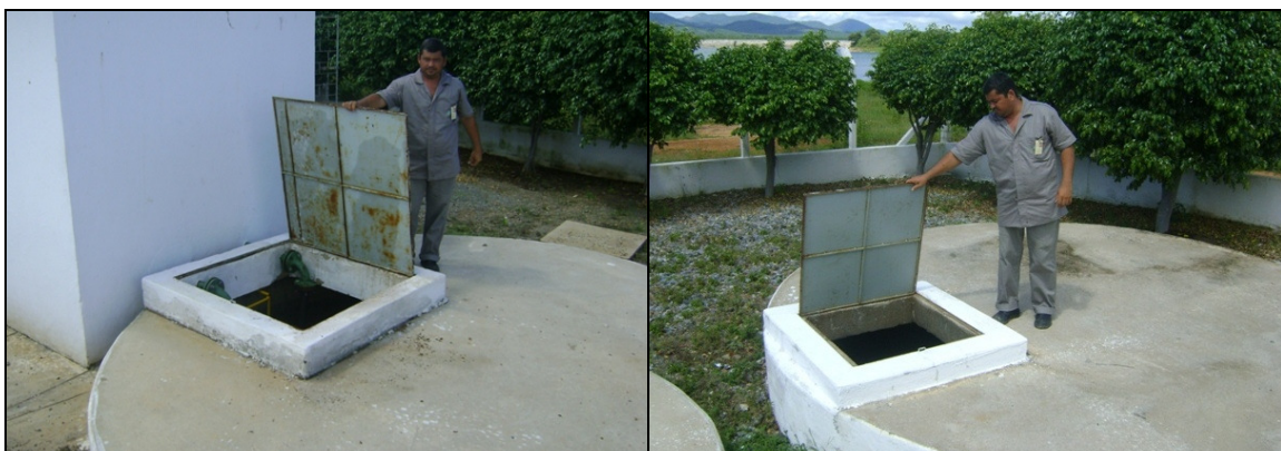
Fotos 51 e 52 – Visitas dos tanques de reuso.
