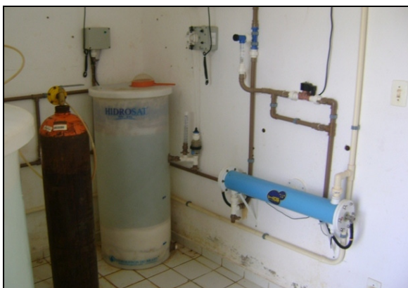
Fotos 16 e 17 – Vistas da fábrica de cloro e dos cilindros de cloro gasoso.
