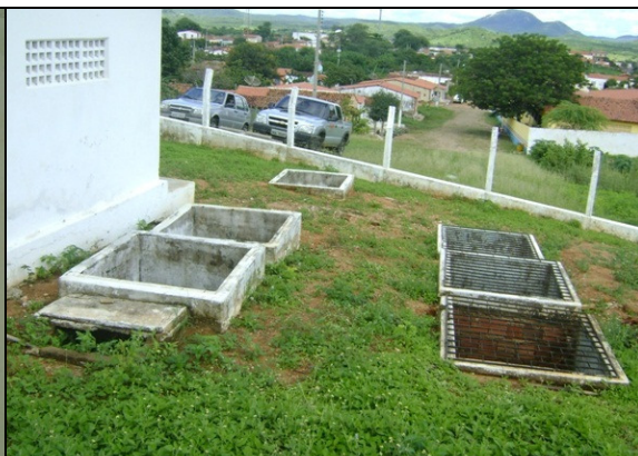
Foto 49 – Caixas de registro do REL-01.
