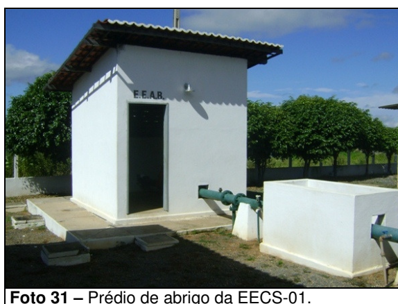
Foto 31 – Prédio de abrigo da EECS-01.
