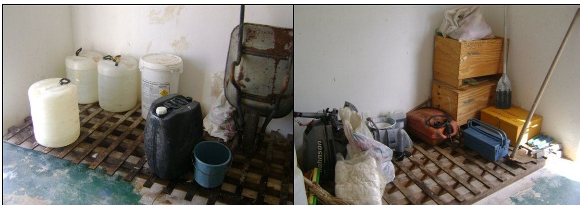
Fotos 18 e 19 – Armazenamento de materiais e produtos químicos.
