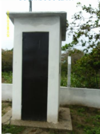
Foto 19 - PT-07: casa de abrigo do QC.
