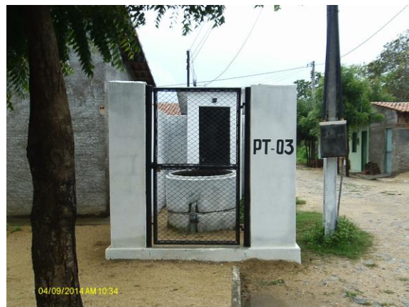
Foto 4 - PT-03: acesso, cerca delimitadora e identificação.
