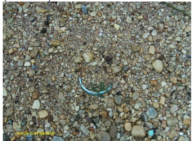
Foto 51 - Registro de descarga na rede de distribuição: Rua Celso Patrício.
