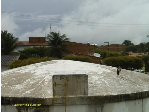
Foto 35 - RAP-01: cobertura, tampa de inspeção e tubulação de ventilação.
