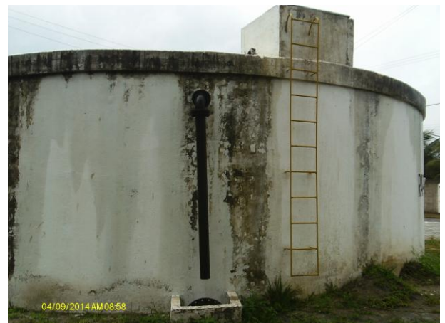
Foto 34 - RAP-01: escada de acesso, tubo extravasor.
