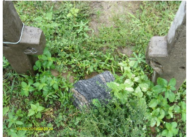
Foto 49 - Registro de descarga na rede de distribuição: Rua João Muniz (soterrado).
