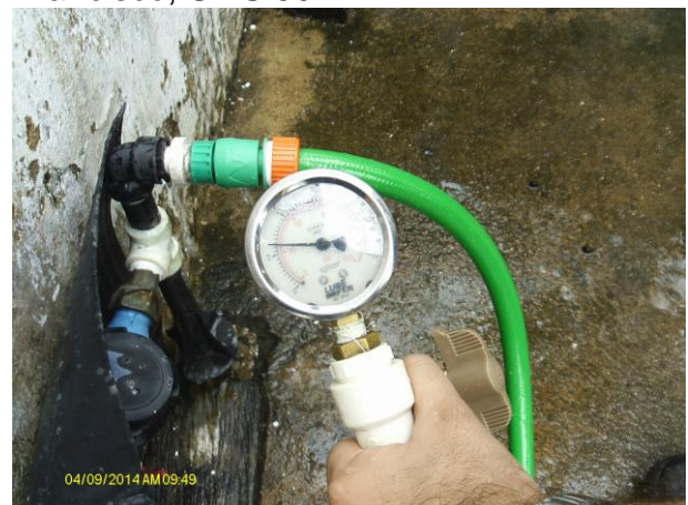
Foto 45 - Medição instantânea de pressão na rede de distribuição: Rua Duca da Silveira, 10.
