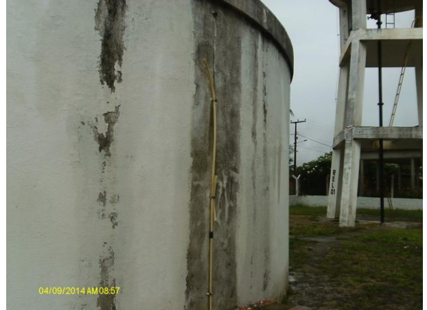
Foto 36 - RAP-01: medidor de nível.
