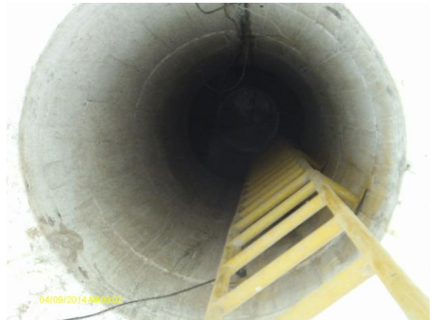
Foto 38 - REL-01: escada de acesso e tampa de inspeção.
