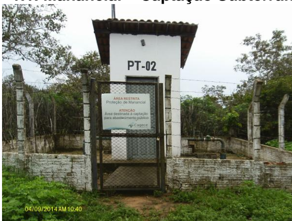
Foto 1 - PT-02: acesso, cerca delimitadora e identificação.
