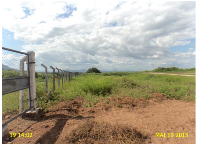
Foto 14 - ETE: vegetação excessiva.
