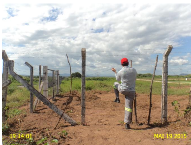
Foto 12 – ETE: acesso feito pela cerca.
