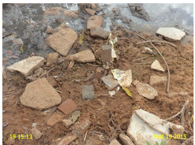
Foto 18 - RDA: Registro de descarga soterrado - Rua Beira Rio.
