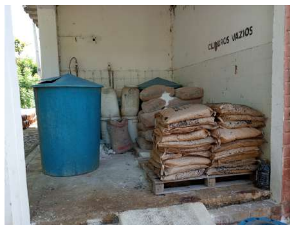
Foto 5 - ETA: almoxarifado com condições de manutenção e limpeza inadequadas.
