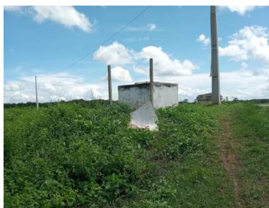
Foto 17 - ETE: placa indicativa da área está danificada.
