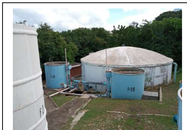
Foto 1 - ETA: Filtros F-05 e F-06 não possuem tampas.
