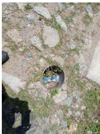
Foto 12 - REL-01: registro sem caixa.
