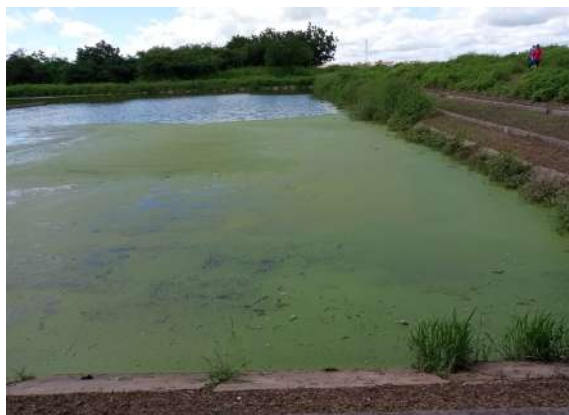
Foto 31 - ETE: presença de sólidos grosseiros, matos crescidos e placas erodidas na LM.
