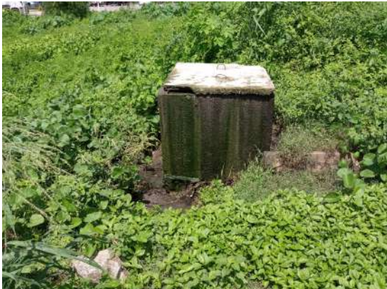
Foto 26 - ETE: o acesso ao tratamento preliminar não oferece condições de segurança.
