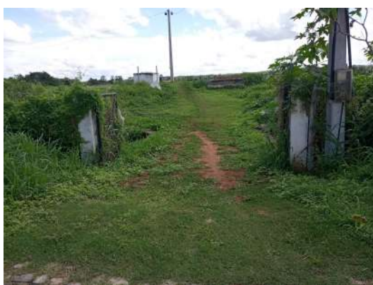
Foto 16 - ETE: portão de acesso encontra-se emperrado.
