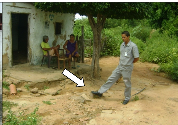
Foto 30 – Registro de descarga, Rua SDO-01.
