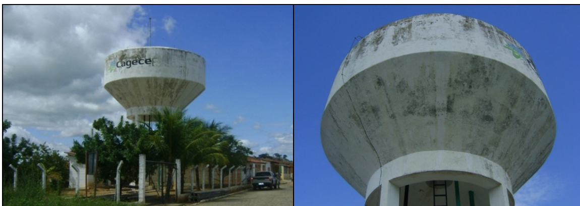
Fotos 20 e 21 – Vistas do reservatório REL-01.
