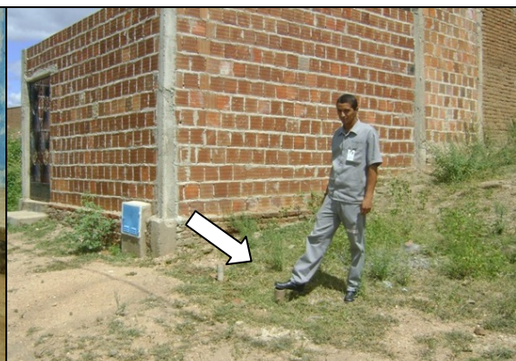
Foto 32 – Registro de descarga, Rua SDO-02.
