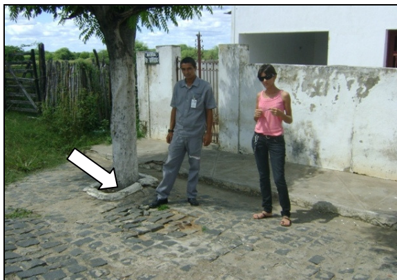
Foto 29 – Registro de descarga, Rua Capitão Albano.
