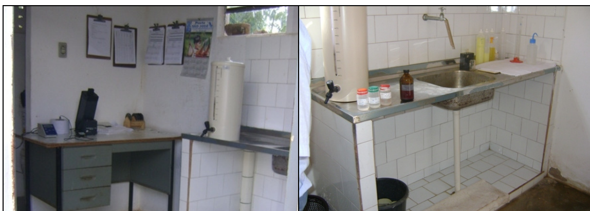
Foto 14 e 15 – Vistas do laboratório da ETA.
