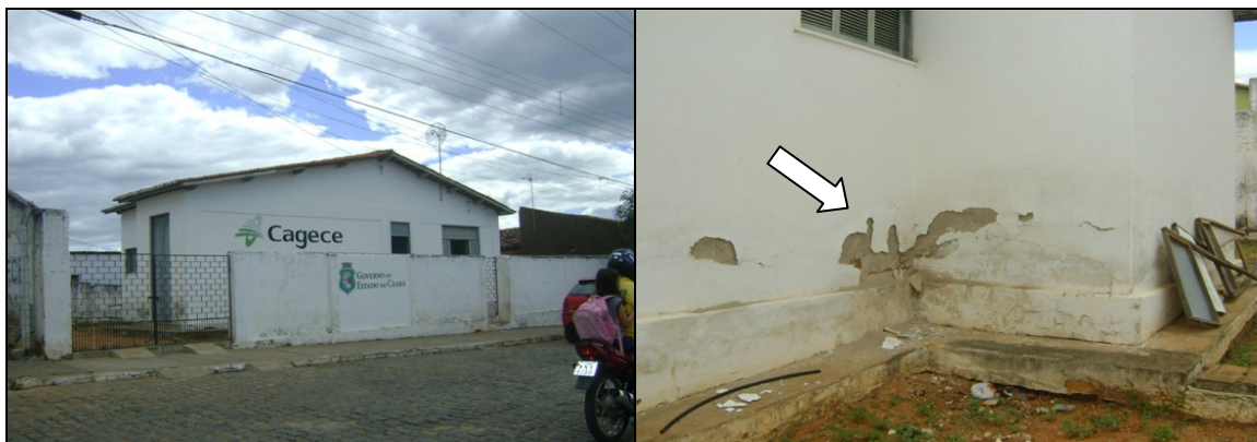
Fotos 34 e 35 – Vistas externas do escritório da CAGECE.
