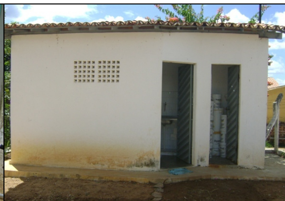
Foto 12 – Laboratório e depósito da ETA.
