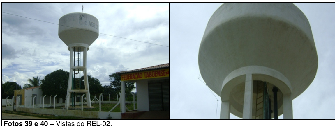
Fotos 39 e 40 – Vistas do REL-02.
