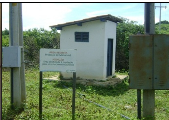
Foto 24 – Prédio de abrigo do quadro de comando da EECS-01.
