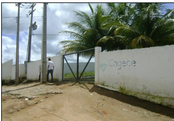
Foto 3 – Entrada da ETA.
