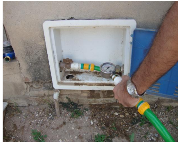
Foto 36 – Medição de pressão instantânea na Avenida Patativa do Assaré, nº 449 – Centro.
