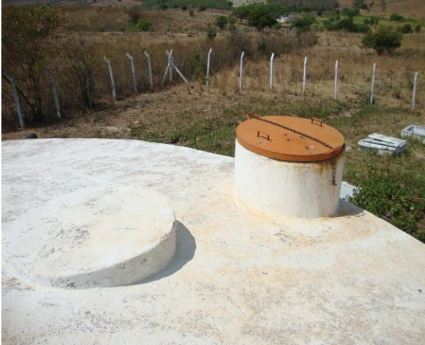
Foto 27 – RAP-02: tampa de inspeção em adequada condição de vedação.
