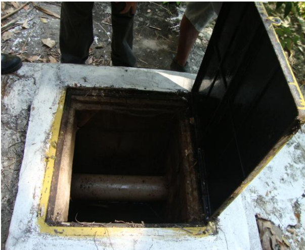
Foto 23 – RAP-01/Fonte: tampa de inspeção.
