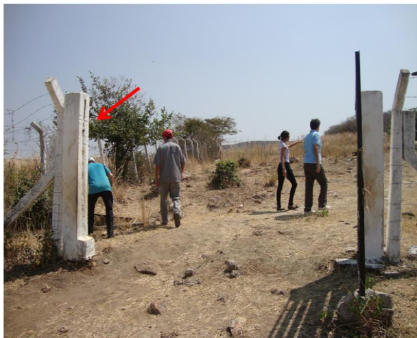
Foto 5 – Portão de acesso ao RAP-02.
