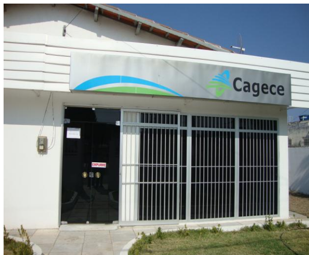
Foto 51 – Vista externa do escritório/loja de atendimento ao usuário.
