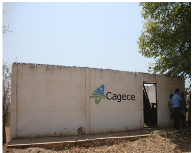
Foto 32 – Vista externa do RAP-03 (desativado).
