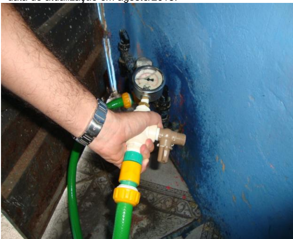
Foto 37 – Medição de pressão instantânea na Rua São Pedro, nº 670 – Centro.
