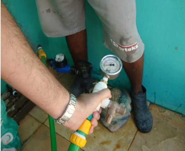
Foto 39 – Medição de pressão instantânea na Rua Central, nº 273 – Distrito Inhumas.
