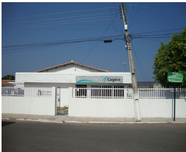
Foto 50 – Vista externa do escritório/loja de atendimento ao usuário.
