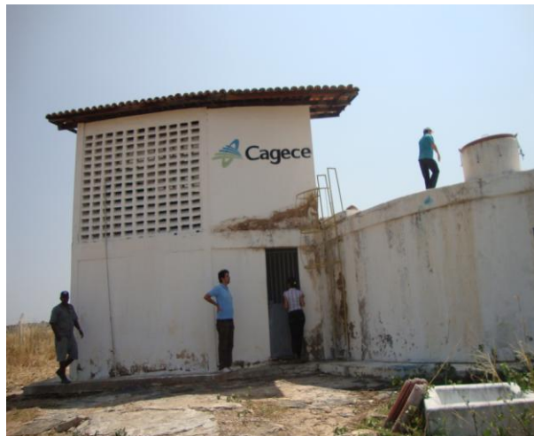
Foto 6 – Vista externa da casa de química.
