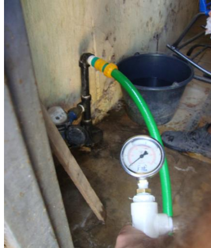
Foto 40 – Medição de pressão instantânea na Rua Nova - Distrito Inhumas, nº 124.
