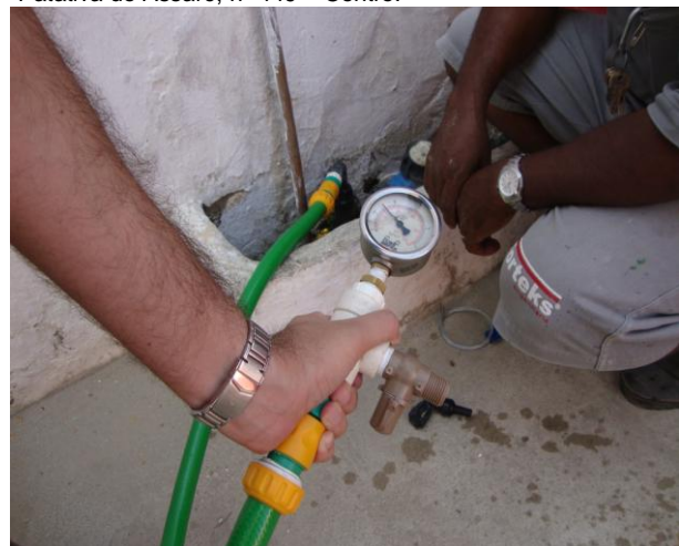
Foto 38 – Medição de pressão instantânea na Rua Dep. Furtado Leite, nº 293 (Centro Educacional e de Cultura Artística) – Centro.
