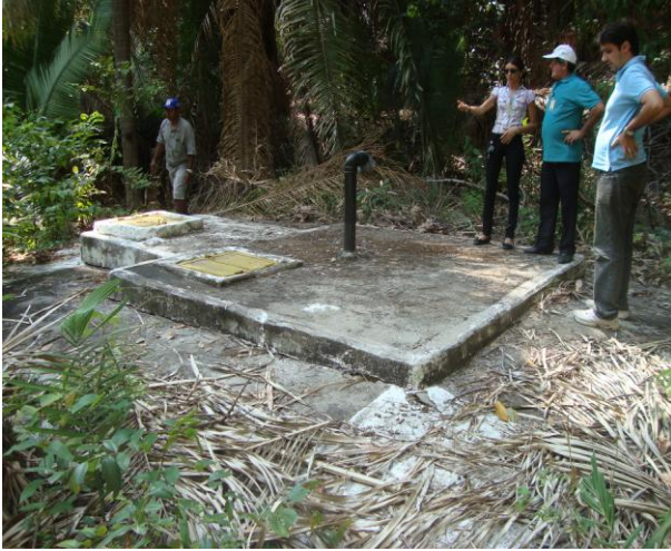
Foto 21 – Vista do RAP-01/Fonte.
