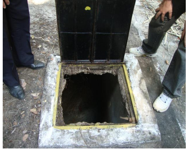
Foto 22 – RAP-01/Fonte: tampa de inspeção.
