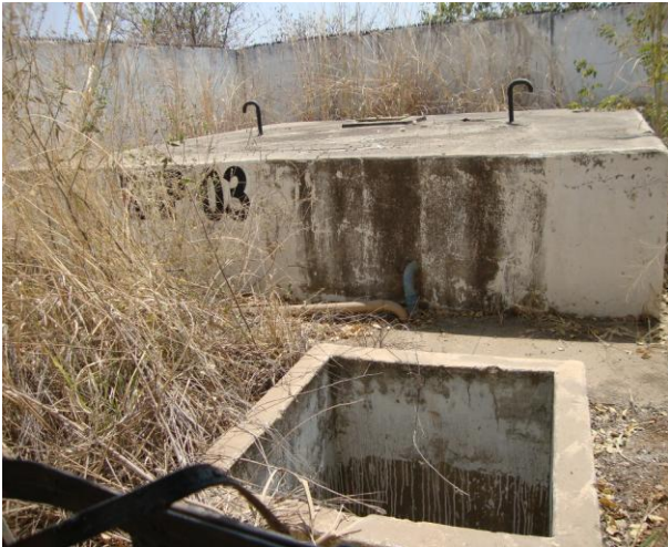
Foto 33 – Vista interna do RAP-03 (desativado).
