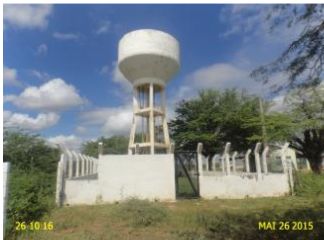
Foto 25 – REL-03: ausência de identificação.
