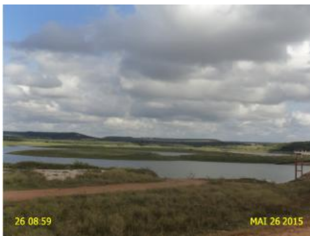
Foto 27 – Captação: ausência de sinalização identificadora.
