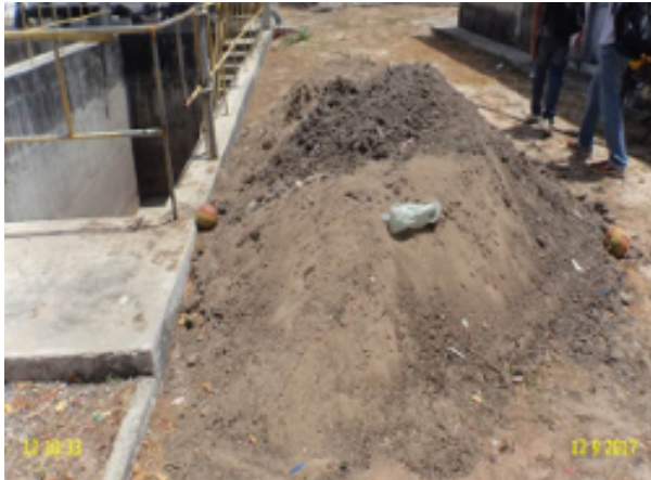
Foto 1 – EEE-Venâncio Raimundo: ausência de leitos de secagem.
