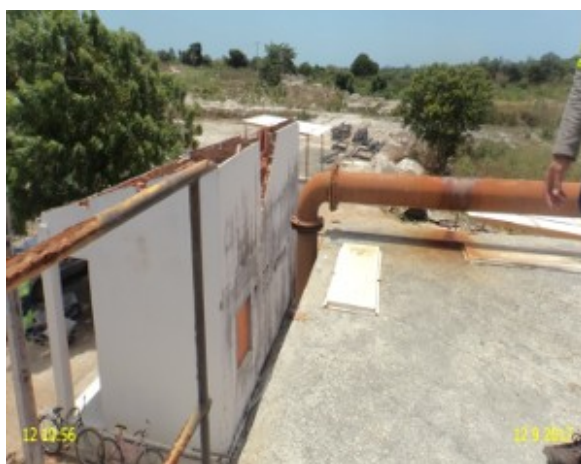
Foto 44 - ETE Dourado: guarda corpo da laje de cobertura do decantador danificado (1).
