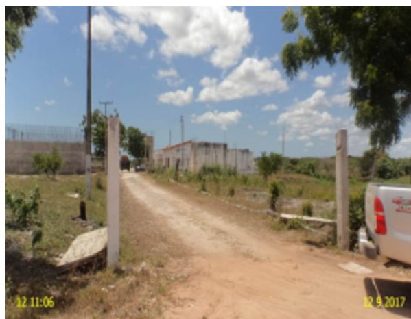
Foto 12 – ETE Dourado: sem portão, ausência de identificação e de delimitação.
