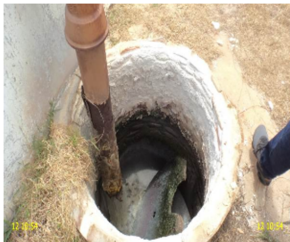
Foto 9 – ETE Dourado: caixa de inspeção na saída do efluente tratado sem tampa.
