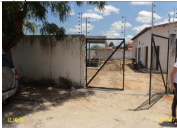
Foto 28 – EEE-Venâncio Raimundo: ausência de identificação.
