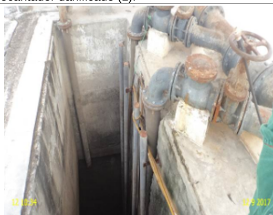
Foto 44 - ETE Dourado: guarda corpo da laje de cobertura do decantador danificado (1).
