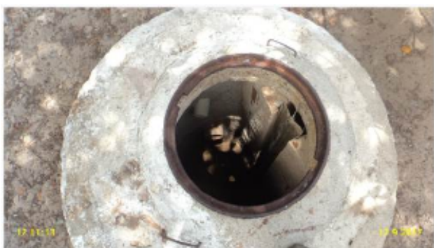
Foto 9 – ETE Dourado: caixa de inspeção na saída do efluente tratado sem tampa.
