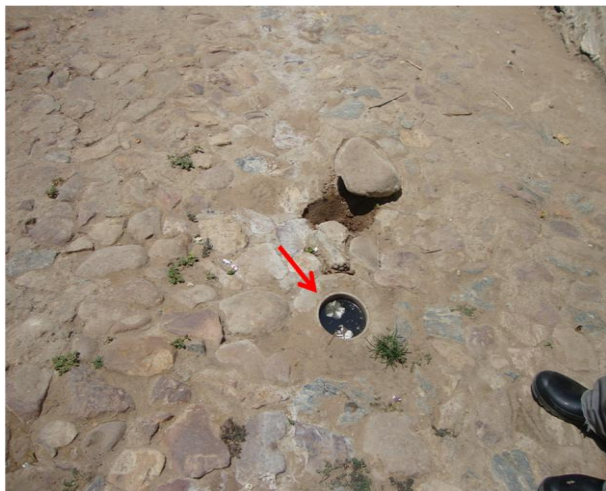
Foto 45 – Registro de descarga na Rua Padre Cícero, nº 61.
