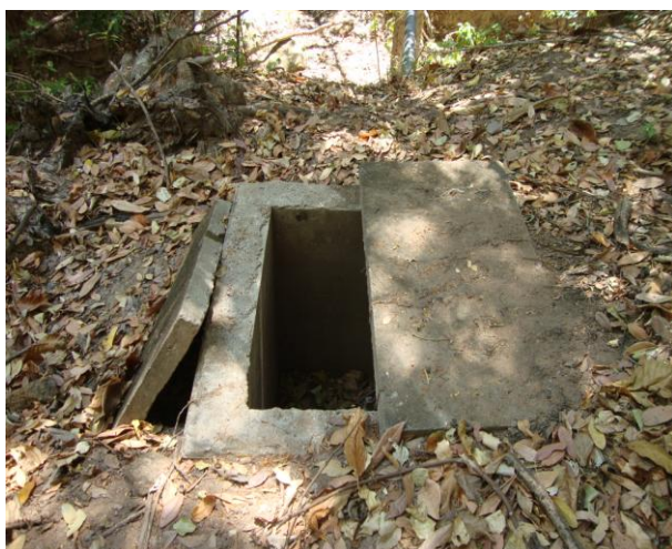
Foto 27 – Caixa de registro aberta da adutora de água bruta das fontes 02 e 03.
