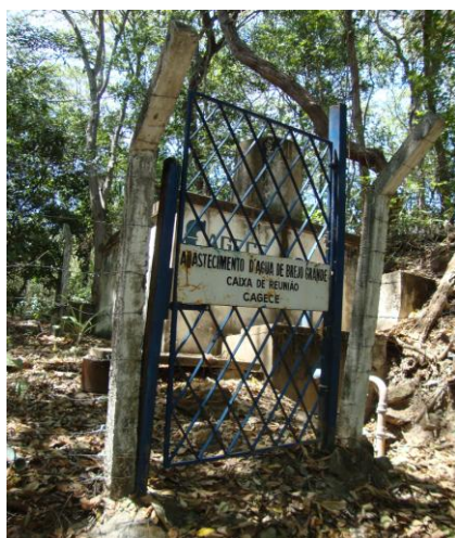
Foto 32 – Entrada do RAP-01.
