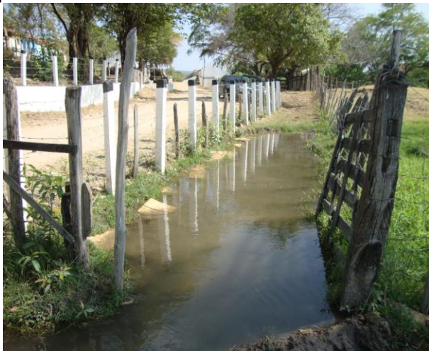
Foto 14 – Área de difícil acesso ao tratamento/RAP-03.
