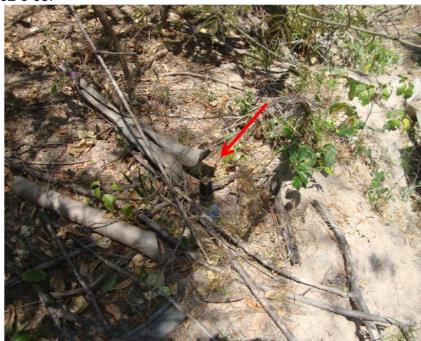
Foto 31 – Registro sem caixa de proteção, próximo as fontes 02 e 03.
