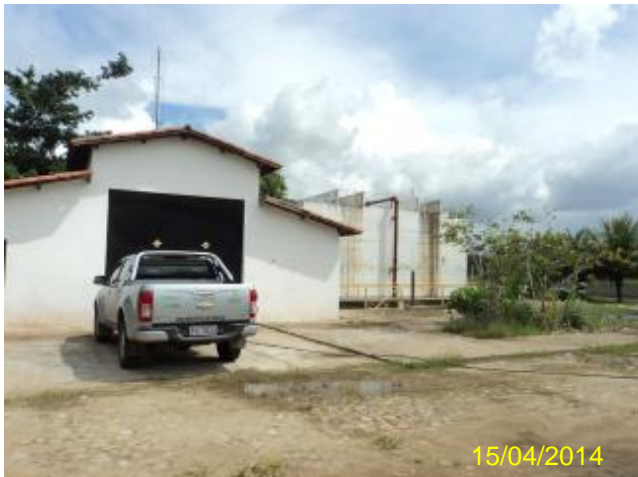
Foto 141 – ETE Pajuçara: pátio externo.
