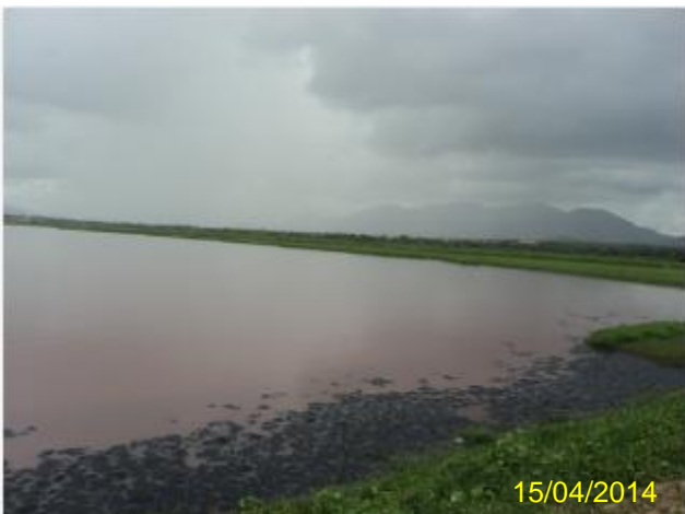
Foto 193 – ETE SIDI: Lagoa de Maturação 1 – crescimento de vegetação e materias sobrenadantes.
