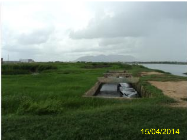
Foto 187 – ETE SIDI: caixa de passagem do esgoto da Lagoa Anaeróbia para a Lagoa Facultativa.
