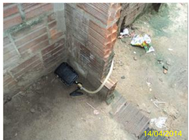
Foto 24 – RDA: Medição contínua de pressão na R. Jacinto Honório, 240.
