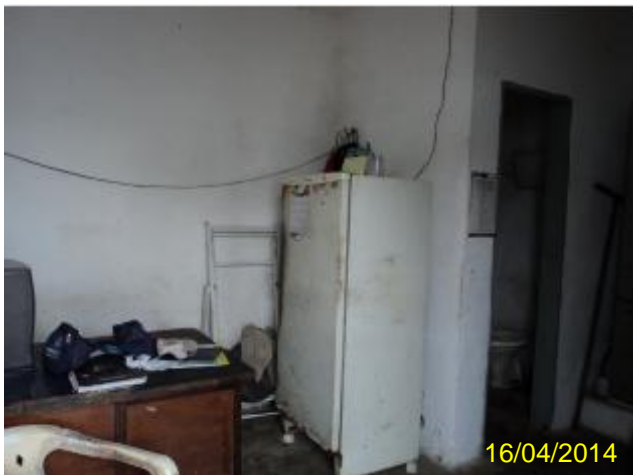
Foto 96 – EEE Conj. Industrial: instalações de apoio do operador.
