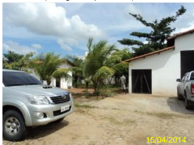
Foto 140 – ETE Pajuçara: pátio externo.
