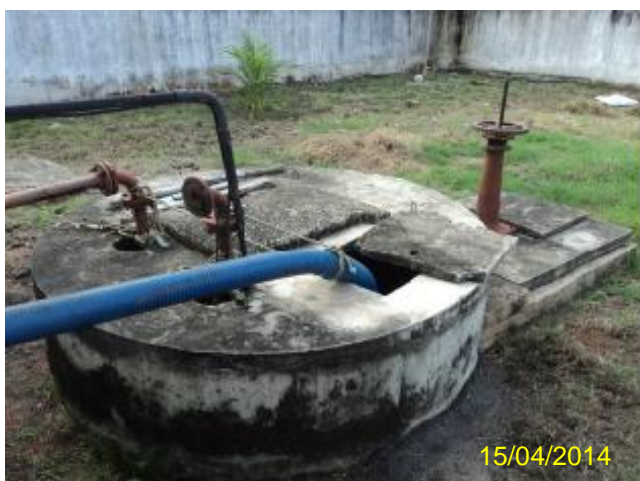
Foto 82 – EEE Barbara de Alencar: poço de sucção. Somente uma bomba em funcionamento.
