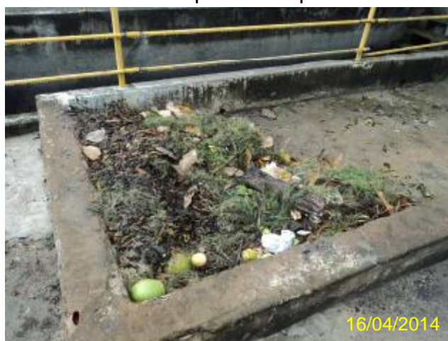
Foto 93 – EEE Conj. Industrial: leito de secagem.
