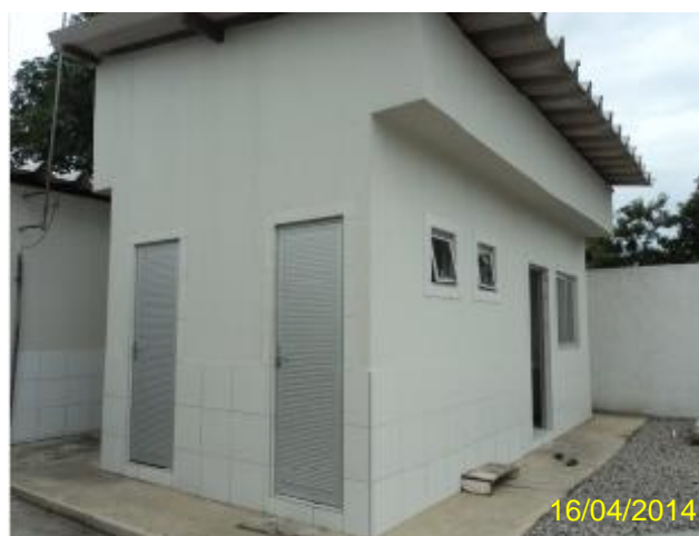
Foto 65 – EEE-03: casa de apoio ao operador.
