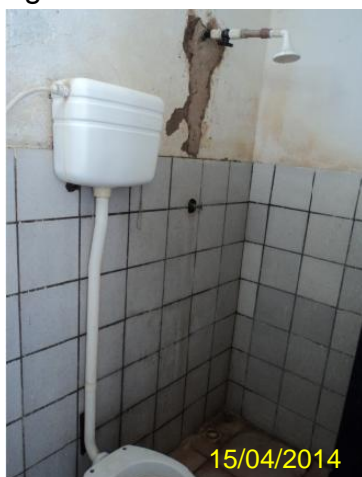
Foto 124 – ETE Maracananzinho: instalações sanitárias da casa de apoio ao operador.
