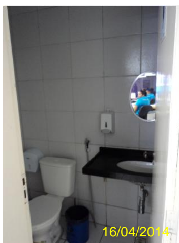
Foto 225 – Loja de atendimento 2: instalações sanitárias.
