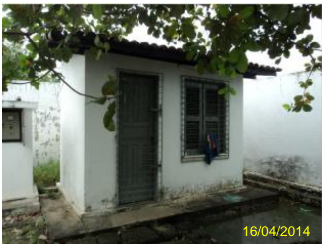
Foto 110 – EEE Novo Oriente: casa de apoio ao operador.
