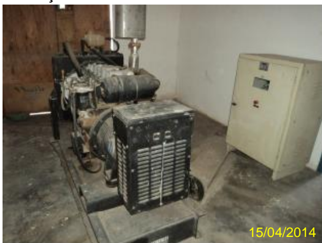
Foto 87 – EEE Barbara de Alencar: grupo gerador de energia elétrica parado – sem bateria.
