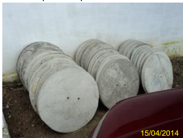
Foto 137 – ETE Nova Vida: tampas para substituição nas caixas de inspeção dos decantados.
