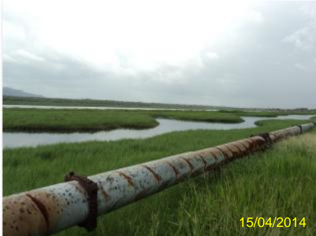
Foto 185 – ETE SIDI: Lagoa Anaeróbia – excesso de vegetação com formação de ilhas.
