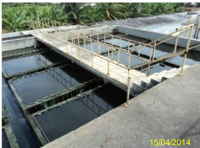
Foto 165 – ETE Pajuçara: FSA 2.
