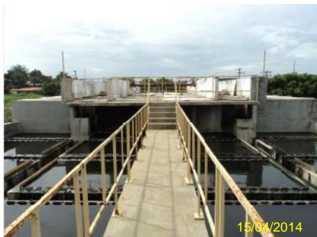
Foto 154 – ETE Pajuçara: vista dos guarda-corpos nas instalações.
