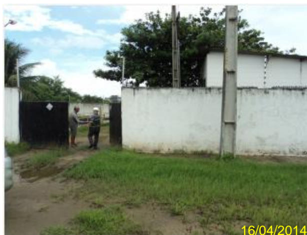
Foto 33 – EEE-01: ausência de identificação.
