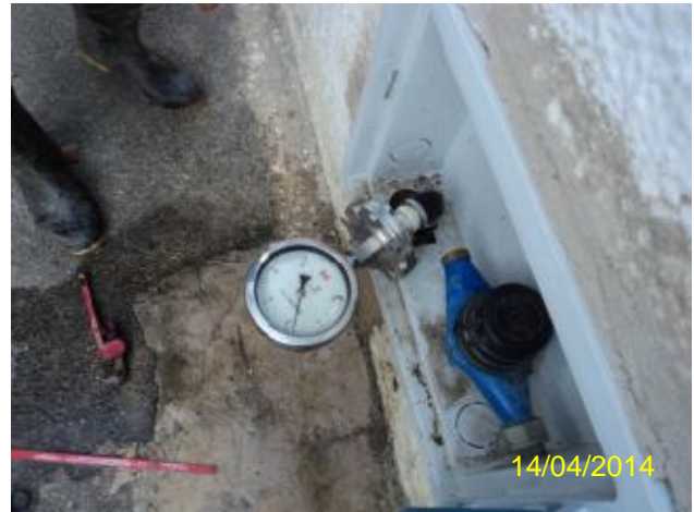
Foto 20 – RDA: medição instantânea de pressão na Av. Luís Pereira Lima, 663 – Escola Santa Luzia – Luzardo Viana.
