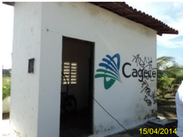
Foto 123 – ETE Maracananzinho: casa de apoio ao operador.
