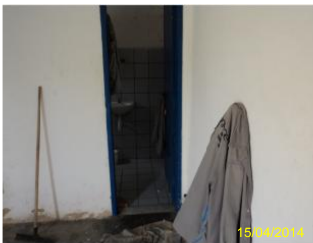
Foto 80 – EEE Bandeirantes: instalações sanitárias.
