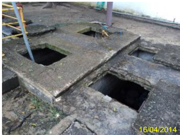
Foto 91 – EEE Conj. Industrial: poço de sucção sem tampa e com apenas uma bomba submersa que não supre a demanda.
