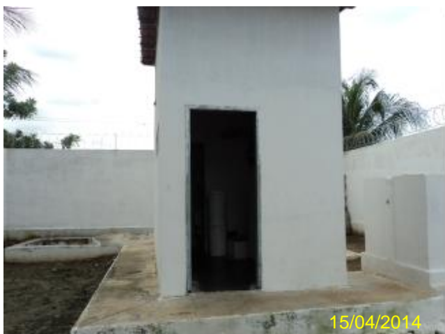
Foto 134 – ETE Nova Vida: casa de apoio ao operador.
