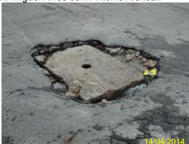
Foto 28 – RDA: registro de descarga na R. 45 com Av. VI.
