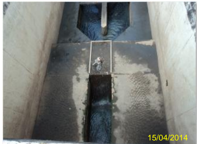
Foto 142 – ETE Pajuçara: gradeamento.
