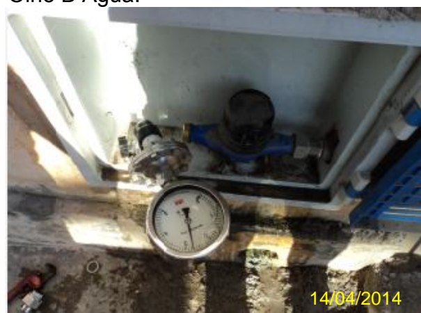
Foto 17 – RDA: medição instantânea de pressão na R. Cap. Justiniano Lopes da Cunha, 334 – Posto de Saúde – Jardim Bandeirante.
