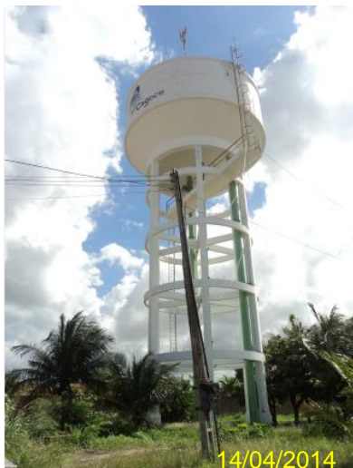
Foto 8 – REL-01: vista geral.
