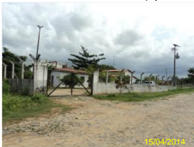
Foto 139 – ETE Pajuçara: área de acesso e ausência de identificação.
