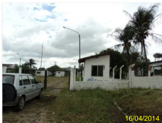
Foto 45 – EEE-02: área de acesso e ausência de identificação.
