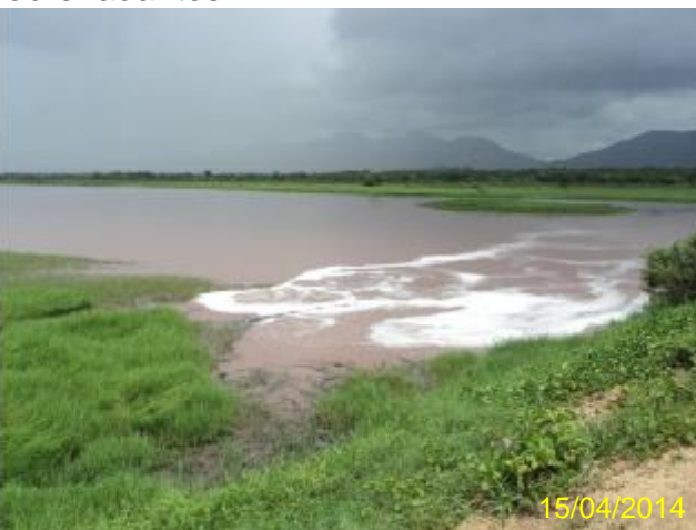
Foto 195 – ETE SIDI: Lagoa de Maturação 2 – coloração e crescimento de vegetação nos taludes.
