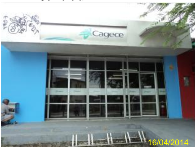
Foto 210 – Loja de atendimento 1: vista externa.
