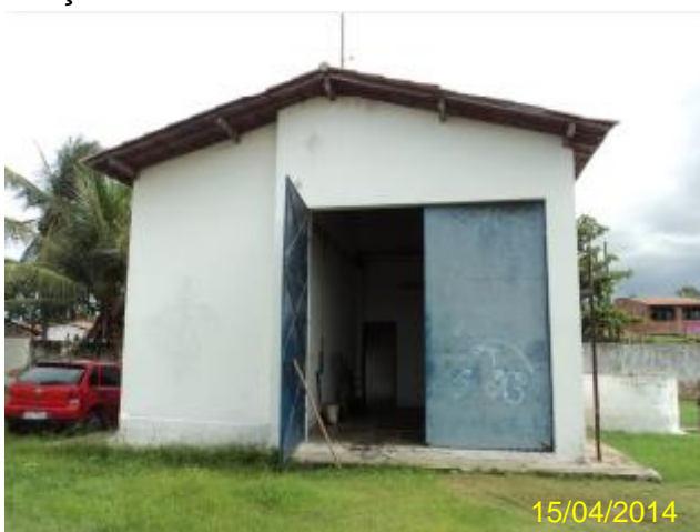
Foto 76 – EEE Bandeirantes: casa de abrigo da elevatória.
