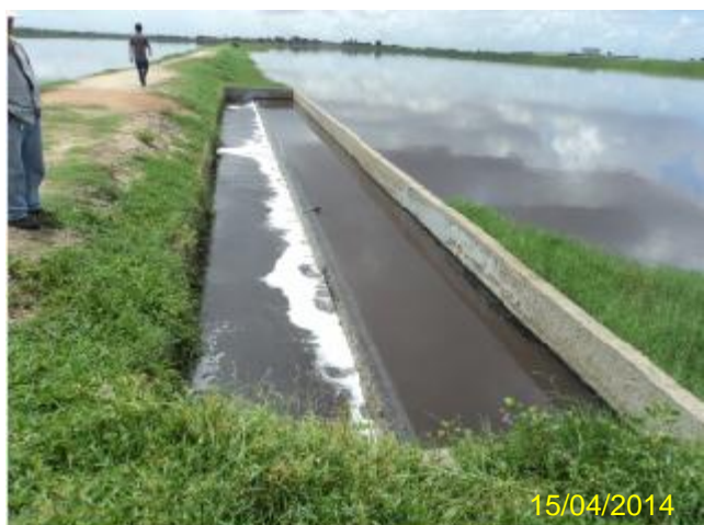
Foto 190 – ETE SIDI: caixa de passagem do esgoto da Lagoa Facultativa para a Lagoa de Maturação 1.
