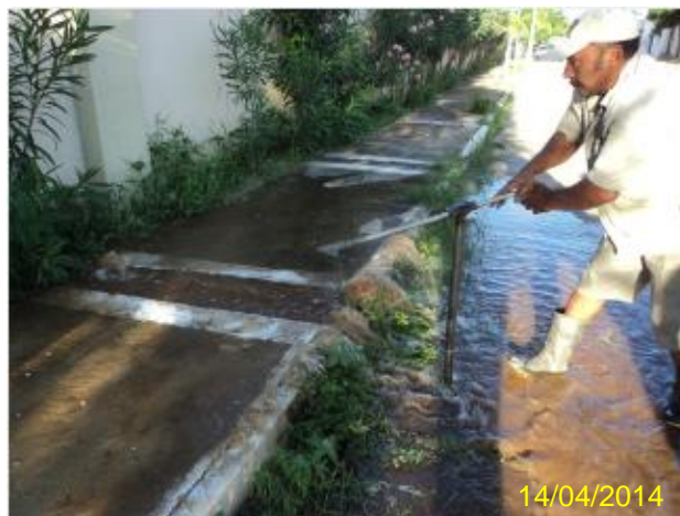
Foto 26 – RDA: realização de descarga na R. Miguel Alves com Antônio Alencar.
