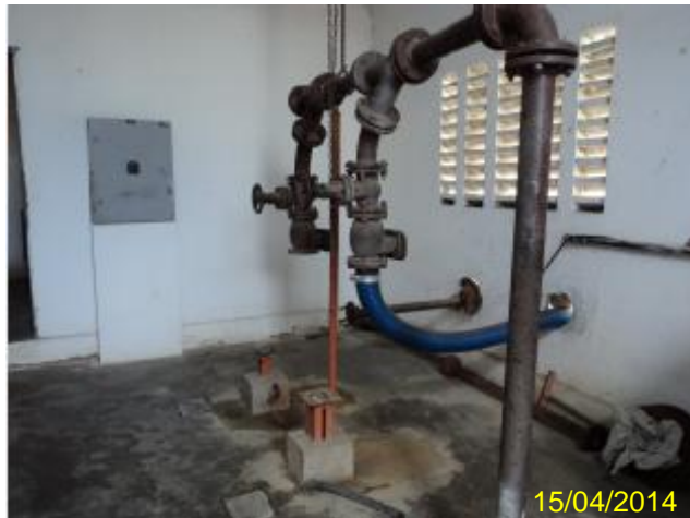
Foto 85 – EEE Barbara de Alencar: tubulações da bomba submersa.
