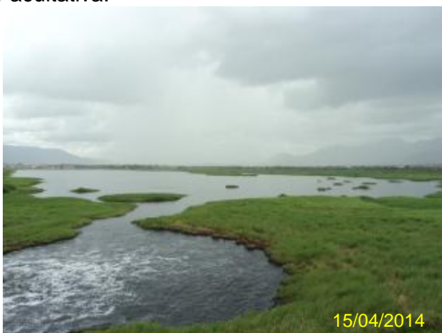
Foto 189 – ETE SIDI: Lagoa Facultativa – excesso de vegetação com formação de ilhas.
