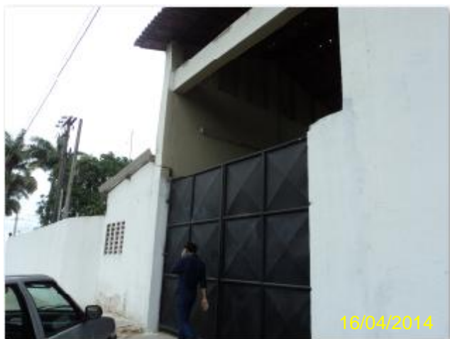
Foto 53 – EEE-03: área de acesso e ausência de identificação.
