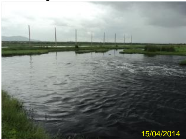
Foto 183 – ETE SIDI: Lagoa Anaeróbia – vista geral.
