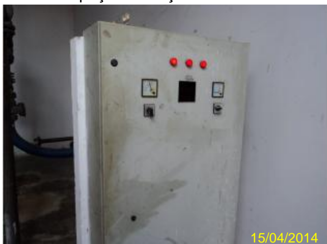
Foto 86 – EEE Barbara de Alencar: quadro de comando sem horímetro.
