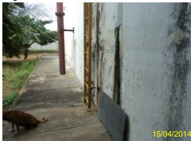
Foto 162 – ETE Pajuçara: DAFA 2 – escada de acesso.
