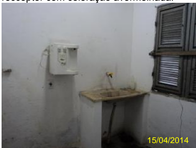
Foto 201 – ETE SIDI: casa de apoio ao operador.
