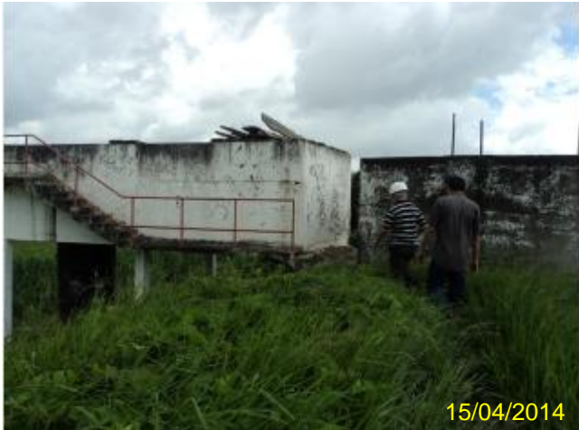
Foto 179 – ETE SIDI: instalações de chegada do esgoto.
