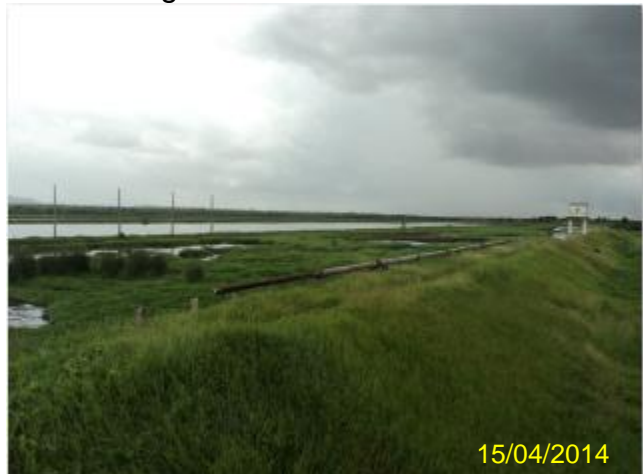
Foto 184 – ETE SIDI: Lagoa Anaeróbia – excesso de vegetação.
