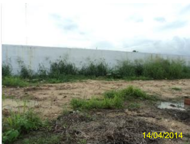
Foto 12 – REL-01: RAP-01 desativado e condições de manutenção da área.
