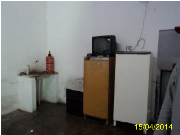
Foto 203 – ETE SIDI: casa de apoio ao operador.
