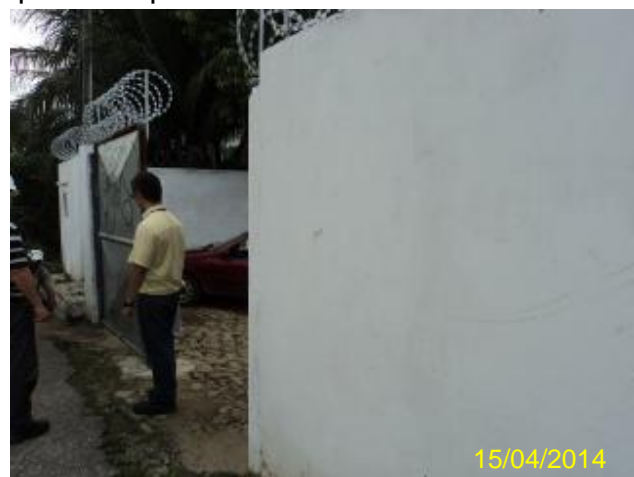
Foto 125 – ETE Nova Vida: área de acesso e ausência de identificação.
