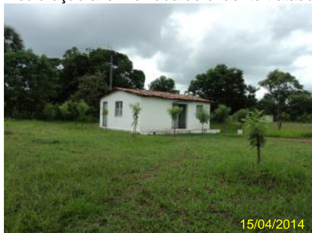
Foto 200 – ETE SIDI: casa de apoio ao operador.
