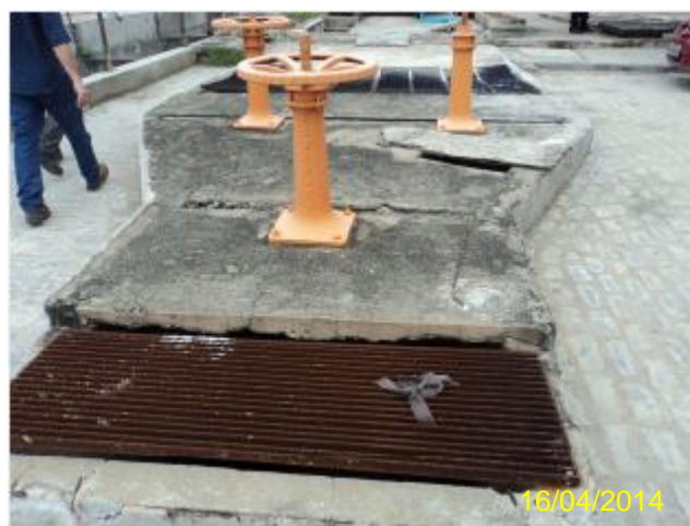
Foto 59 – EEE-03: poço de sucção.
