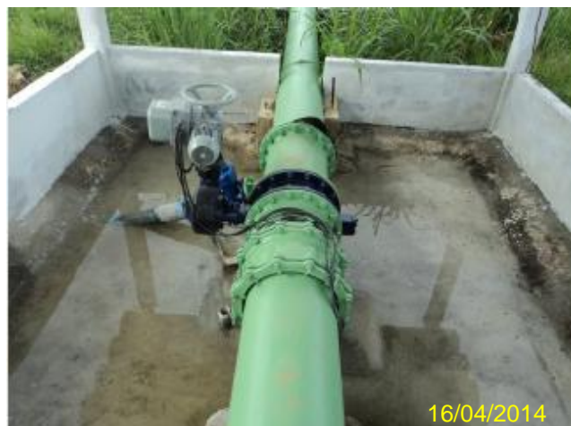
Foto 6 – AAT: válvula redutora de pressão.
