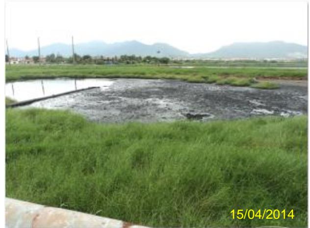
Foto 186 – ETE SIDI: Lagoa Anaeróbia – excesso de vegetação e acúmulo de materiais sobrenadantes.
