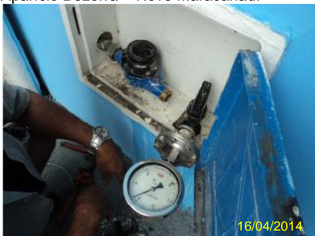
Foto 23 – RDA: medição instantânea de pressão na Av. Central, 120 – Escritório da CAGECE.
