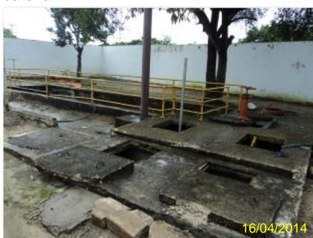
Foto 89 – EEE Conj. Industrial: vista geral.
