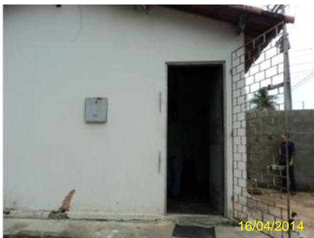
Foto 104 – EEE Novo Maracanaú: casa de apoio ao operador.
