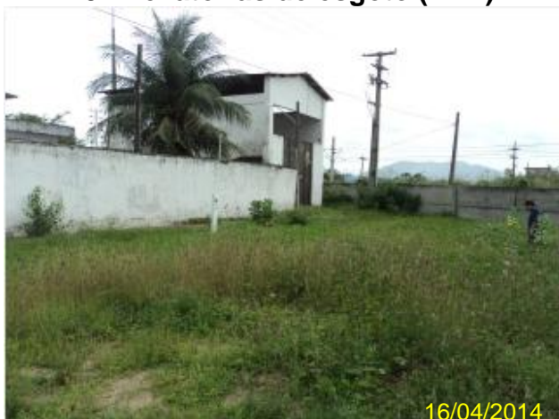
Foto 32 – EEE-01: área de acesso coberta por vegetação e alagada.
